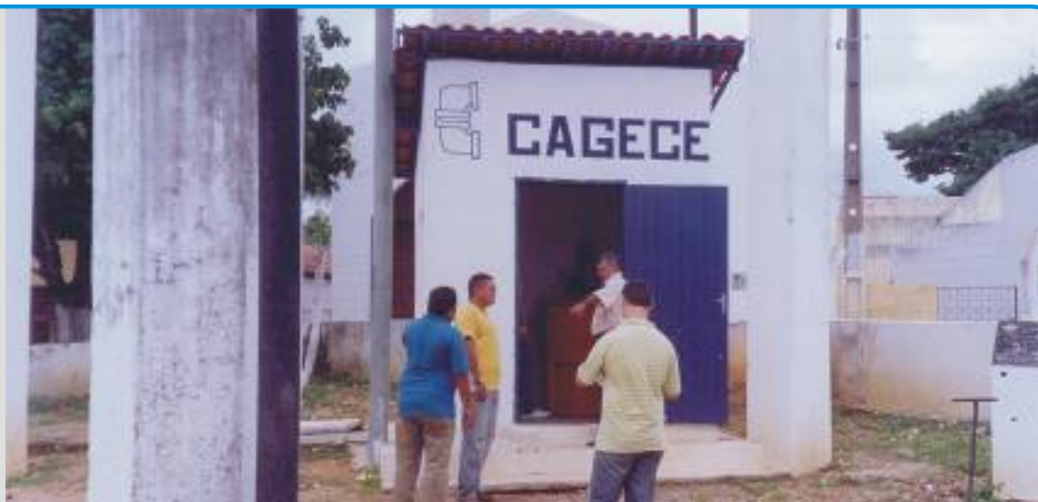
Equipe da Arce verificando as condições de reservação.
