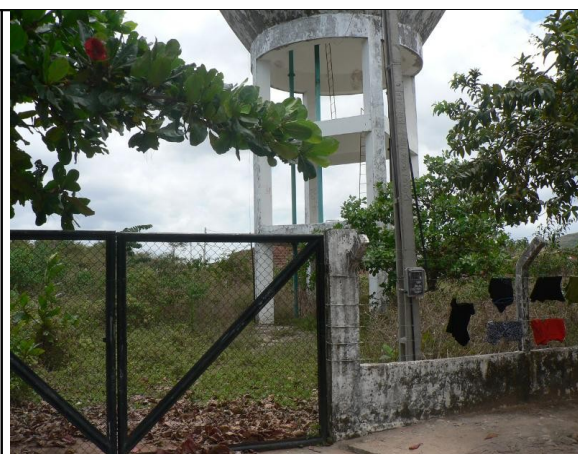
Foto 09 – REL-02: Portão de acesso fechado sem cadeado.
