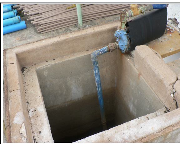
Foto 06 – RAP-01: abertura de inspeção sem tampa.
