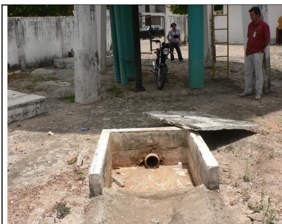
Foto 08 – REL-01: Tubulação de descarga de fundo.
