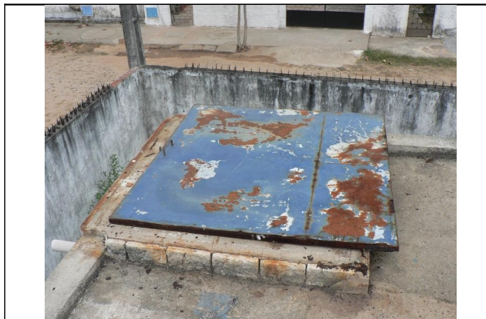
Foto 07 – RAP-01: Tampa em processo de corrosão.
