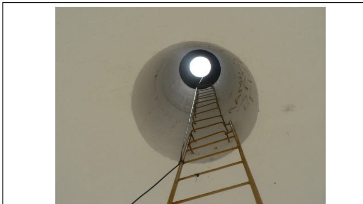
Foto 10 – REL-02: Abertura superior sem tampa
