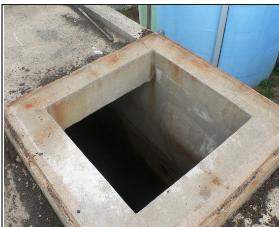
Foto 05 – RAP-01: abertura de inspeção sem tampa.
