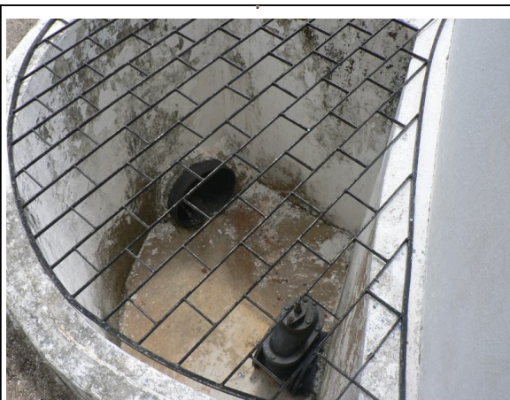
Foto 06 – RAP-01: Tubulação de descarga de fundo.
