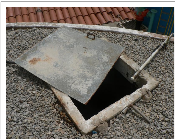
Foto 05 – RAP-01: abertura de inspeção sem fechamento hermético da tampa.
