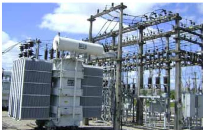
Subestação da Coelce, em que se visualiza um transformador de potência.
