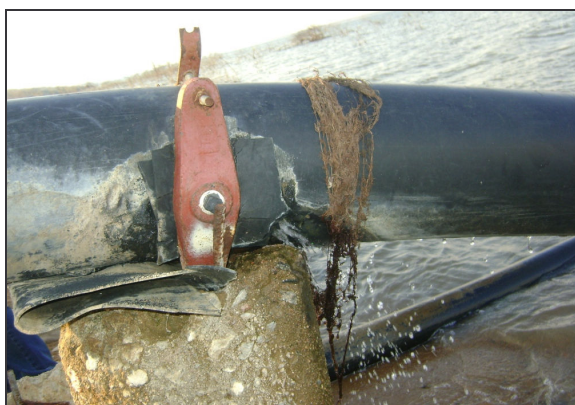
Foto 5 – Tubulação de recalque com vazamento na altura do apoio.
