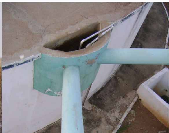
Foto 32 – RAP-02: abertura superior da caixa de entrada da água tratada sem tampa.
