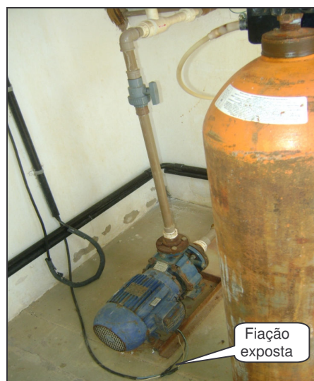
Foto 25 – Bomba dosadora ao lado do cilindro de cloro gasoso.
