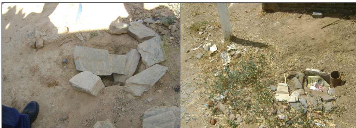
Foto 44 – Registro de descarga sem caixa na Rua 7 de Setembro a 1.900m do reservatório.
