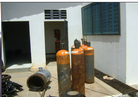
Foto 23 – Cilindros de cloro armazenados ao ar livre.
