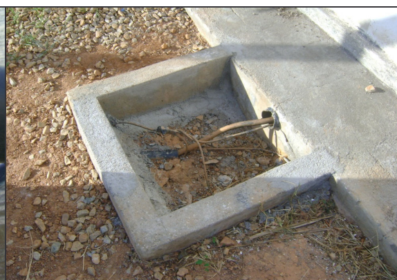
Foto 6 – Fiação exposta na área da casa do quadro de comando.
