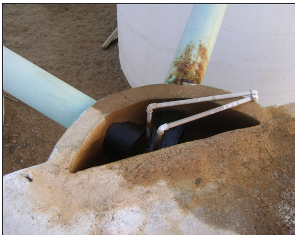
Foto 31 – RAP-01: abertura superior da caixa de entrada da água tratada sem tampa.
