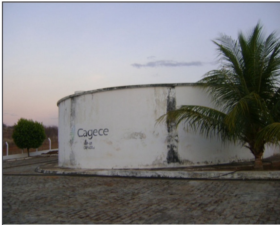
Foto 27 – RAP-01: pintura deteriorada.
