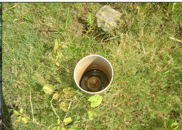
Foto 43 – Registro de descarga sem caixa na Rua Pelo Sinal a 2.000m do reservatório.
