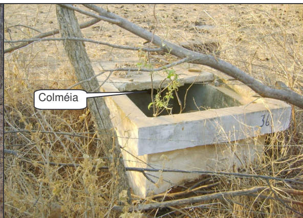
Foto 39 – Caixa de inspeção nº 36 da adutora de água bruta apresentando ausência de tampa e colméia em seu interior.
