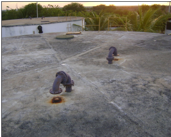
Foto 29 – RAP-01: tubulações de ventilação não teladas.
