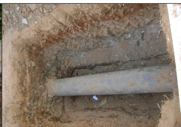
Foto 13 – Tubulação de lavagem de filtros: local de instalação de um novo macromedidor.
