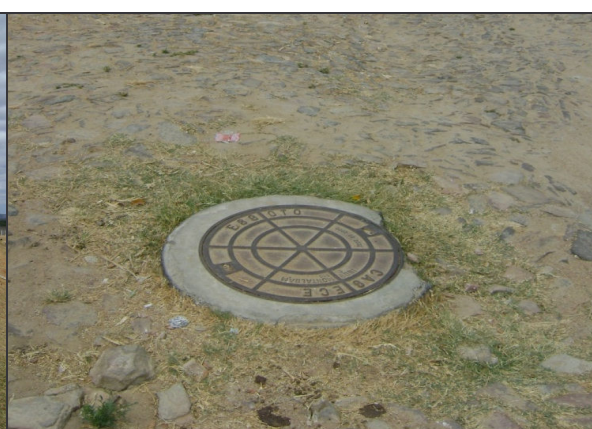
Foto 50 – Poço de visita da rede coletora do SES de Independência.
