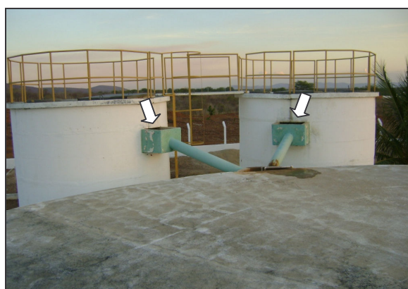
Fotos 16 e 17 – Aberturas superiores sem proteção na saída dos filtros.
