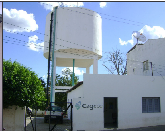
Foto 34 – REL-01: ausência de guarda-corpo na laje de cobertura.
