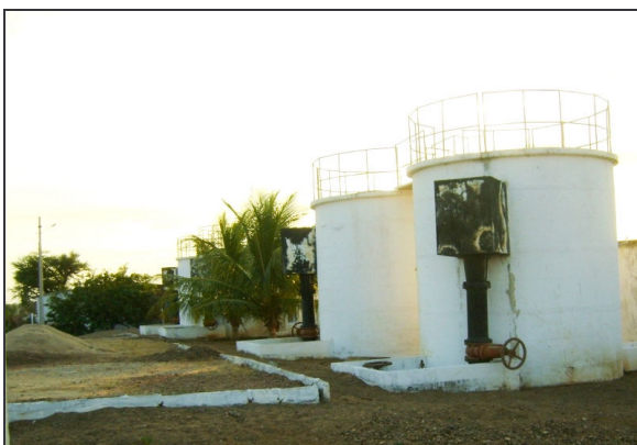
Foto 14 – Vista geral dos filtros.
