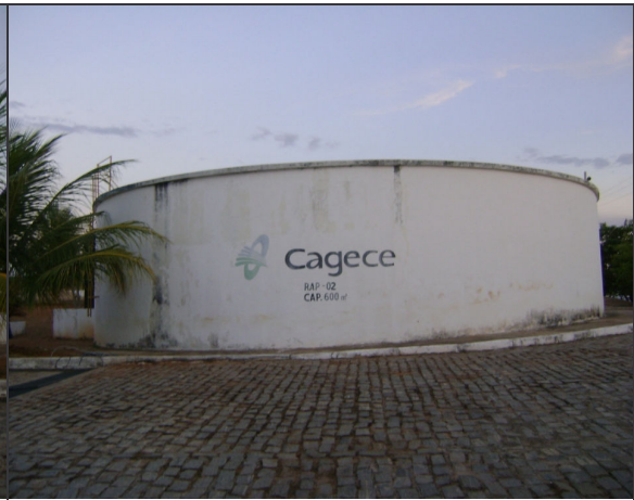
Foto 28 – RAP-02: pintura deteriorada.
