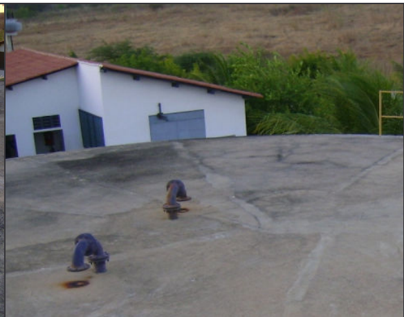
Foto 30 – RAP-02: tubulações de ventilação não teladas.
