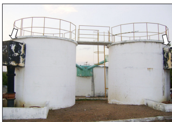
Fotos 18 e 19 – Aberturas superiores sem proteção na saída de extravasamento dos filtros.
