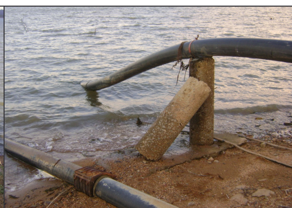
Foto 4 – Apoios de concreto nas tubulações de recalque da captação.
