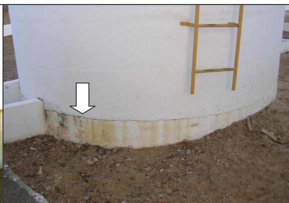
Foto 15 – Filtro 1 com rachadura na base.
