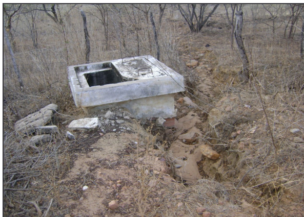
Foto 38 – Caixa de inspeção de ventosa da adutora de água bruta danificada e com tampa quebrada.
