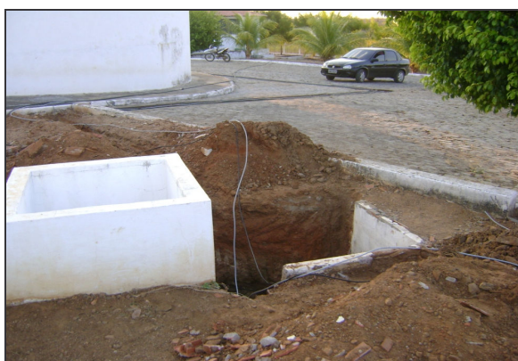
Foto 12 – Adutora de chegada na ETA: local de instalação de um novo macromedidor.
