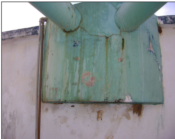
Foto 33 – RAP-01: vazamento na estrutura de entrada da tubulação dos filtros.
