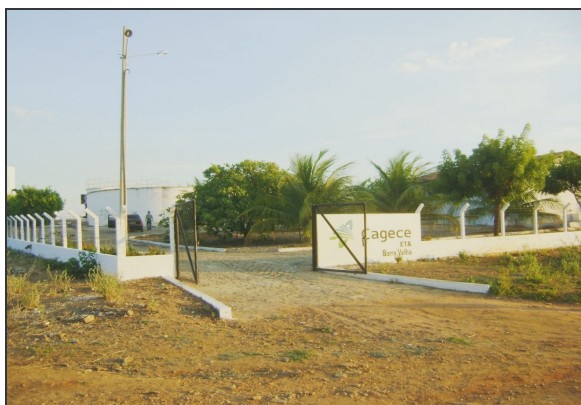
Foto 10 – ETA do SAA de Independência.
