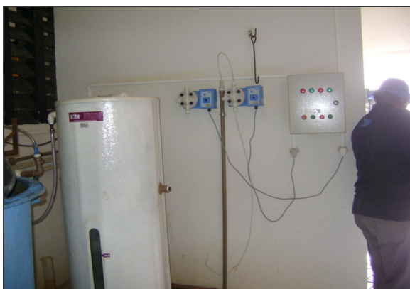
Foto 22 – Sistema de fluoretação.
