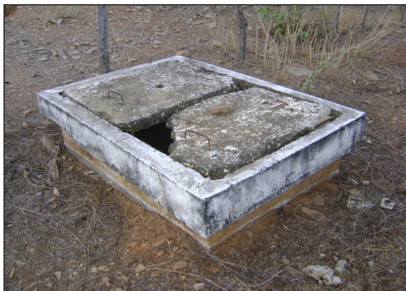
Foto 37 – Caixa de inspeção nº 19 da adutora de água bruta apresentando tampa quebrada.
