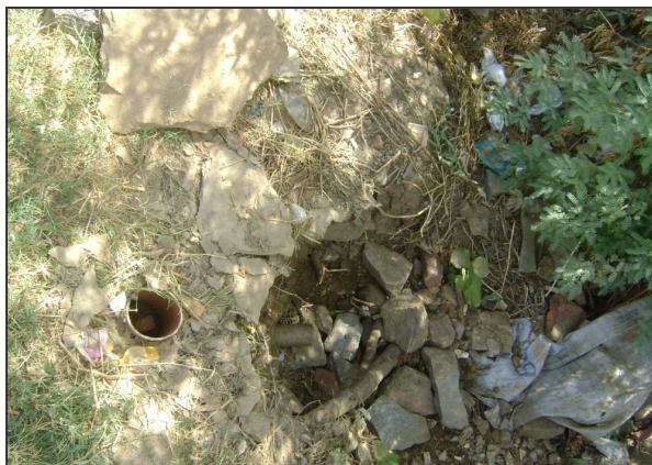
Foto 42 – Registro de descarga sem caixa na Rua Pelo Sinal a 1.300m do reservatório.
