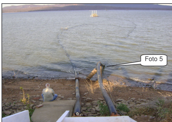
Foto 3 – Captação: flutuante e tubulações de recalque.
