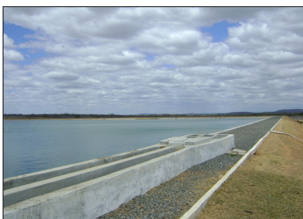
Foto 49 – ETE do SES de Independência.
