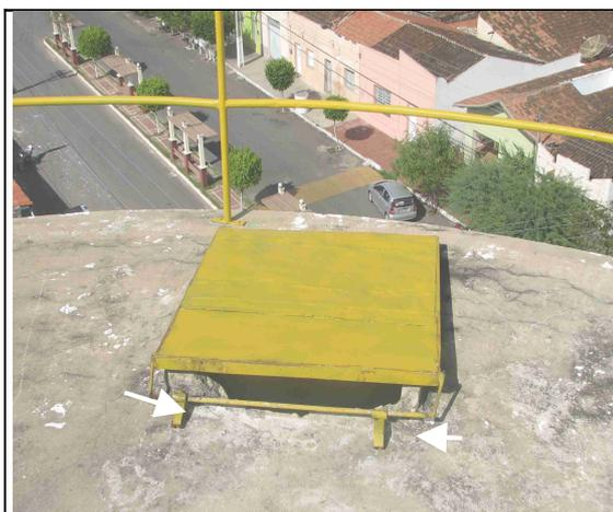
**Foto 29** – REL-02: Borda da inspeção do reservatório danificada e tampa não instalada.
