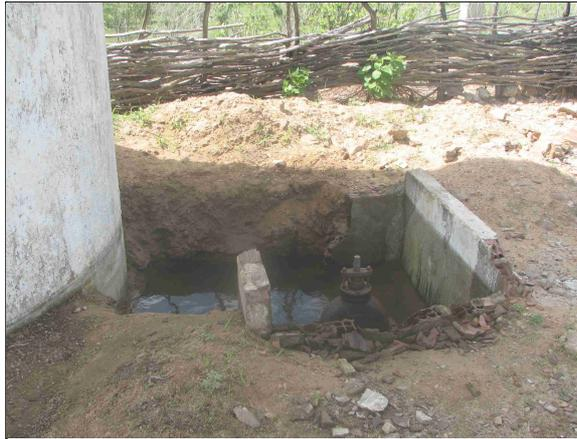
**Foto 36** – Registro da torre de equilíbrio com vazamento e caixa de proteção danificada.
