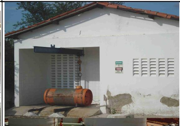
**Foto 12** – Cilindro de cloro parcialmente coberto e com incidência direta da luz solar.
