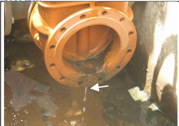
**Foto 6** – Vazamento do registro de descarga do filtro 2.
