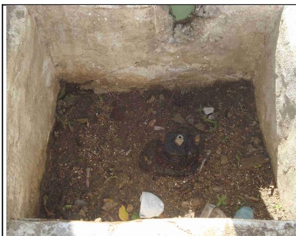
**Foto 32** – Vazamento no registro de saída do REL-02.
