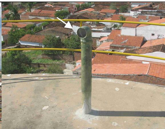
**Foto 31** – REL-02: tubulação de ventilação sem tela de proteção.
