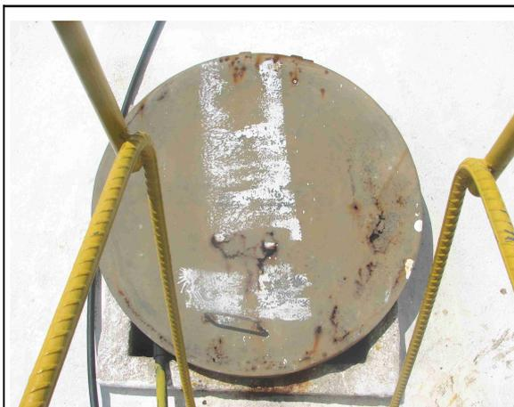
**Foto 26** – Tampa de inspeção improvisada do REL-01.
