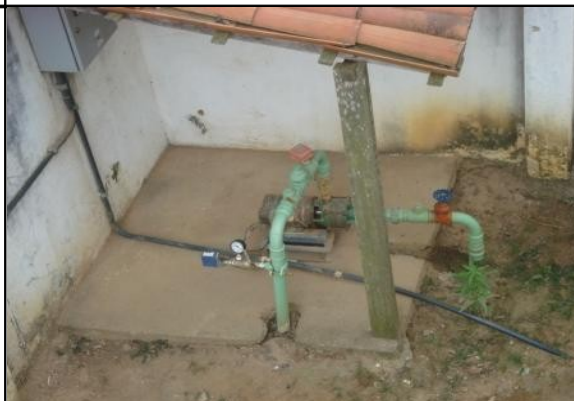
Foto 20 – EEAT-01 sem identificação e sem bomba reserva.
