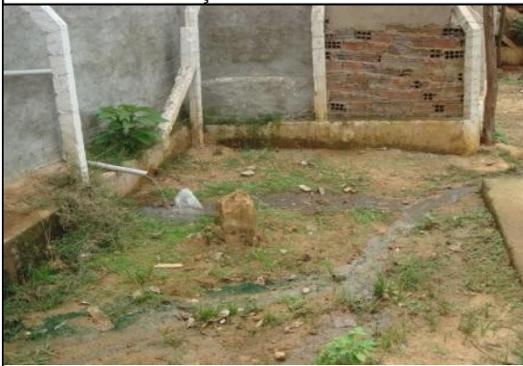
Foto 25 – Lançamento de esgoto na área da EERD-01.
