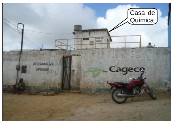
Foto 12 – Casa de química na laje do RAP-01.
