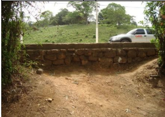
Foto 7 – Acesso a área dos poços PA-01 e PT-02, sem degraus.
