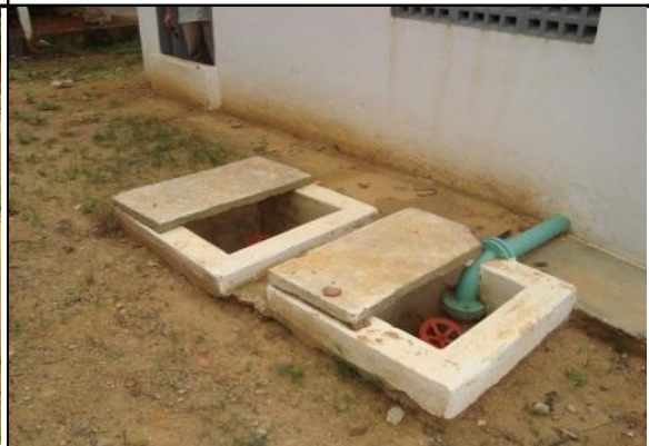
Foto 26 – Caixas de registros com tampas incompletas na EERD-01.
