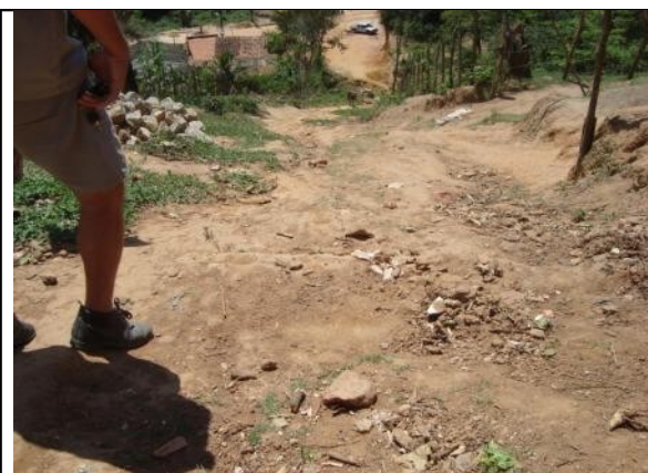
Foto 37 – Registro de descarga totalmente encoberto na Rua Mussum 1 em frente ao nº 202.
