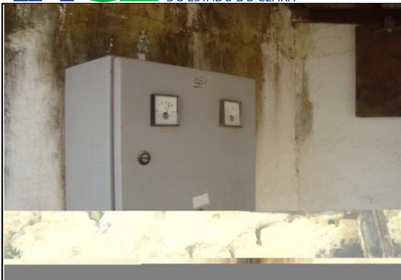
Foto 21 – Quadro de comando da EEAT-01 sem horímetro.
