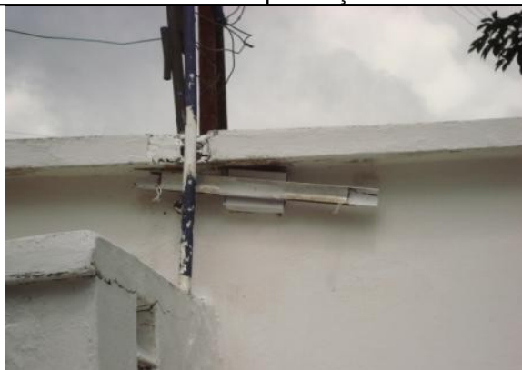
Foto 11 – Entrada da alimentação elétrica da fonte.
