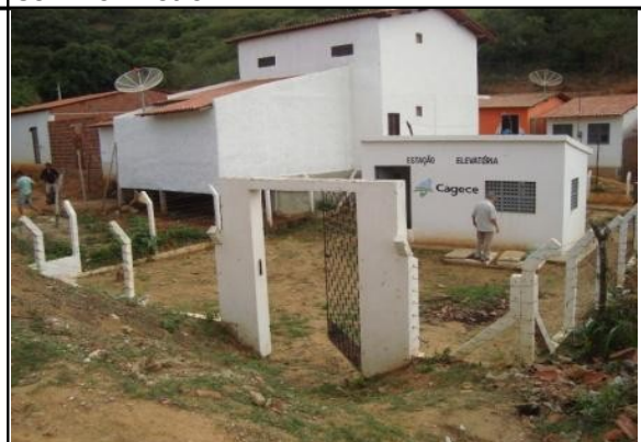
Foto 24 – Rampa de acesso a EERD-01.
