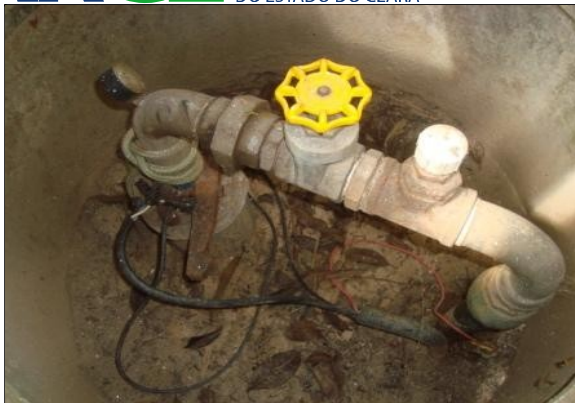
Foto 9 – Caixa de proteção do PT-03.
