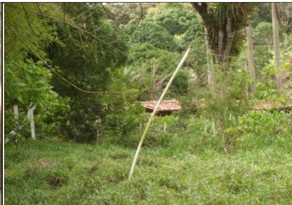
Foto 10 – Cabeamento aéreo da alimentação de força do PT-03.
