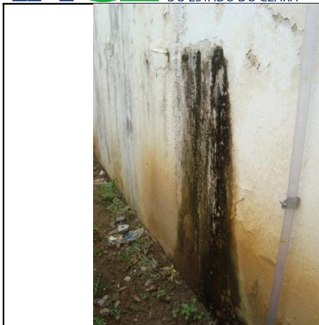
Foto 30 – RAP-01: pintura deteriorada e sinais de vazamento.
