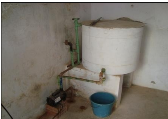
Foto 13 – Estação de cloro, tanque de dosagem, na casa de química.
