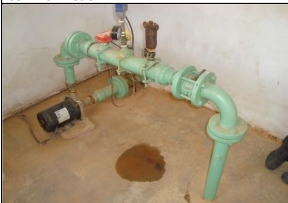
Foto 23 – Conjunto motor-bomba da EERD-01 sem base de fixação e sem reserva.
