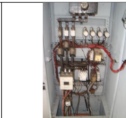
Foto 16 – Quadro de comando da EEPA-01.
