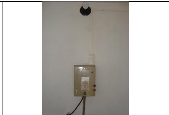
Foto 22 – Quadro de comando da EERD-01 sem horímetro.
