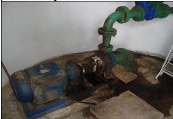
Foto 17 – Bomba da EEPA-01 com vazamento e sem a proteção da junção.
