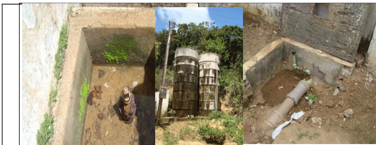
Foto 34 – RAP-02 e RAP-03: vista geral. registro de saída, caixa de proteção inundada.
