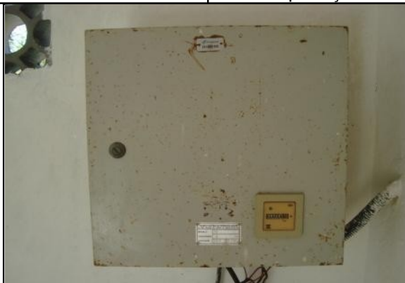
Foto 29 – Quadro de comando da EEPT-01.
