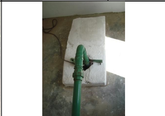
Foto 8 – Poço PT-01 sem tampa de proteção.
