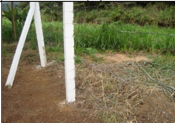
Foto 6 – Cerca com arame farpado danificado.
