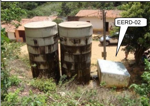
Foto 27 – EERD-02 sem identificação.
