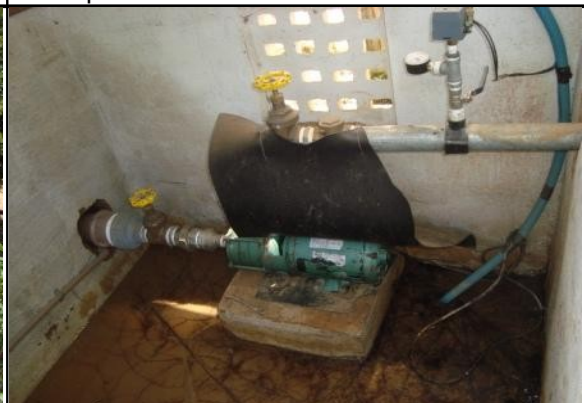
Foto 28 – EERD-02 sem bomba reserva e sem base de fixação.
