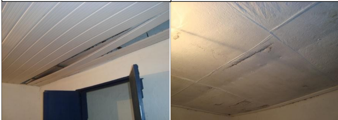
Foto 41 – Forro do teto da sala atrás da recepção.
