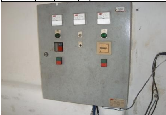
Foto 19 – Quadro de comando da EEFT-01.
