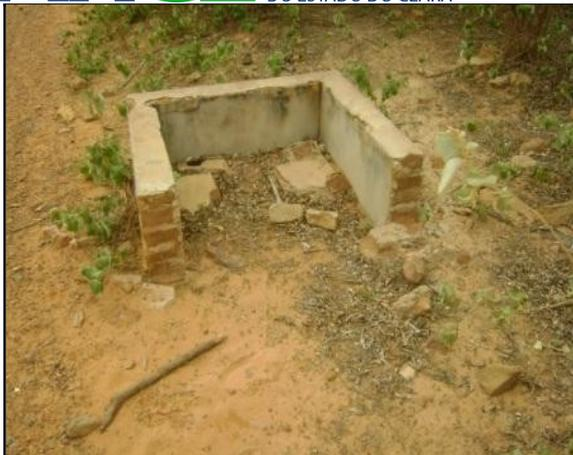
**Foto 44** – Caixa de proteção de registro de descarga – Distrito Bom Princípio.
