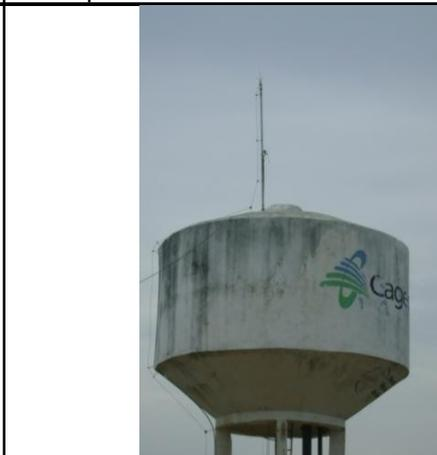
**Foto 36** – REL-01: sem guarda corpo na laje de cobertura.
