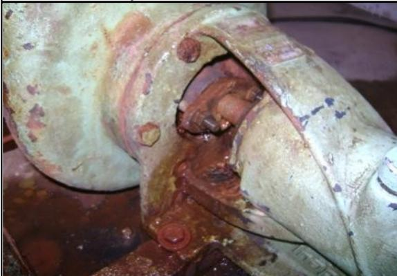
**Foto 21** – Sinais de vazamento na bomba da EEAT-02.
