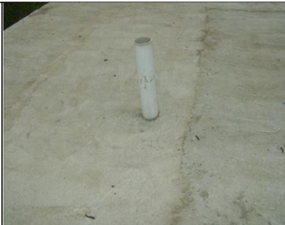
**Foto 34** – RAP-02: tubulação de ventilação inadequada.
