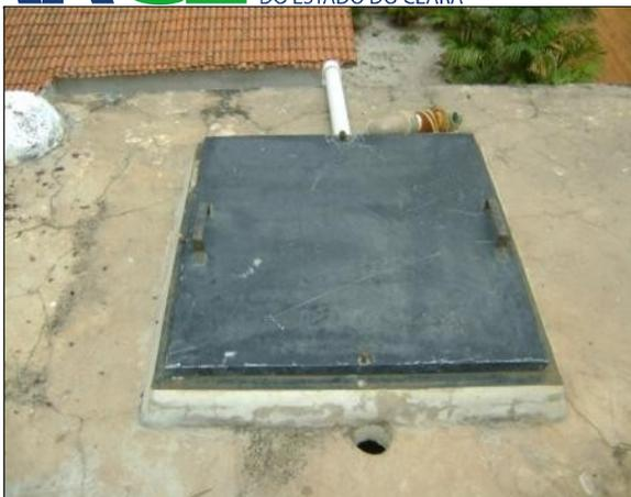
**Foto 39** – REL-03: sem tubulação de ventilação.
