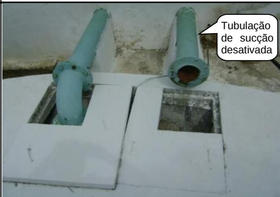
**Foto 8** – Vedação das tubulações de sucção do PA-01.
