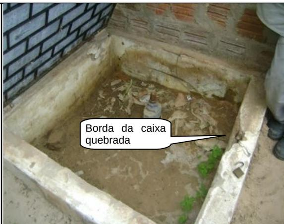
**Foto 40** – REL-03: caixa de proteção de registro quebrada.
