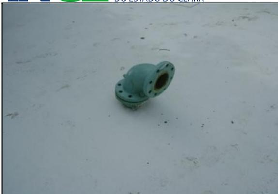
**Foto 5** – Tubulação de ventilação da laje do PA-01 inadequada.
