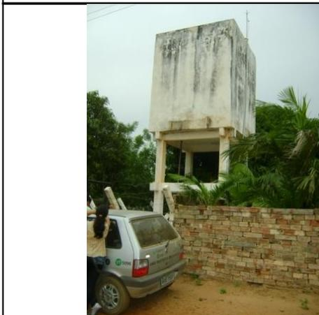
**Foto 37** – REL-03: sem identificação e pintura deteriorada.
