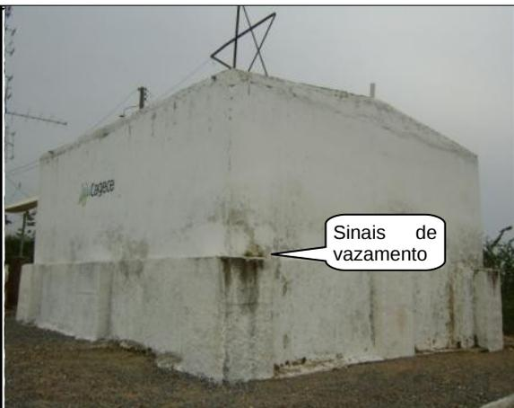
**Foto 30** – RAP-02: sinais de vazamento no corpo na laje e pintura deteriorada.
