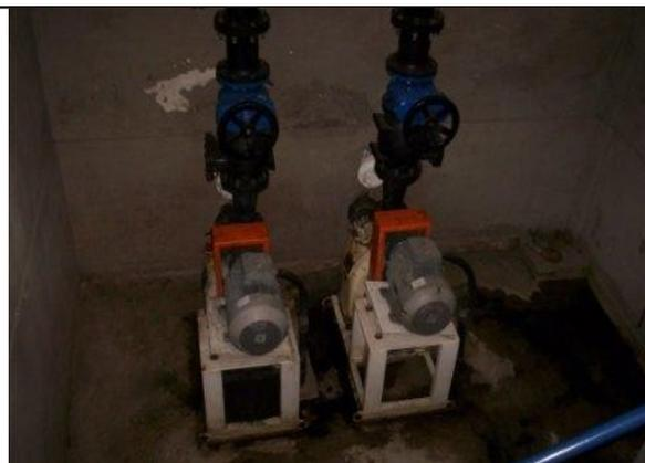
Foto 49 – Conjuntos mototores–bomba da EEE-01 do SES de Poranga.
