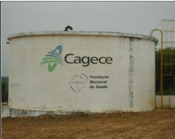
**Foto 28** – RAP-01: sem identificação e pintura deteriorada.
