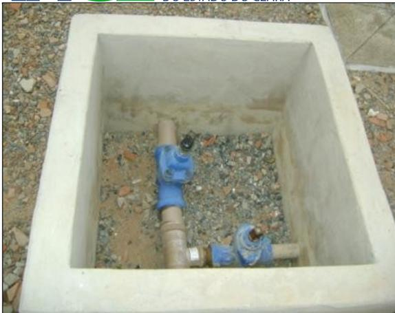
**Foto 33** – RAP-02: caixa proteção de registro sem tampa.
