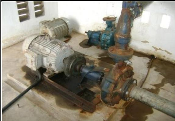
**Foto 25** – Sinais de vazamento na bomba da EEAT-03.
