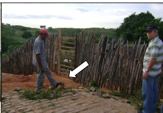
Foto 39 – Registro de descarga, Rua Antônio Clésio T. Moura (s/ caixa).
