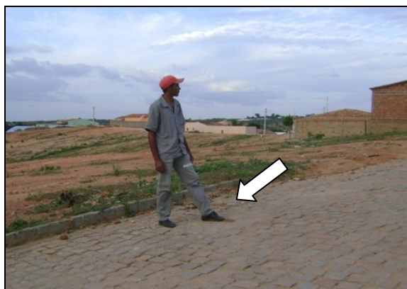
Foto 40 – Registro de descarga, Rua Cel. Celso Alves (s/ caixa).
