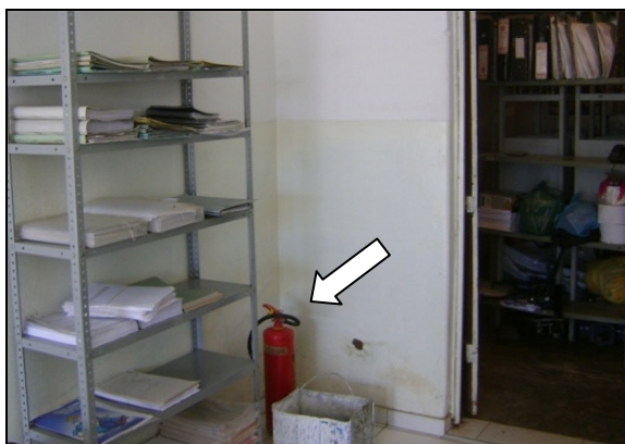
Foto 41 – Extintor de incêndio do escritório.
