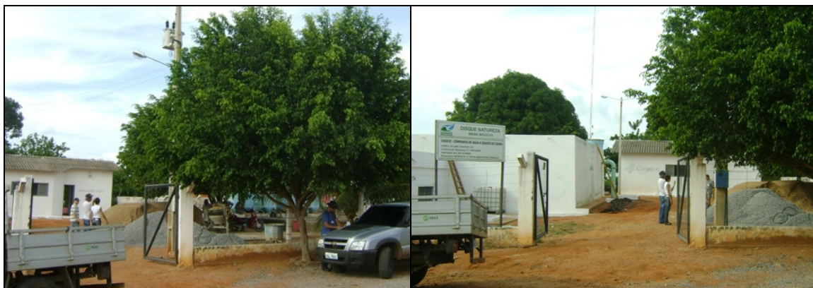
Fotos 5 e 6 – Entrada da ETA sem pintura e identificação.
