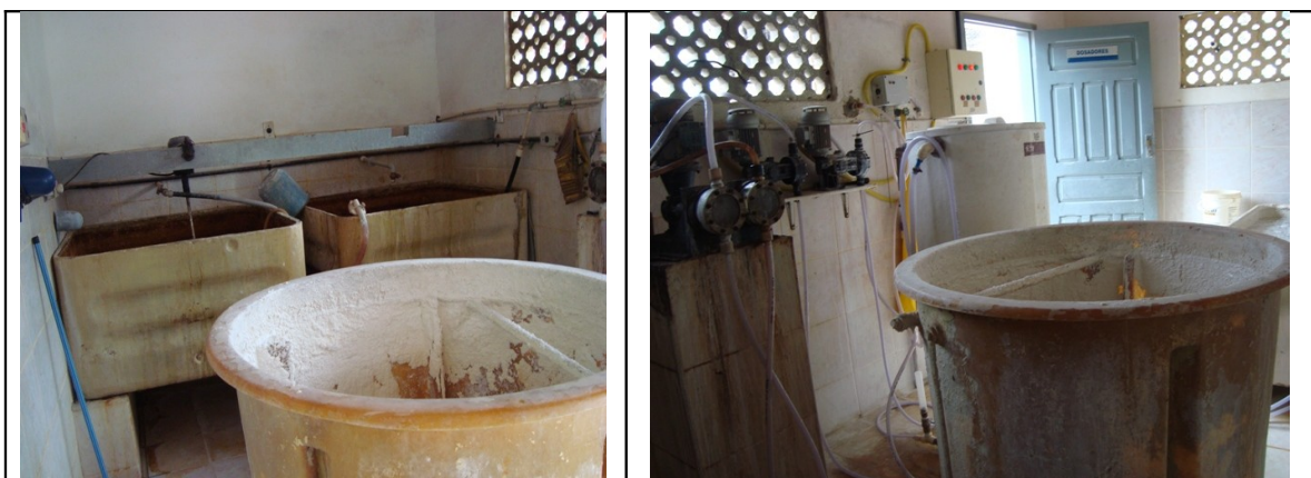
Fotos 10 e 11 – Detalhes da casa de química
