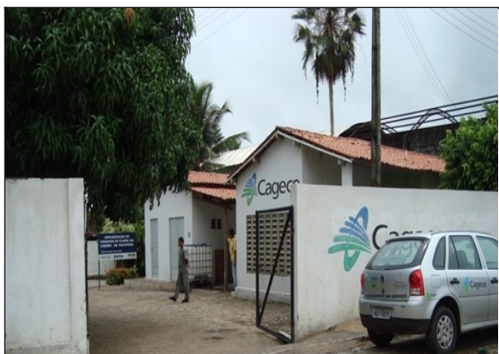
Foto 01 – Vista parcial da ETA do SAA de Pacatuba.
