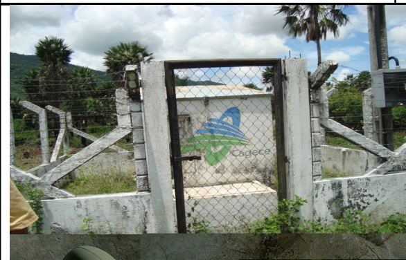
Foto 16 – Vista do EEAT-01
