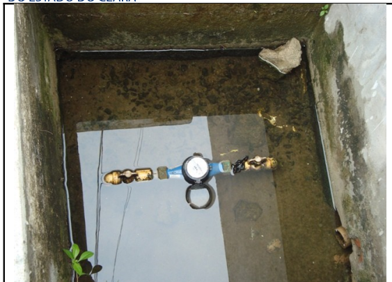
Foto 07 – Macro-medidor proporcional na saída dos filtros está submerso
