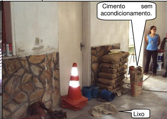
**Foto 26** – Falta de higiene e cimento sem acondicionamento no almoxarifado de Aracati.
