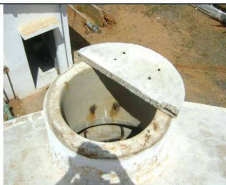
Foto 24 – Tampa aberta no RAP-01
