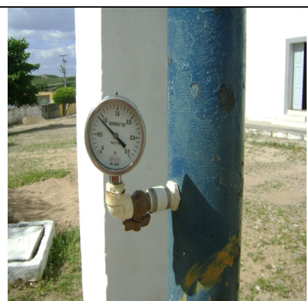
Foto 28 – Medição de nível do REL-01
