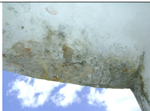
Fotos 32 e 33 – REL-02 – sinais de vazamento
