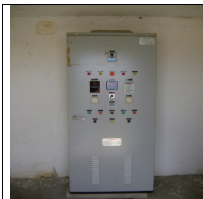
Foto 18 – Quadro elétrico da EECS
