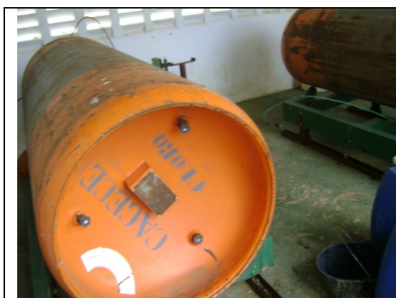
Foto 11 – Cilindros de cloro
