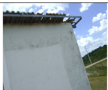
Fotos 20 e 21 – Vista geral da casa do quadro elétrico da EECS e detalhes dos sinais de infiltração e telhado danificado
