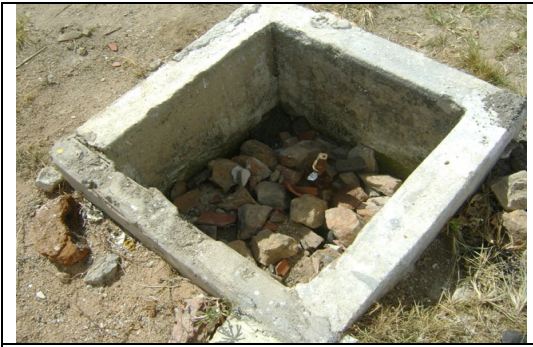
Foto 29 – REL-01 Caixa de registro danificada
