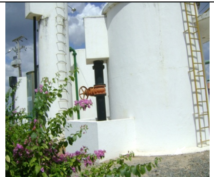
Foto 7 – Filtro de fluxo ascendente e torre de equilíbrio
