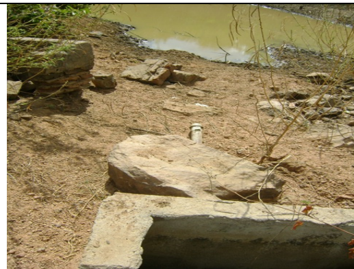
Fotos 38 e 39 – Adutora de água tratada - caixas de registros da danificadas
