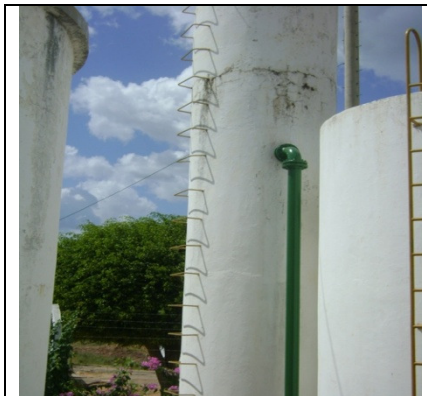
Foto 10 – Detalhe da torre de equilíbrio com sinais de vazamento
