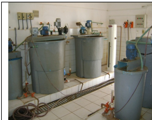
Foto 15 – Tanques dosadores e o sistema de fluoretação
