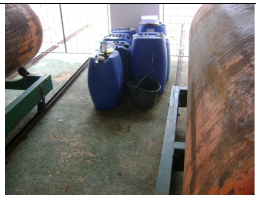
Foto 16 – Acondicionamento inadequado de produtos químicos.
