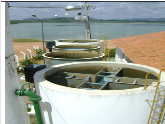
Foto 8 – Floto-filtros e floculadores
