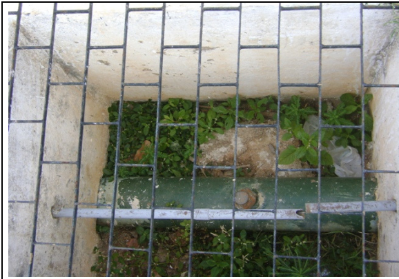
Foto 35 – EP na adutora de água bruta
