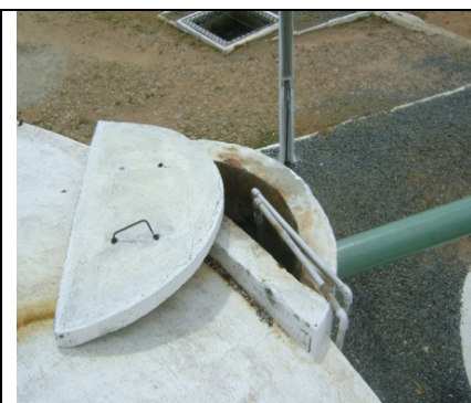
Foto 25 – Tampa aberta no RAP-02
