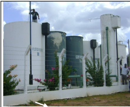
Foto 6 – Floto-filtros, floculadores e torre de equilíbrio
