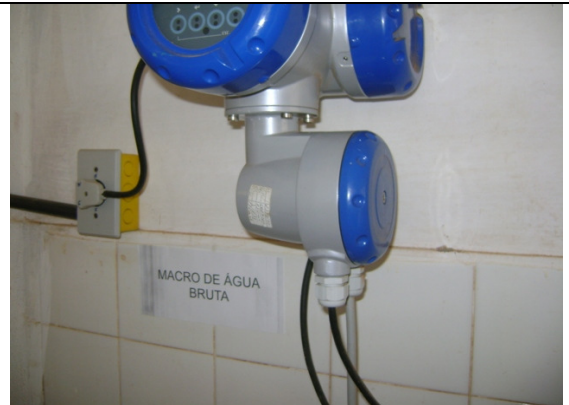
Foto 36 – Medição de água bruta
