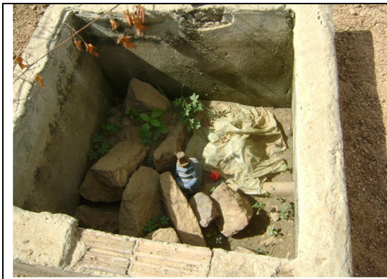
Fotos 38 e 39 – Adutora de água tratada - caixas de registros da danificadas
