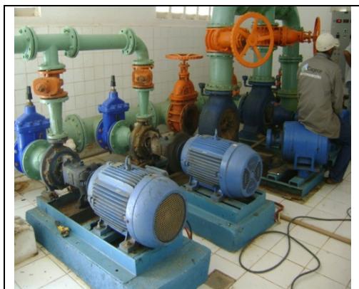
Foto 22 – Conjuntos moto-bombas da EEAT e EELF
