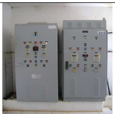
Foto 19 – Quadros elétricos da EEAT e EELF
