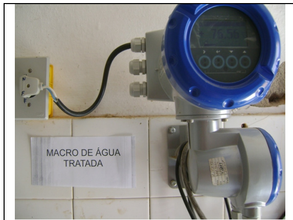
Foto 37 – Medição de água tratada
