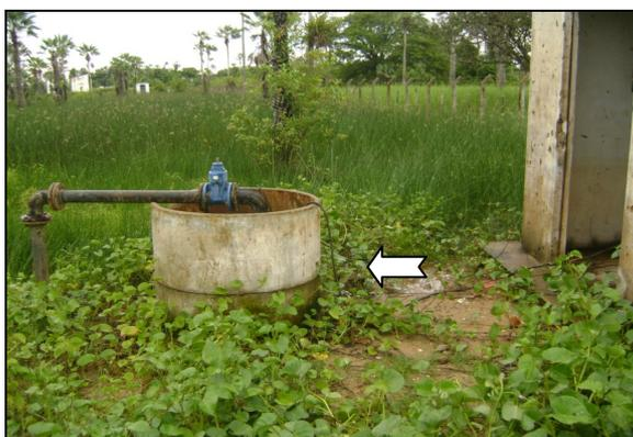
**Foto 11** – PT-09 - cabo elétrico sem proteção.
