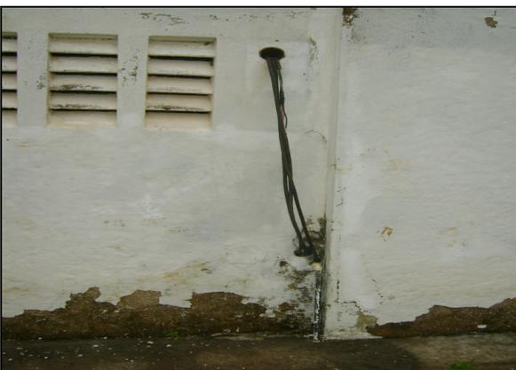
**Foto 30** – EEAB-01 – fiação sem fixação.
