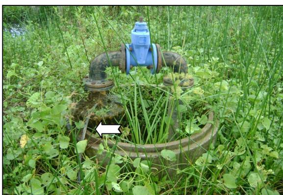
**Foto 9** – PT-08 – cabo elétrico sem proteção.
