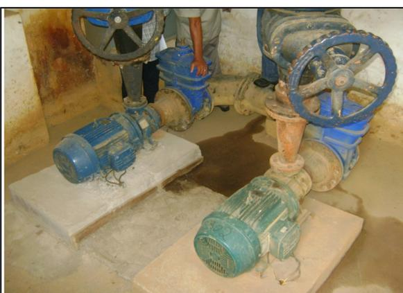
**Foto 32** – EEAB-01 – conjuntos motores-bomba.
