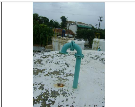
**Foto 45** – RAP-04: tubulação de ventilação sem tela.
