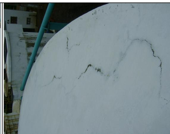
**Foto 41** – RAP-03: fissura na estrutura – laje de cobertura.
