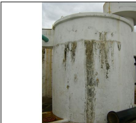
**Foto 17** – Filtro 02 - sinais de vazamento na estrutura.
