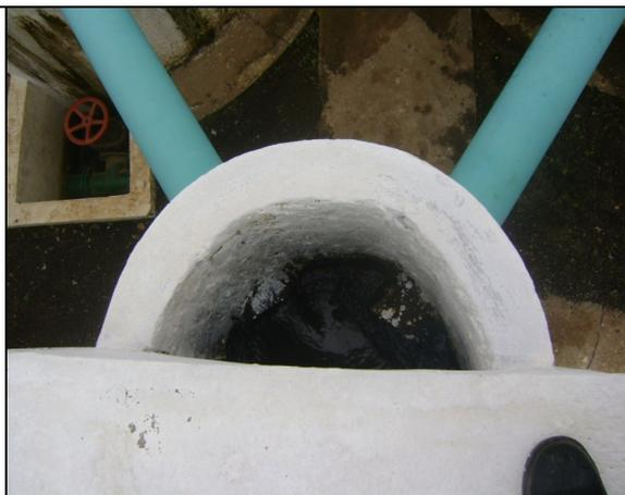
**Foto 43** – RAP-03: calha de alimentação sem tampa.
