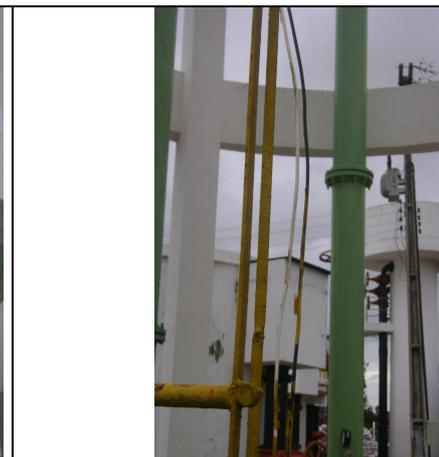
**Foto 49** – REL-01: fiação da bóia e da lâmpada do para-raio na escada de acesso.
