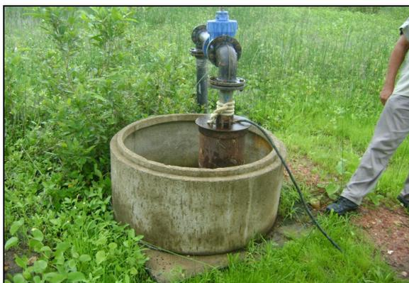
**Foto 7** – PT-07 – cabo elétrico sem proteção.
