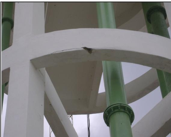
**Foto 48** – REL-01: fissura na viga do segundo anel.
