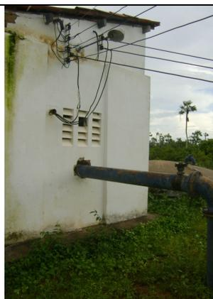
**Foto 29** – EEAB-01 - tubulação de recalque sem chumbamento.
