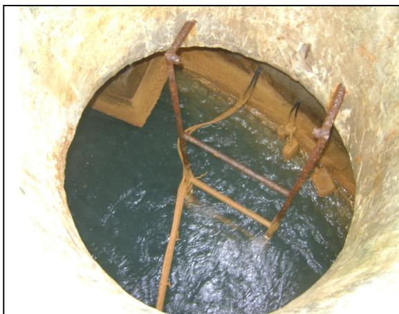
**Foto 34** – RAP-01: escada com processo de corrosão.
