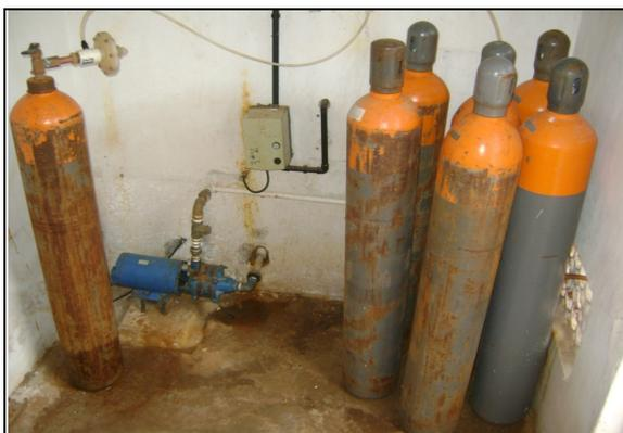
**Foto 23** – Bomba dosadora no mesmo ambiente dos cilindros de cloro.
