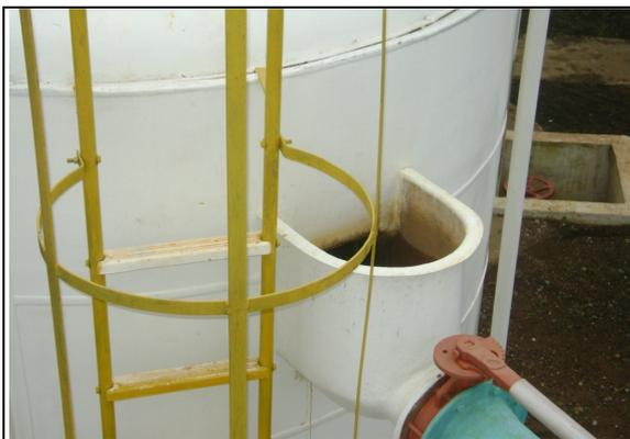
**Foto 21** – Filtro 04 – calha sem tampa.
