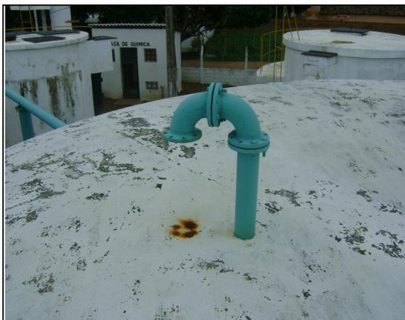
**Foto 36** – RAP-02: tubulação de ventilação sem tela.
