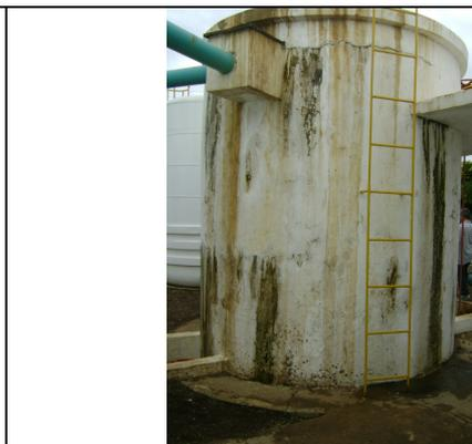
**Foto 18** – Filtro 03 – sinais de vazamento na estrutura.
