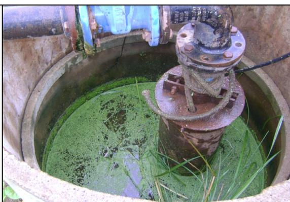
**Foto 12** – PT-09 – água na caixa de proteção.
