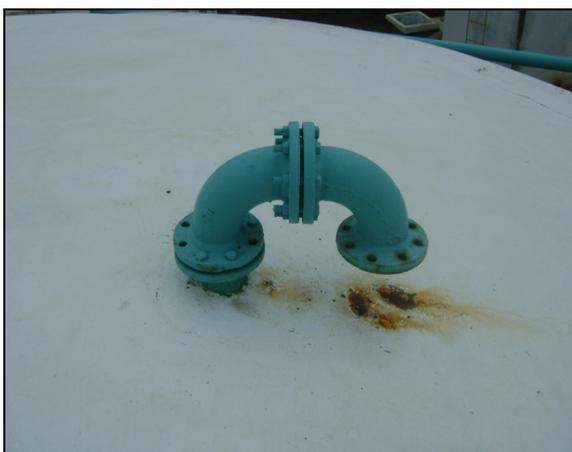
**Foto 40** – RAP-03: tubulação de ventilação sem tela.
