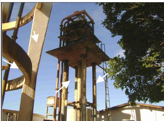
**Foto 13** – Aerador: ausência de guarda-corpo na escada de acesso e no alto de sua estrutura.
