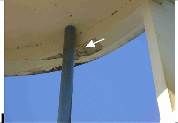
**Foto 37** – Outra vista de ferragem aparente da estrutura de concreto do REL-01.
