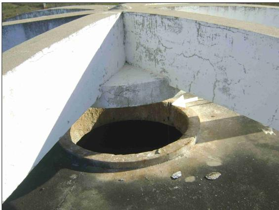
**Foto 34** – Orifício sem tampa de proteção - REL-01.
