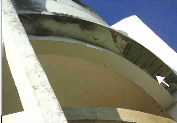
**Foto 36** – Vista de ferragem aparente da estrutura de concreto do REL-01.
