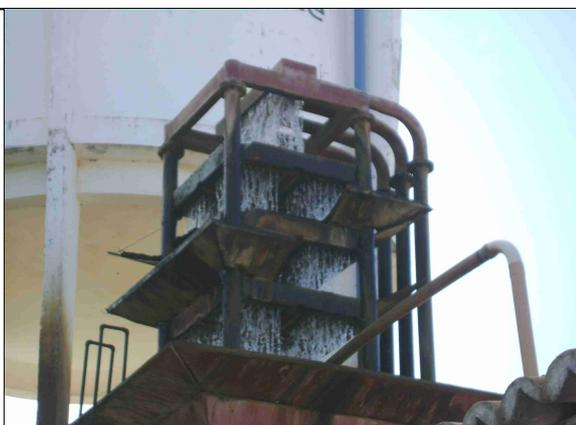
**Foto 14** – Aerador com bandejas danificadas.
