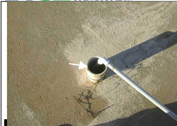
**Foto 32** – Entrada de tubulação de solução de flúor inadequada – RAP-01.
