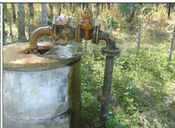
**Foto 7** – Vazamento no registro da tubulação de recalque – PT-01.
