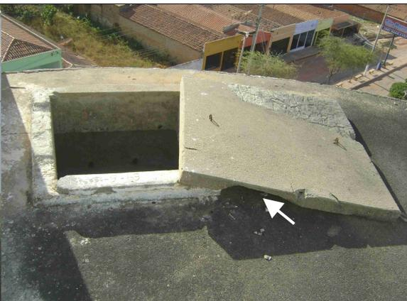
**Foto 35** – Tampa de inspeção danificada – REL-01.
