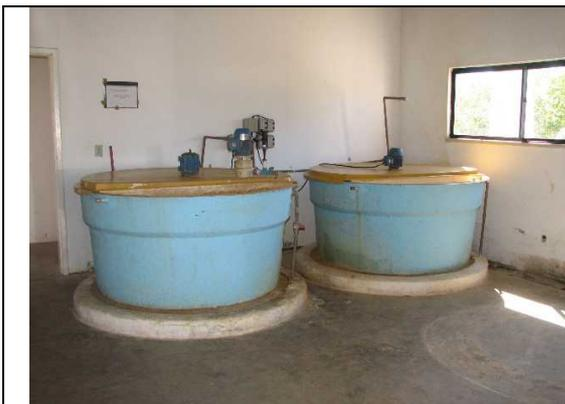
**Foto 8** – Vista dos tanques de dosagem de produtos químicos localizados na ETA.
