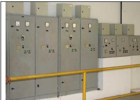
**Foto 20** – Quadros de comando das elevatórias EEAB-01 e EEAT-01/02 em boas condições.
