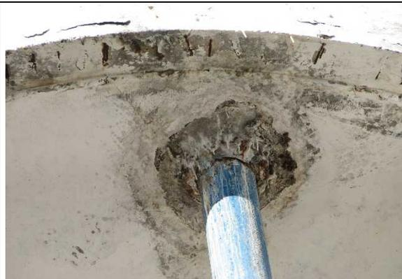
**Foto 36** – Ferragem exposta e sinais de vazamento no REL-02
