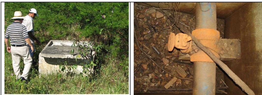
**Fotos 42 e 43** – Caixas de registro de descarga da adutora de água tratada
