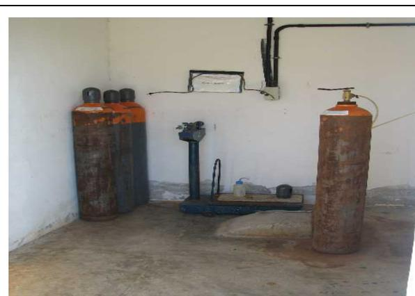
**Foto 10** – Sistema de dosagem de cloro gasoso
