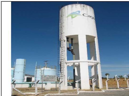
**Foto 31** – REL-01 sem guarda corpo na laje de cobertura.
