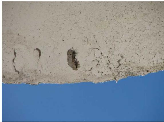
**Foto 33** – Ferragem exposta e sinais de vazamento no REL-01
