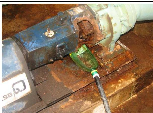
**Foto 25** – Conjunto moto-bomba da EEAT-01 - com vazamento e corrosão
