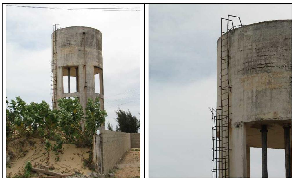
Fotos 36 e 37 – Vistas do REL-01 – sem gaiola de proteção no trecho superior da escada
