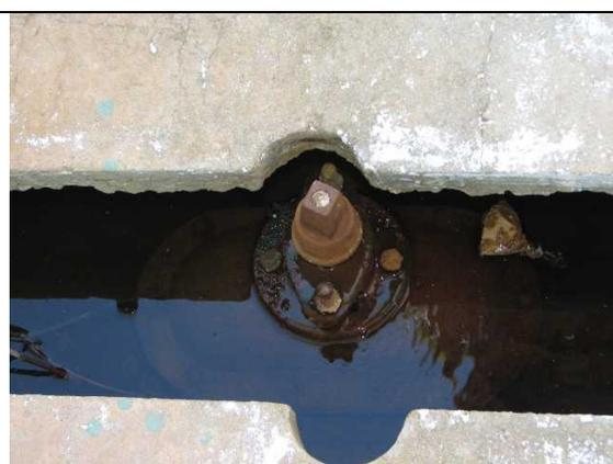
Foto 11 – Registro do filtro 02 com vazamento
