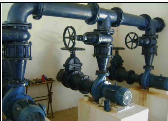
Foto 21 – Conjunto moto-bomba da EE-02.
