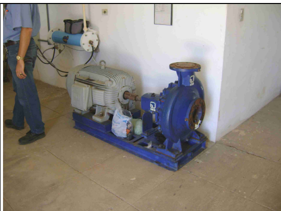
Foto 20 – Bomba reserva da EE-01.
