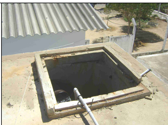
Foto 35 – Outra inspeção com ausência de tampa de proteção – RAP-01.
