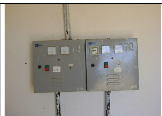
Foto 26 – Quadro de comando da EE-04.
