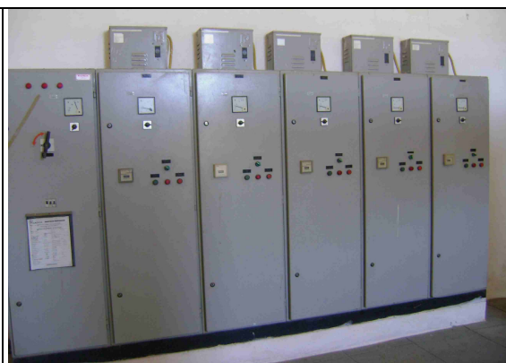
Foto 24 – Quadro de comando da EE-03.
