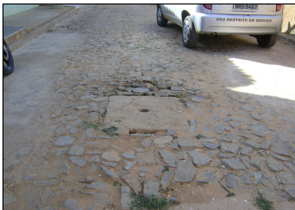
Foto 58 – Registro de descarga localizada na Rua Constância Correa.
