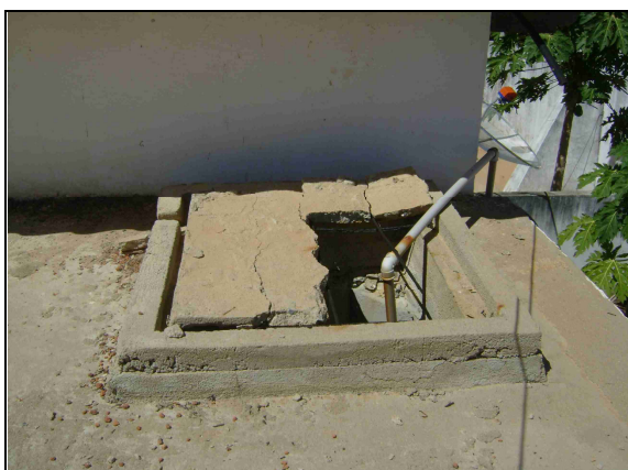
Foto 34 – Inspeção com tampa danificada – RAP-01.
