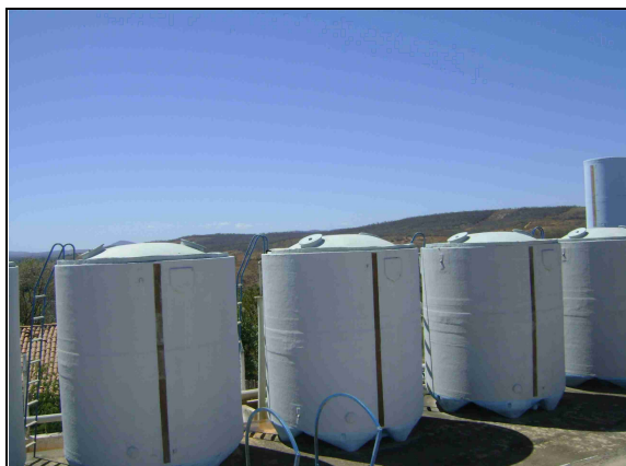
Foto 4 – Vista dos filtros sem identificação - ETA de Várzea Alegre.
