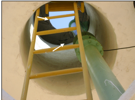
Foto 47 – Ausência de tampa e tela de proteção na laje superior e no acesso interno, respectivamente – REL-02.
