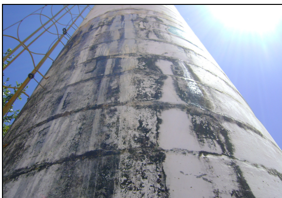
Foto 50 – Vazamento na lateral do reservatório REL-03.
