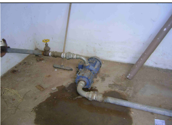
Foto 32 – Conjunto moto-bomba da EE-07.
