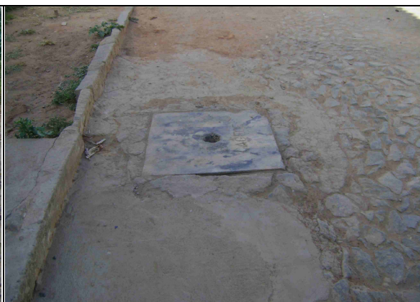
Foto 61 – Registro de descarga localizada na Rua Vila Cacilda.
