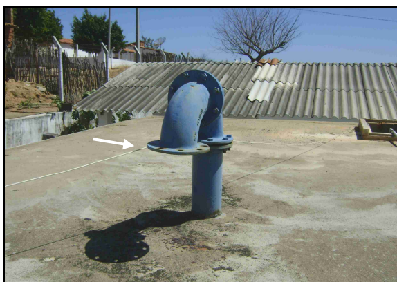
Foto 36 – Tubulação de ventilação sem tela de proteção – RAP-01.
