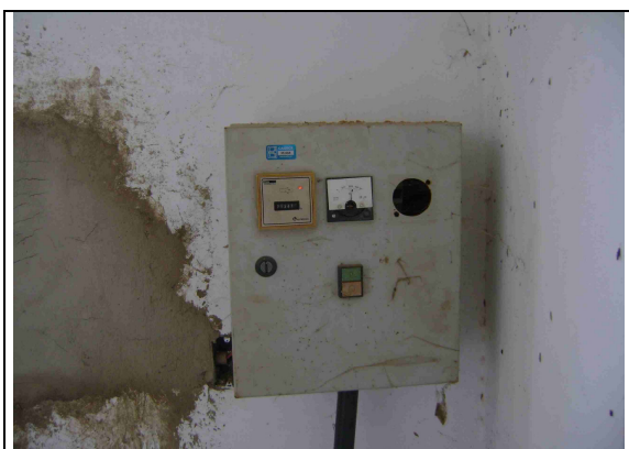
Foto 33 – Quadro de comando da EE-07.
