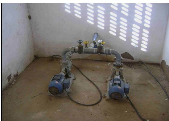
Foto 27 – Conjunto moto-bomba da EE-05.
