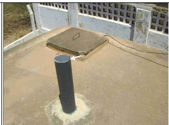
Foto 40 – Tubulação de ventilação inadequada do RAP-03.
