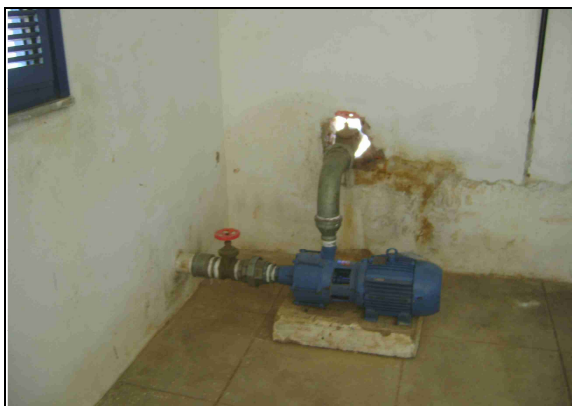
Foto 29 – Conjunto motor-bomba da EE-06.
