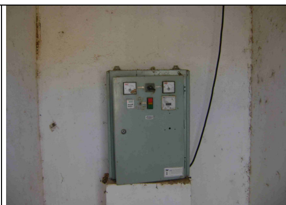
Foto 28 – Quadro de comando da EE-05.
