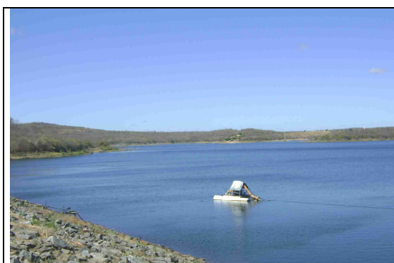
Foto 2 – Vista da Captação.
