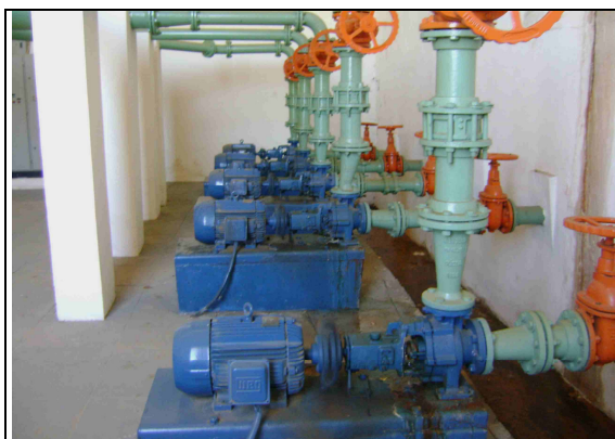
Foto 23 – Conjunto moto-bomba da EE-03.
