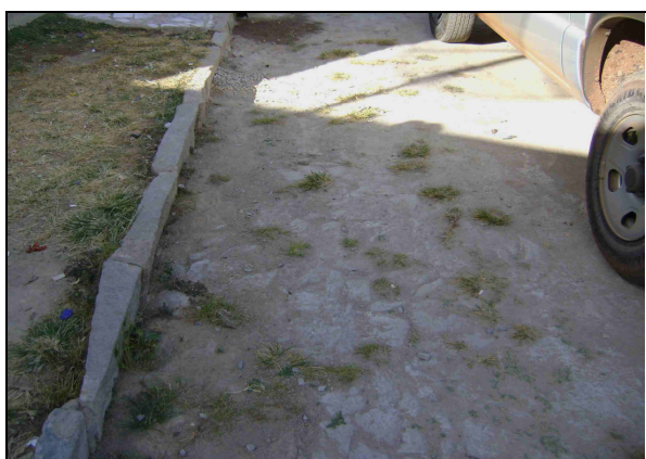
Foto 62 – Registro de descarga soterrado, localizado na Rua José Correa de Sobrinho.
