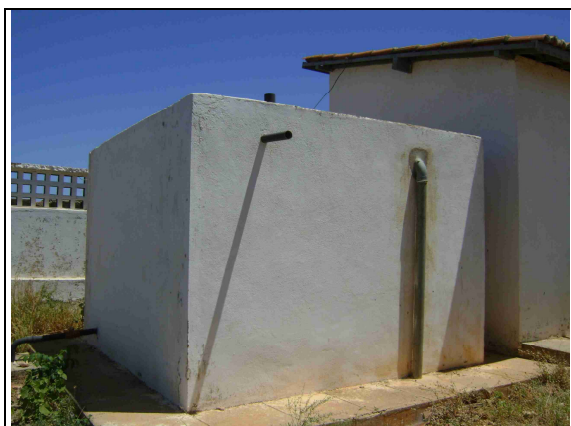
Foto 39 – Vista do reservatório RAP-03.
