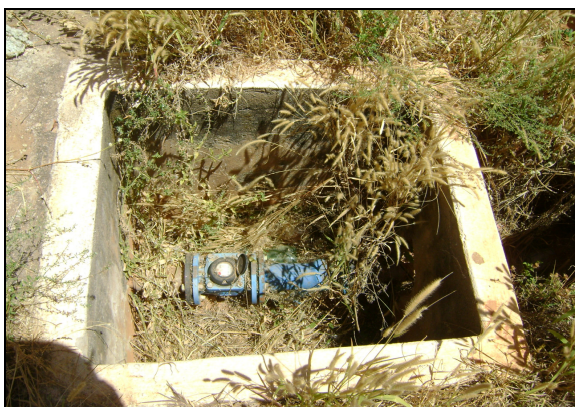
Foto 54 – Caixa de proteção de macromedidor sem tampa de proteção.
