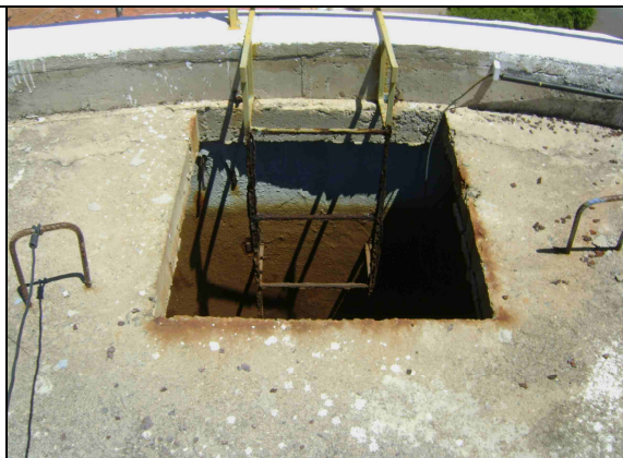
Foto 44 – Vista da abertura de inspeção do REL-01 sem tampa.
