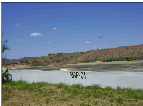
Foto 37 – Vista do reservatório RAP-02, identificação atual (RAP-01) encontra-se em desacordo com as informações do Croqui e RASO.
