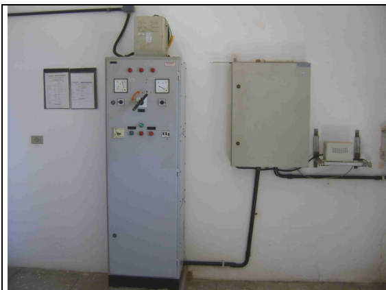
Foto 19 – Quadro de comando da EE-01.
