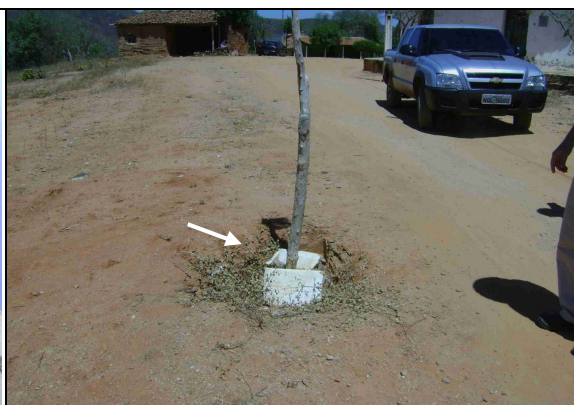
Foto 51 – Registro de saída do reservatório REL-03 sem caixa de proteção.
