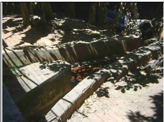
Foto 6 – Calha de escoamento das águas de lavagem dos filtros em direção ao açude Olho d'Água .
