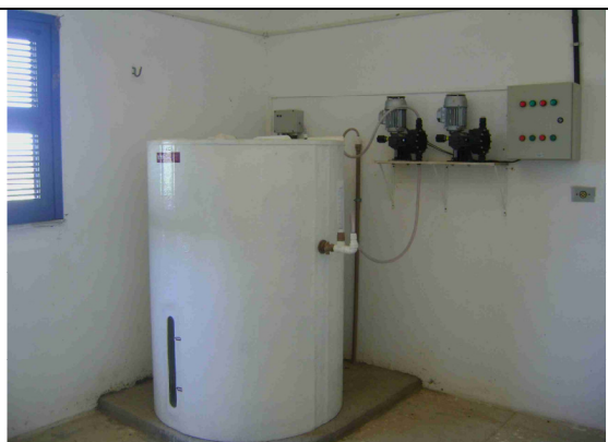
Foto 18 – Sistema de fluoretação.
