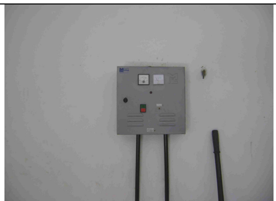
Foto 30 – Quadro de comando da EE-06.
