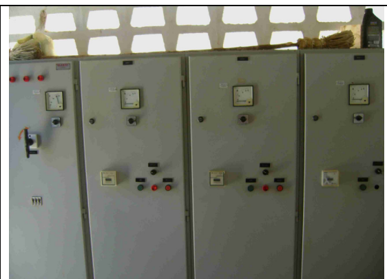
Foto 22 – Quadro de comando da EE-02.
