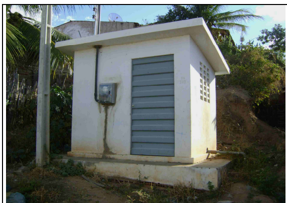
Foto 31 – Ausência de identificação – Vista da EE-07.
