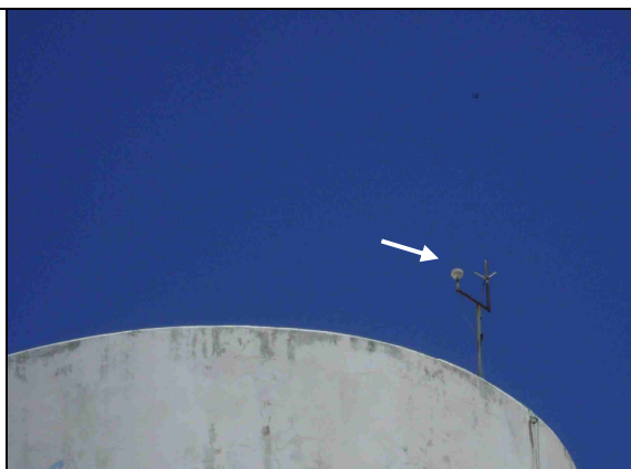
Foto 46 – Ausência de sinalizador noturno - REL-02.
