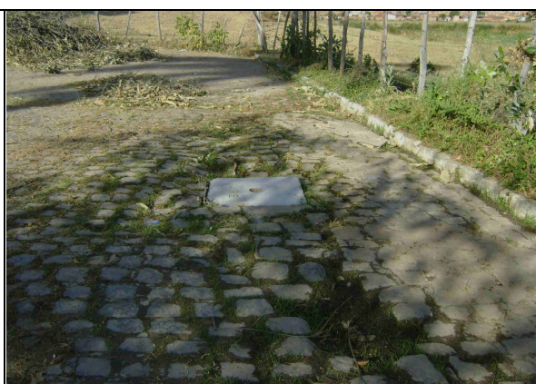
Foto 63 – Registro de descarga localizada na Rua Luiz Afonso Diniz.
