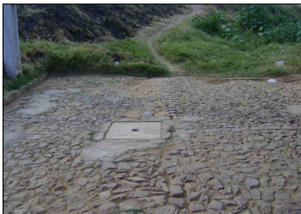
Foto 60 – Registro de descarga localizada na Rua Vicente Primo.
