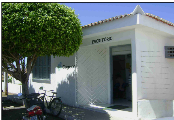
Foto 65 – Vista externa do escritório da CAGECE.
