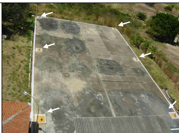
Foto 38 – Vista das tubulações de ventilação do RAP-02.
