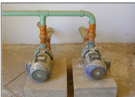
Foto 25 – Conjunto moto-bomba da EE-04.
