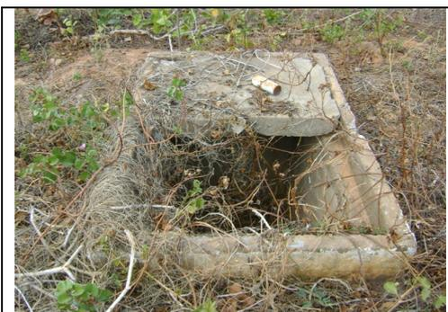
**Foto 28** – Registro de descarga da adutora de água bruta, próximo à captação
