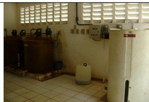
**Foto 11** – Tanques de dosagem e o sistema de fluoretação
