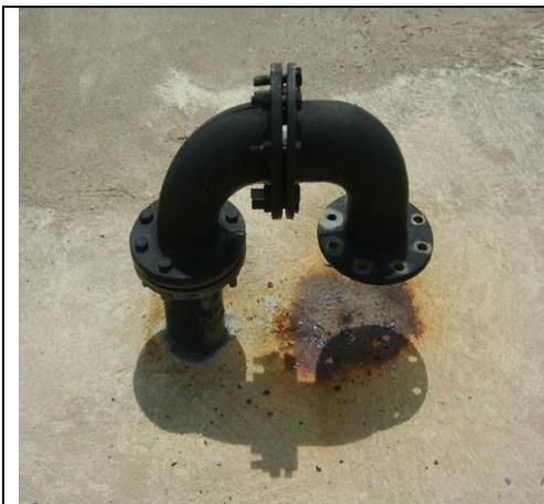
**Foto 23** – Tubulação de ventilação do RAP-01
