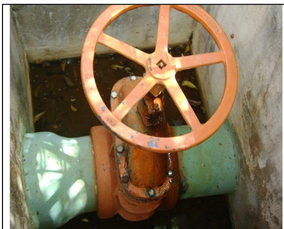
**Foto 25** – Registro na saída dos RAP's 01 e 02, com vazamento
