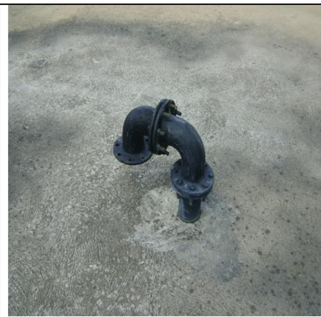
**Foto 24** – Tubulação de ventilação do RAP-02
