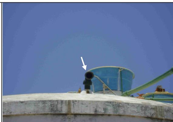
Foto 62 – RAP-02: Tubulação de ventilação inadequada.
