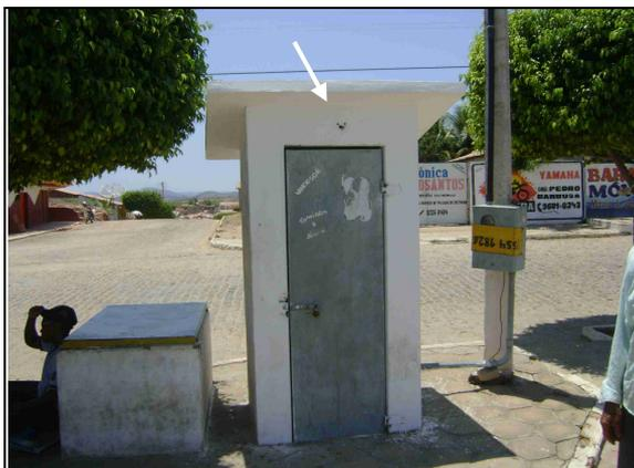
**Foto 32** – Vista do PT-12 sem identificação, cerca de proteção e iluminação noturna.
