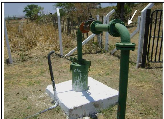
**Foto 9** – Tubulação de recalque do PT-03.
