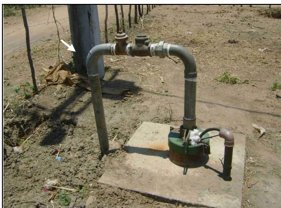
**Foto 36** – Tubulação de recalque do PT-13.
