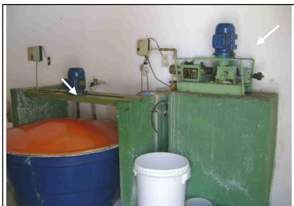
**Foto 41** – Tanque de dosagem com bomba dosadora para aplicação de hipoclorito de cálcio no RAP-01.
