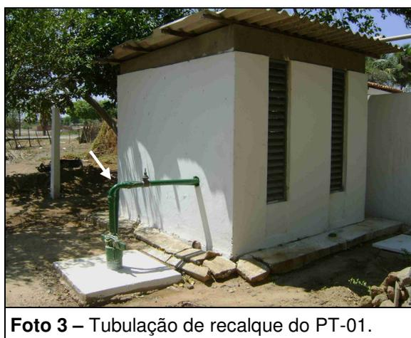
**Foto 3** – Tubulação de recalque do PT-01.
