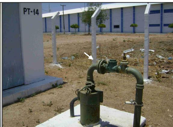
**Foto 40** – Tubulação de recalque do PT-14.
