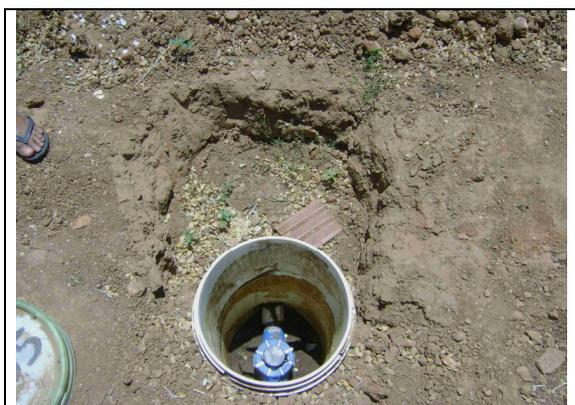
**Foto 54** – Balde sendo utilizado como caixa de inspeção do macromedidor, localizado na saída do PT-05.
