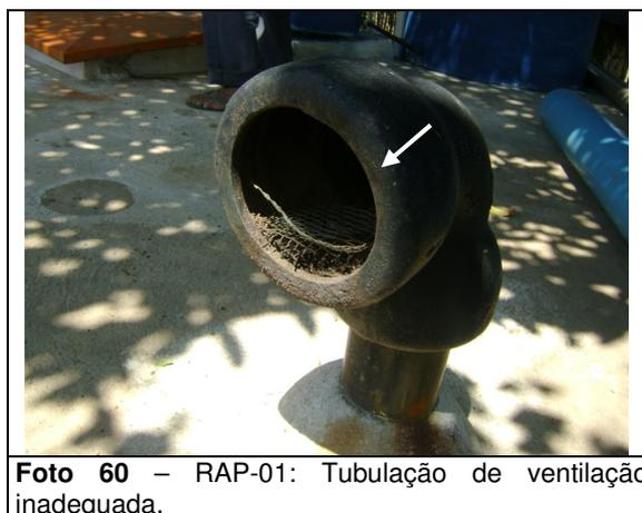
Foto 60 – RAP-01: Tubulação de ventilação inadequada.
