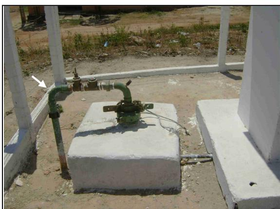
**Foto 25** – Tubulação de recalque do PT-09.
