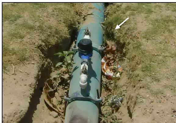
**Foto 76** – Macromedidor sem caixa de proteção, localizado na saída do RAP-02.
