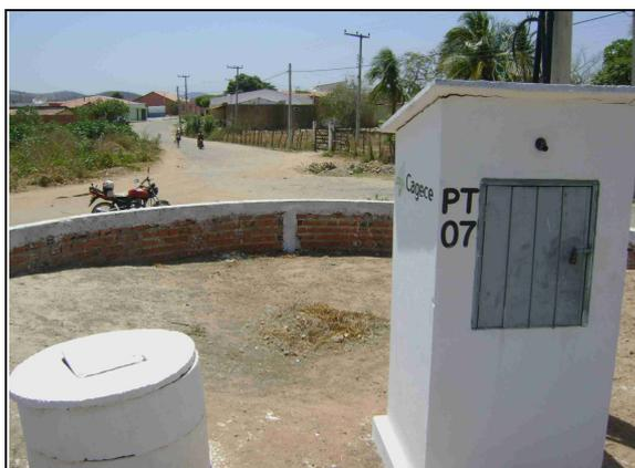
**Foto 19** – Vista do PT-07 sem cerca de proteção e iluminação noturna.
