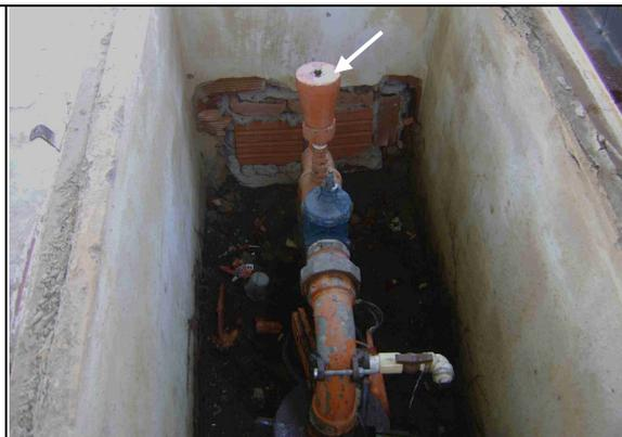
**Foto 44** – Kit de cloração utilizando tabletes de hipoclorito de cálcio (Hypocal), localizado na tubulação de recalque do PT-12.
