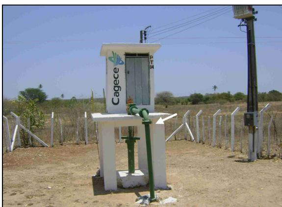
**Foto 12** – Tubulação de recalque do PT-04.
