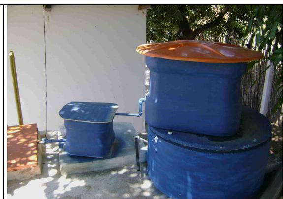
**Foto 42** – Tanque de cloração reserva da bomba dosadora, localizado na laje superior do RAP-01.
