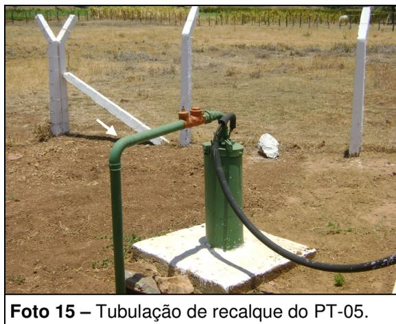
**Foto 15** – Tubulação de recalque do PT-05.
