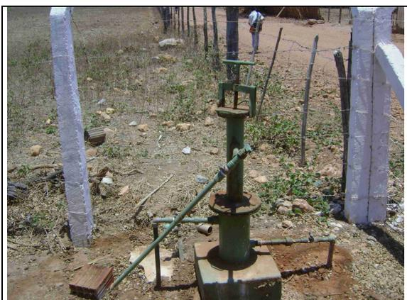
**Foto 45** – Kit de cloração utilizando tabletes de hipoclorito de cálcio (Hypocal), localizado na tubulação de recalque do PT-05.
