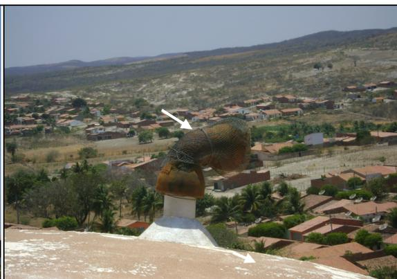
**Foto 68** – REL-01: Tubulação de ventilação inadequada.
