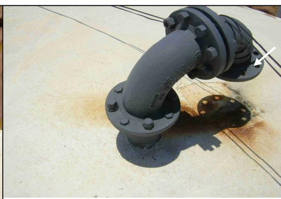
Foto 66 – RAP-03: Tubulação de ventilação sem tela de proteção.
