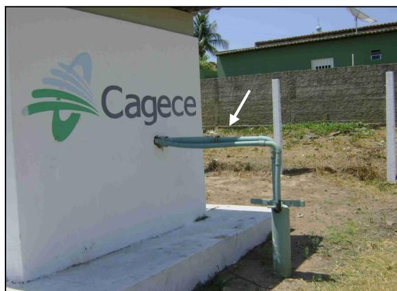
**Foto 6** – Tubulação de recalque do PT-02.
