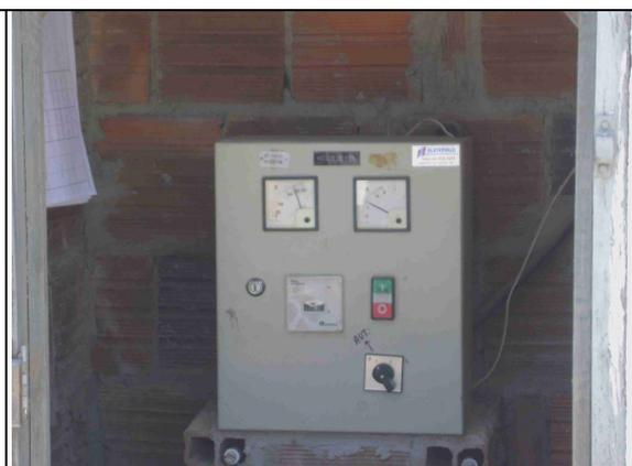
**Foto 20** – Quadro de comando do PT-07: ausência de revestimento da parede interna.
