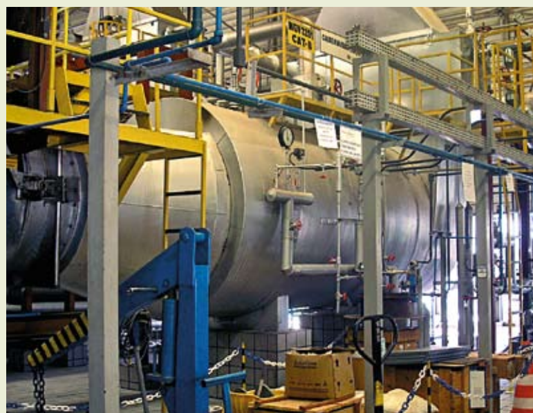
Figura 4 - Caldeira em uma usina térmica de geração de energia elétrica. Fonte: Arce
