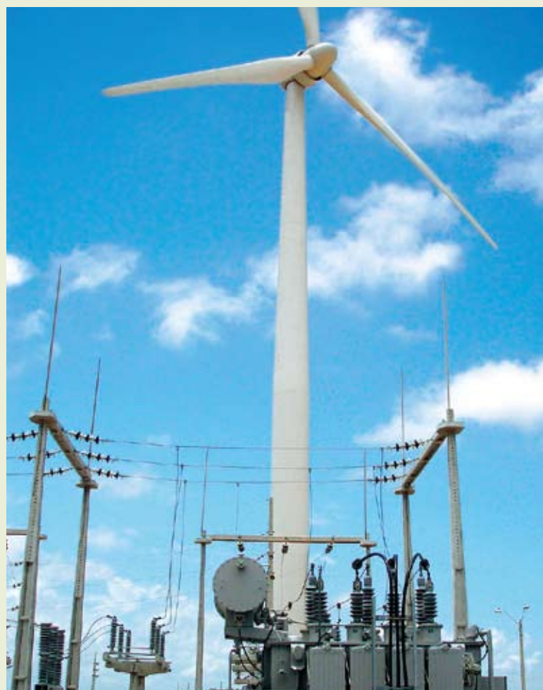
Figura 3 - Aerogerador e transformador de força em um parque eólico de geração de energia elétrica. Fonte: Arce
