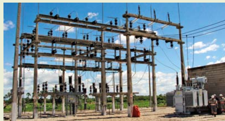
Figura 2 - Subestação da Coelce, observando-se o transformador de força (lado direito) e o barramento de alta tensão (72,5 kV). Fonte: Arce
