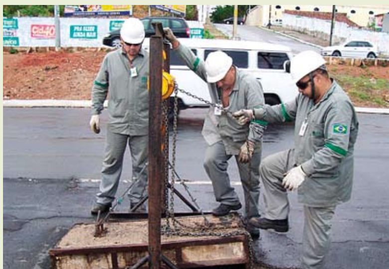
Figura 4 - Operadores da Cegás no exercício de fechamento da caixa de derivação da rede após o acionamento da válvula de bloqueio de gás. Fonte: Arce
