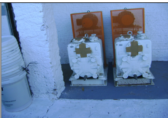
Foto 8 – Bombas no almoxarifado.
