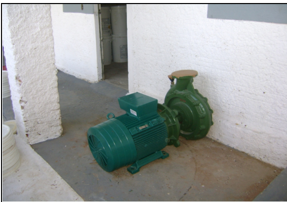
Foto 9 – Bombas no almoxarifado.
