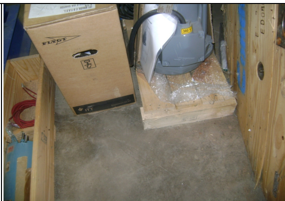
Foto 6 – Bombas no almoxarifado.
