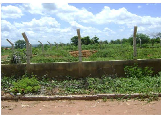
Foto 4 – Área do reservatório do Aeroporto – iniciado e paralisado.
