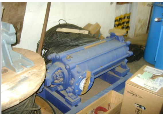
Foto 10 – Bombas no almoxarifado.
