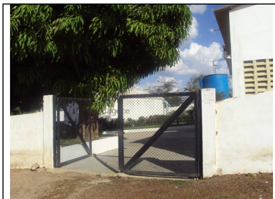
Foto 4 – Vista da entrada da ETA dos sistemas de Varjota e Reriutaba
