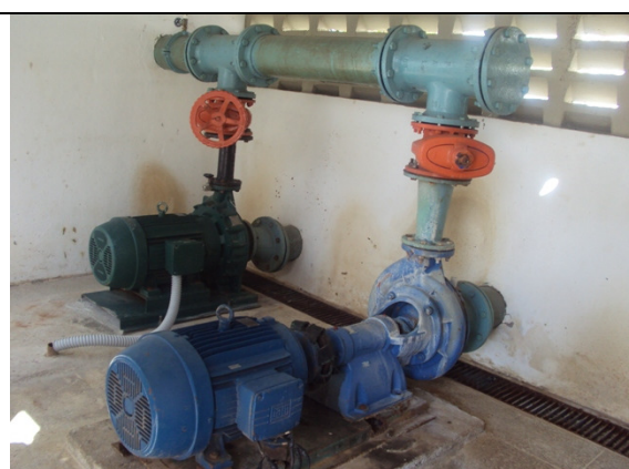
Foto 18 – Vista da EEAT-02
