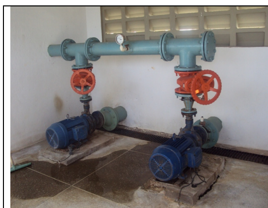
Foto 17 – Vista da EEAT-01
