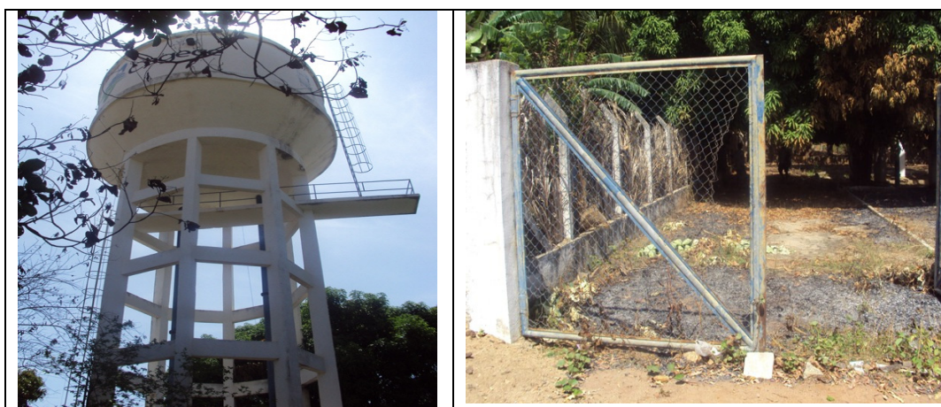
Foto 26 – Vista do REL-02
