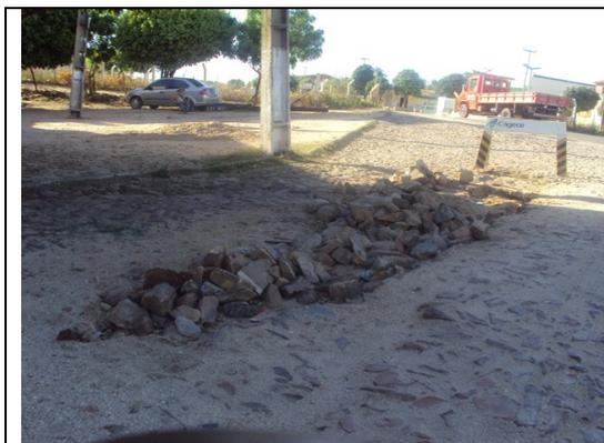
**Foto 19** – Calçamento danificado devido a vazamento recente na adutora
