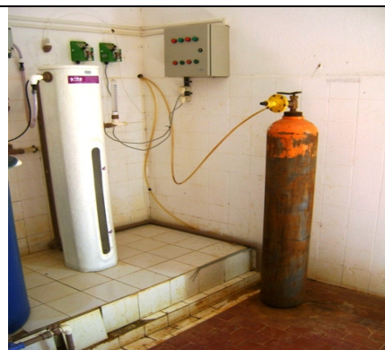
Foto 11 – Sistema de fluoretação
