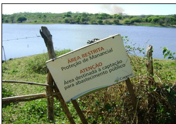
Foto 3 – Sinalização da área de captação
