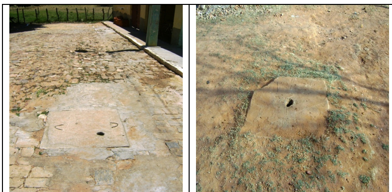
Fotos 41 e 42 – Registros de descarga nas Ruas Sargento Dudu, Herculino Marrocos
