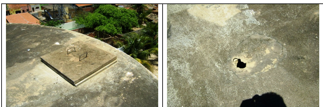
Fotos 32 e 33 – Detalhes da laje superior do REL-02
