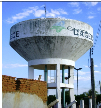
Foto 30 – Detalhe do REL-01
