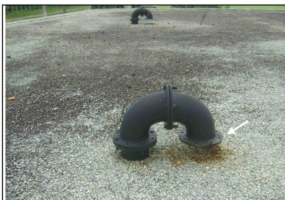
**Foto 11** – RAP-09: Tubulação de ventilação sem tela de proteção.
