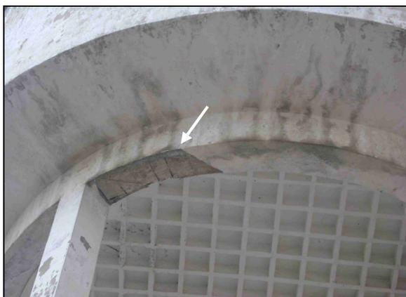
**Foto 14** – REL-11: Armadura da estrutura exposta.
