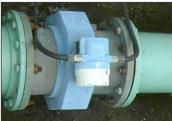
**Foto 1** – Adutora de água tratada entre o RAP—08, localizado em Ubajara e RAP-09: Macro-medidor eletromagnético
