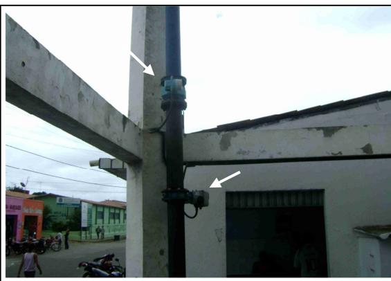
**Foto 2** – Válvula controladora e macro-medidor eletromagnético na chegada do REL-11.
