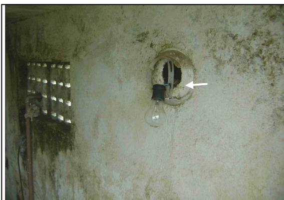
**Foto 7** – *Booster*: Iluminação noturna apresentando fiação exposta.
