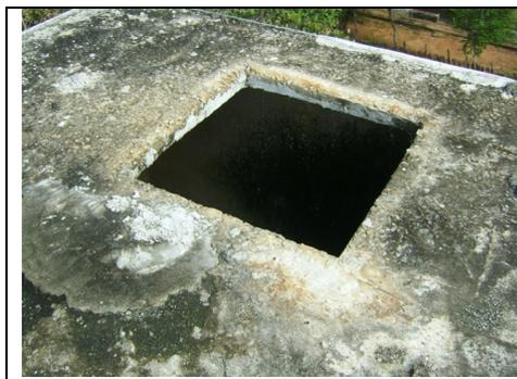
**Foto 18** – Ausência de tampa na abertura de inspeção
