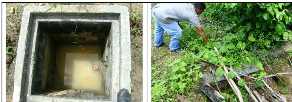
**Fotos 21 e 22** – Caixa de proteção sem tampa, ventosa alagada e registro soterrado na adutora de água tratada
