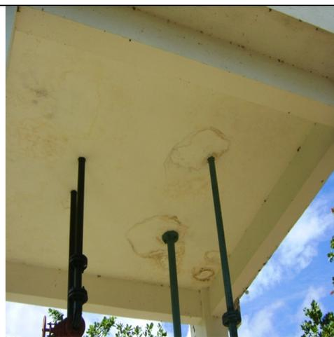
**Foto 17** – Sinais de vazamento na laje inferior
