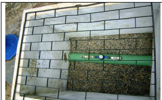
**Foto 23** – Medidor proporcional na saída da ETA
