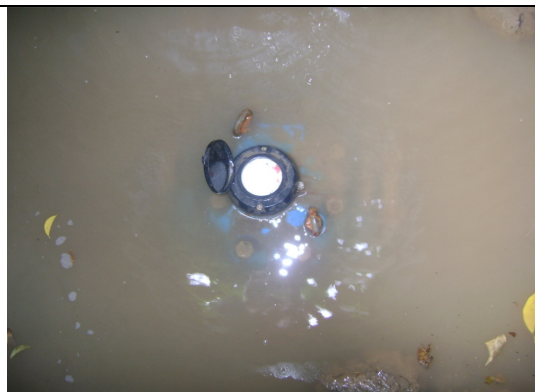
Foto 39 – Macromedidor Woltman do PT-01, 04 e 05: adutora de água tratada.
