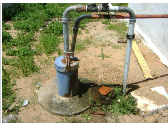
Foto 7 – PT-03: vazamento no registro de gaveta – barrilete do poço.
