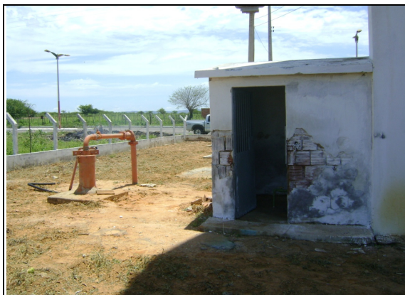
Foto 19 – PT-06: ausência de identificação e iluminação externa.
