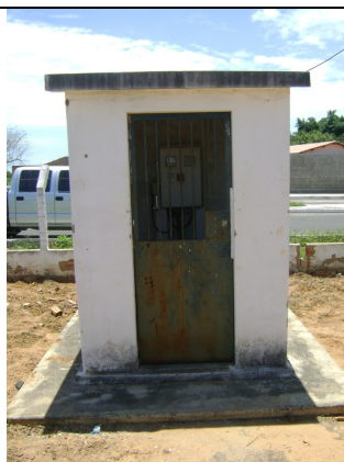
Foto 20 – PT-06: pintura deteriorada do portão da casa de comando.
