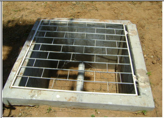
Foto 54 – REL-03: pintura deteriorada nas grades das caixas de proteção dos registros.
