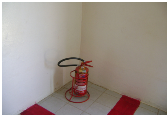
Foto 70 – Extintor de incêndio (localizado no escritório/loja do SAA de Mauriti).
