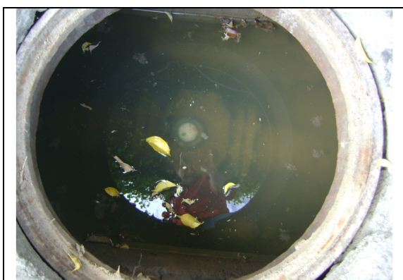
Foto 42 – Caixa de proteção do macromedidor na adutora de água tratada: cheia de água.
