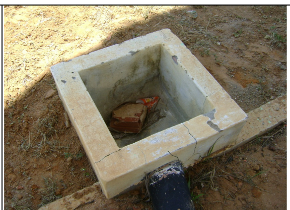
Foto 58 – REL-03: caixa de passagem de drenagem danificada e sem tampa.
