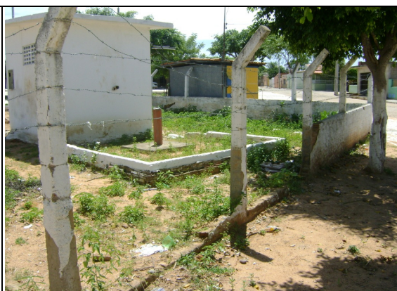
Foto 6 – PT-03: muro e cerca de proteção danificados.
