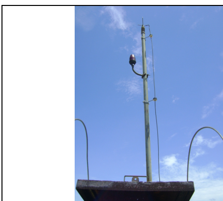
Foto 51 – REL-02: sinalização noturna sem funcionar.
