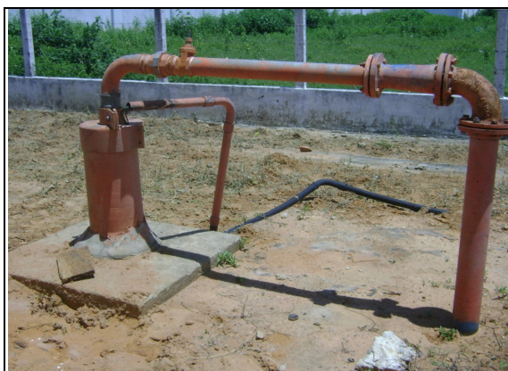
Foto 21 – PT-06: pintura deteriorada do barrilete do poço.
