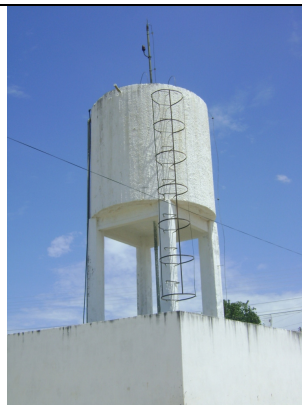
Foto 46 – REL-02: ausência de guarda corpo na laje de cobertura.
