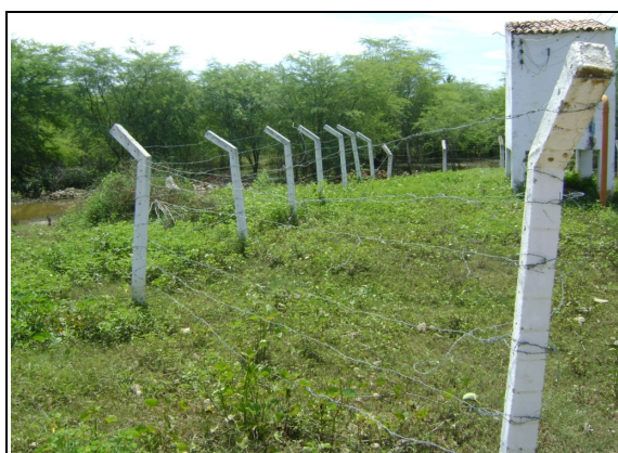
Foto 13 – PT-04: cerca de proteção – arames farpados não tensionados.
