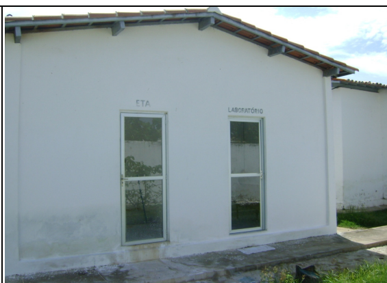
Foto 29 – Vista da Unidade de Tratamento e do laboratório.
