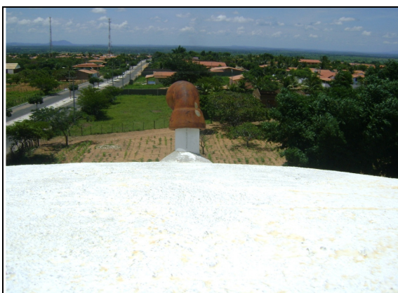
Foto 57 – REL-03: tubulação de ventilação inadequada e com pintura deteriorada.
