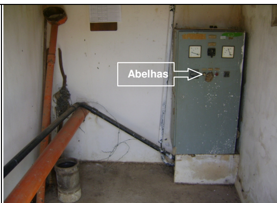
Foto 12 – PT-04: quadro de comando com pintura deteriorada e presença de abelhas.
