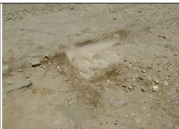
Foto 64 – Registro de descarga localizado na Rua Padre Maranhão.
