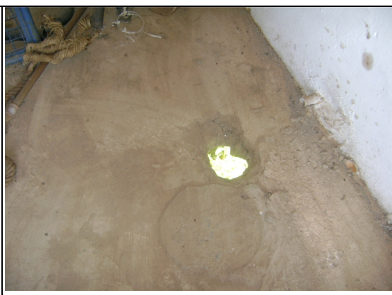
Foto 18 – PT-05: furo na laje de piso da casa de comando.
