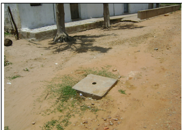
Foto 63 – Registro de descarga localizado na Rua 1: Bela Vista.
