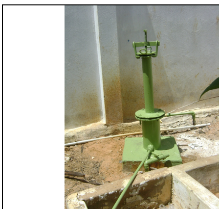
Foto 26 – Clorador de pastilha: linha de alimentação do REL-02.
