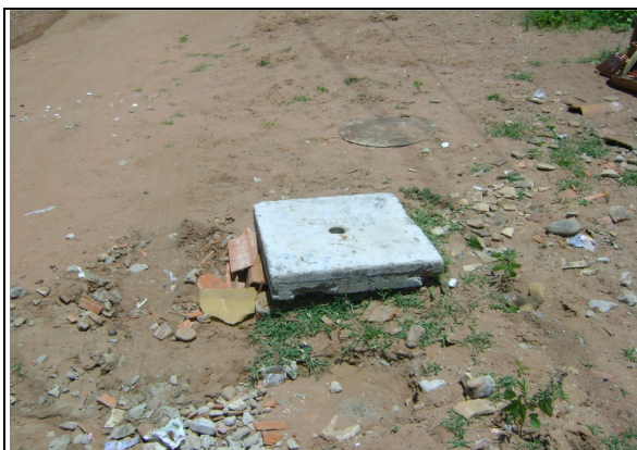
Foto 61 – Registro de descarga localizado na Rua 3: Bela Vista.
