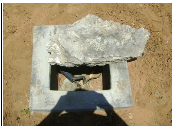
Foto 23 – PT-06: tampa quebrada da caixa de fiação.
