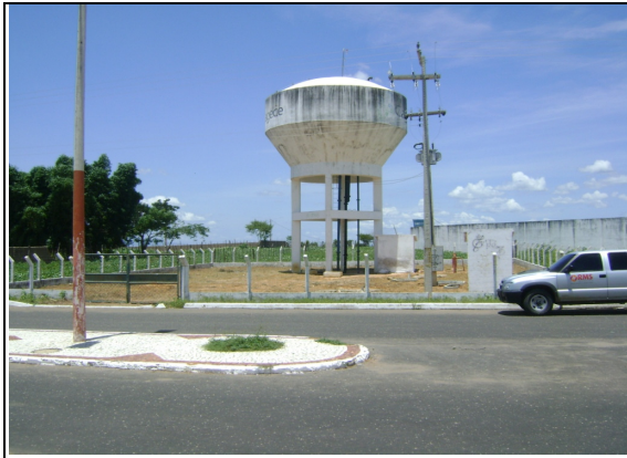
Foto 53 – REL-03: pintura deteriorada e ausência de identificação e guarda corpo na laje de cobertura.
