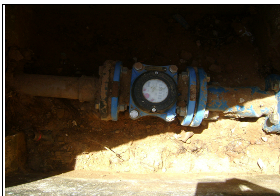
Foto 40 – Macromedidor na saída do PT-03: adutora de água tratada.
