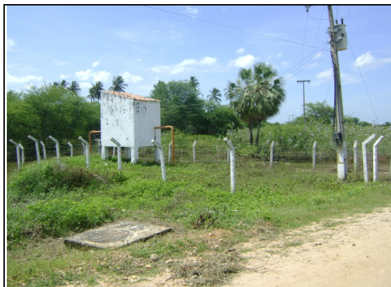
Foto 9 – PT-04: ausência de identificação e iluminação externa.
