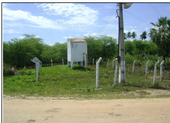
Foto 11 – PT-04: sem portão de entrada.
