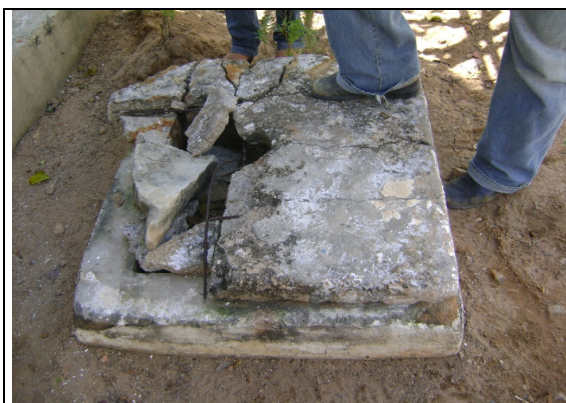
Foto 49 – REL-02: caixas de proteção de registro danificada.
