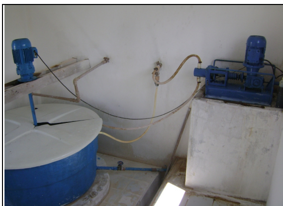
Foto 28 – Casa de química: tanque de dosagem e bomba dosadora de cloro.
