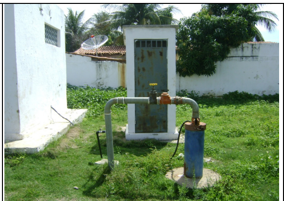
Foto 2 – PT-01: casa de comando e tubulação de encamisamento do poço com pintura deteriorada.
