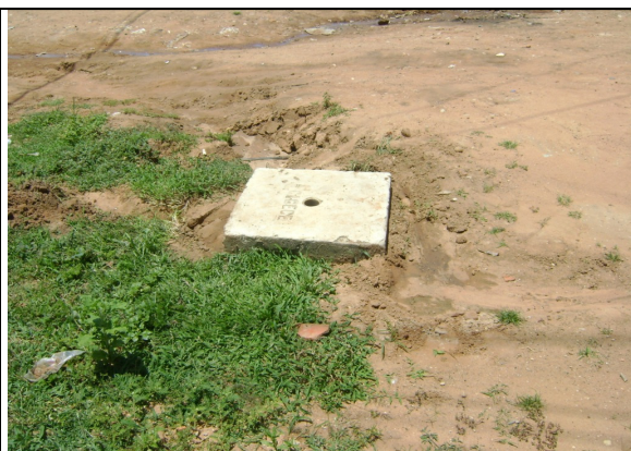
Foto 62 – Registro de descarga localizado na Rua 2: Bela Vista.
