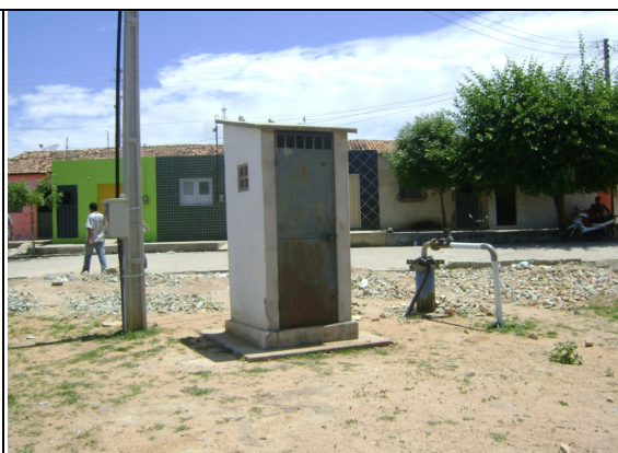
Foto 25 – PT-07: ausência de cerca de proteção.
