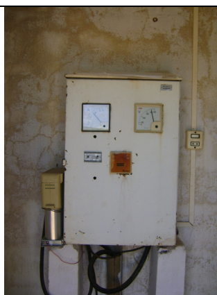
Foto 22 – PT-06: pintura deteriorada do quadro de comando.
