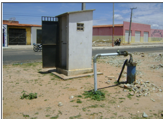
Foto 24 – PT-07: ausência de identificação e de iluminação externa.
