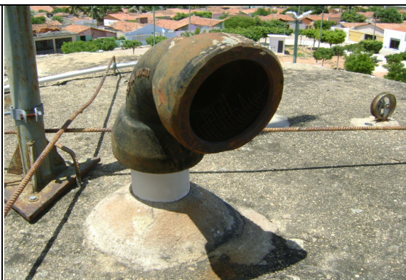
Foto 48 – REL-02: tubulação de ventilação de forma inadequada e sem tela de proteção.
