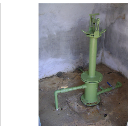
Foto 27 – Clorador de pastilha: linha de alimentação do REL-03.
