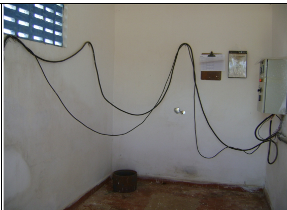
Foto 4 – PT-03: instalação elétrica inadequada.
