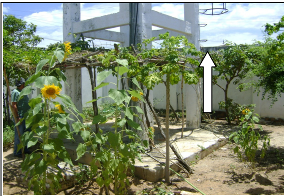
Foto 45 – REL-02: escada e gaiola protetora com pintura deteriorada.
