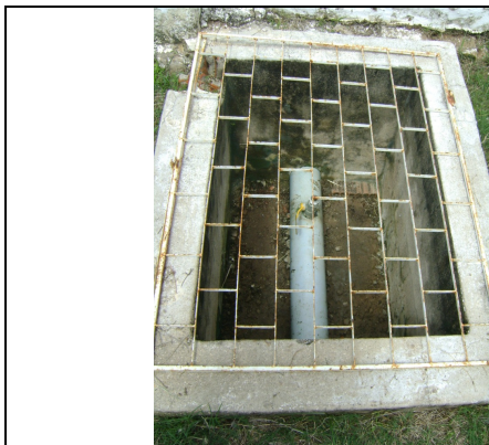
Foto 38 – Estação pitométrica na saída do PT-01: adutora de água bruta.
