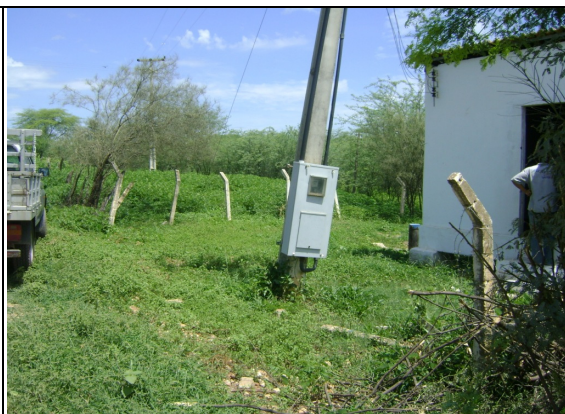
Foto 16 – PT-05: ausência de fechamento com cerca de proteção e de limpeza da área.
