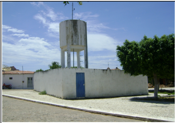
Foto 44 – REL-02: pintura deteriorada.
