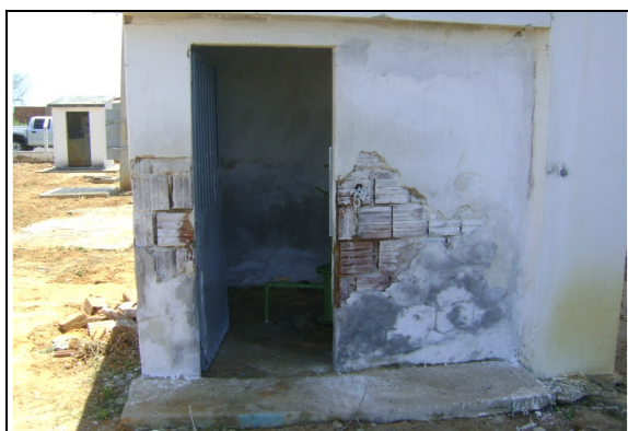
Foto 37 – Casa do clorador de pastilhas localizada na área do REL-03: reboco e pintura deteriorados.
