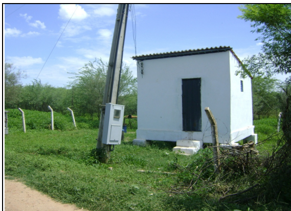
Foto 15 – PT-05: ausência de identificação e de iluminação externa.
