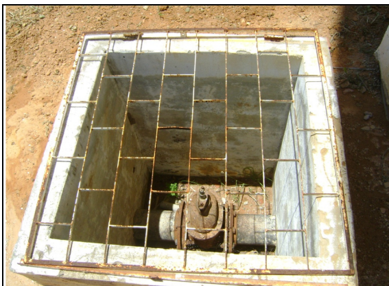
Foto 55 – REL-03: pintura deteriorada do registro de saída.
