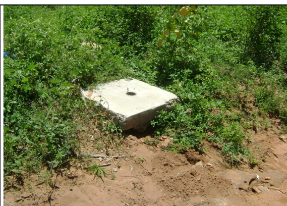
Foto 60 – Registro de descarga localizado na Rua 4: Bela Vista.
