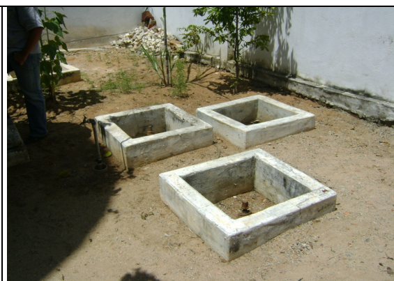
Foto 50 – REL-02: caixas de proteção de registros sem tampas.
