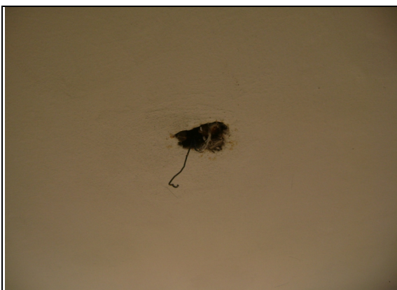
Foto 5 – PT-03: sem iluminação interna.
