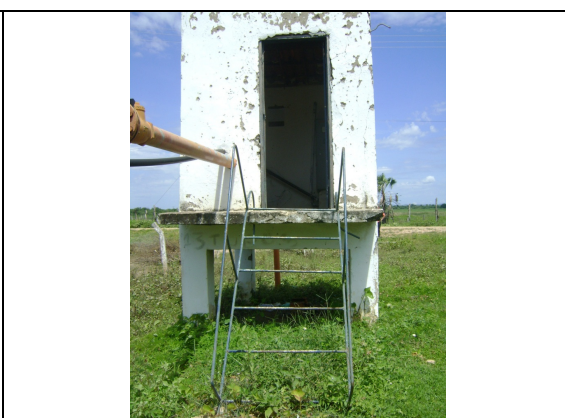
Foto 14 – PT-04: escada de acesso ao poço inadequada e pintura da casa de comando deteriorada.
