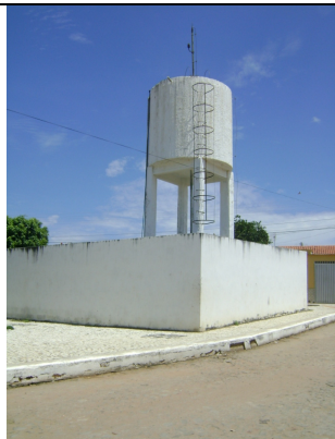
Foto 43 – REL-02: ausência de identificação.
