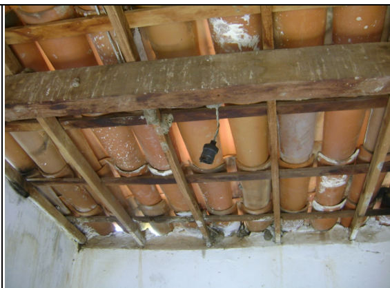
Foto 10 – PT-04: sem iluminação interna.
