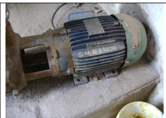
**Foto 9** – EERD-05: base do conjunto motor-bomba sem fixação.
