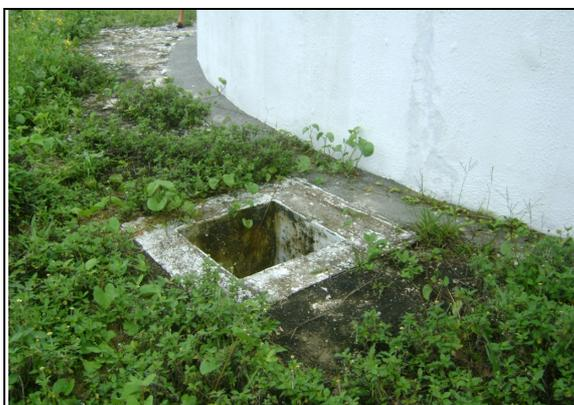
**Foto 17** – RAP-13: caixa de proteção de acessório sem tampa.
