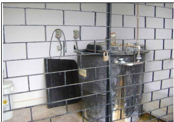
**Foto 19** – RAP-13: estação de aplicação de cloro desativada.
