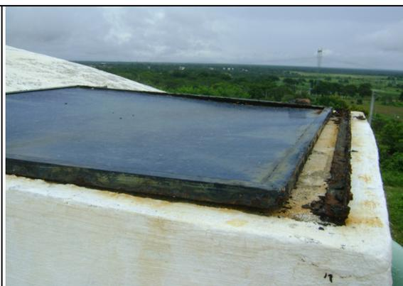
**Foto 14** – RAP-13: tampa de inspeção com processo de oxidação.
