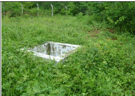
**Foto 16** – RAP-13: caixa de proteção de acessório sem tampa.
