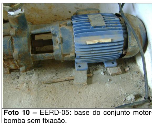
**Foto 10** – EERD-05: base do conjunto motor-bomba sem fixação.
