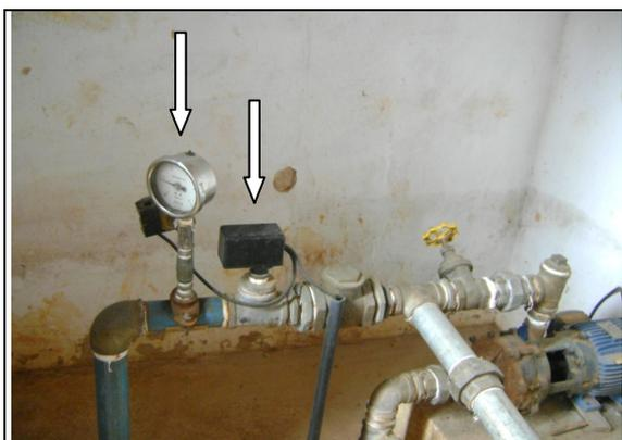
**Foto 4** – Equipamentos de automação da EERD-05.
