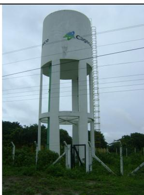
**Foto 25** – REL-02: sem guarda corpo na laje de cobertura.
