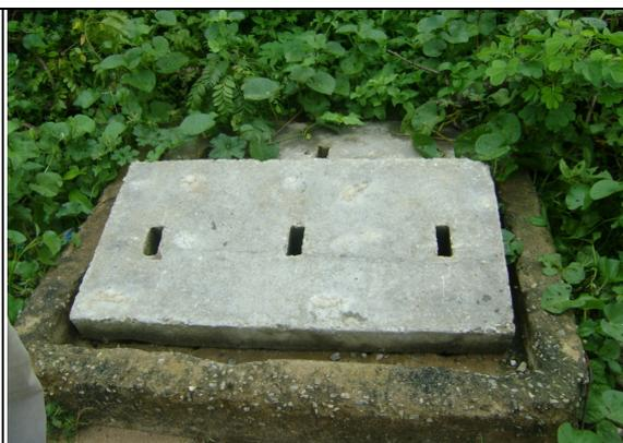
**Foto 2** – Caixa de proteção de acessórios instalados na linha de adução de água tratada do SAA de Barreira.
