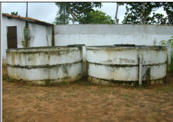
**Foto 21** – RSE-02 e RSE-03: ausência de tubulação de ventilação.
