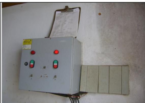
**Foto 5** – Quadro de comando da EERD-05 sem horímetro.
