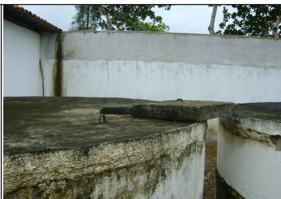
**Foto 23** – RSE-02 e RSE-03: rejuntamento dos anéis danificados.
