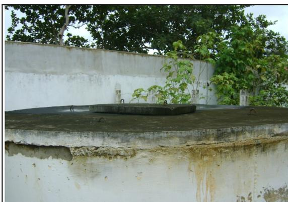
**Foto 22** – RSE-02 e RSE-03: rejuntamento dos anéis danificados.
