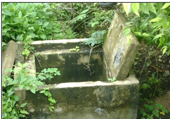
**Foto 3** – Caixa de proteção de registro de descarga instalado na linha de adução de água tratada do SAA de Barreira.
