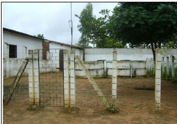
**Foto 20** – RSE-02 e RSE-03: pintura deteriorada e ausência de identificação.
