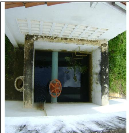
**Fotos 30** - Caixa de descarga do RAP-01 sem drenagem.
