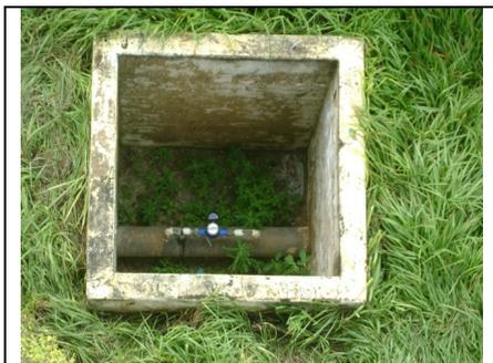
**Foto 32** – Medidor proporcional na entrada do REL-02
