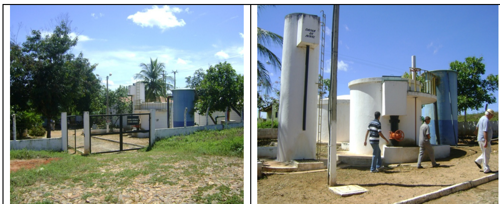
Foto 5 – Vista da entrada da ETA
