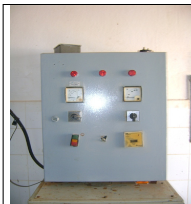
Foto 22 - Quadro de comando da EECS-01
