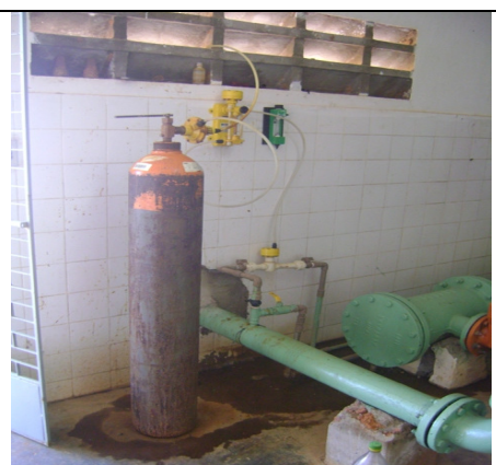
Fotos 14 e 15 – Local inadequado para o sistema de cloro gasoso
