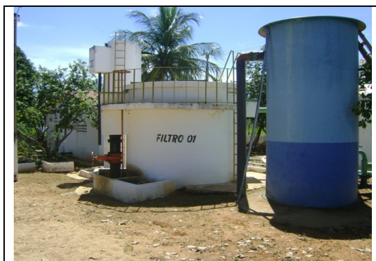
Foto 7 – Vista dos filtros
