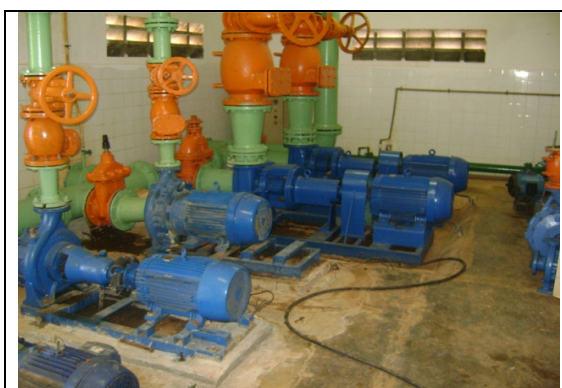
Foto 21 – Vista da EEAT-01 e EELF-01
