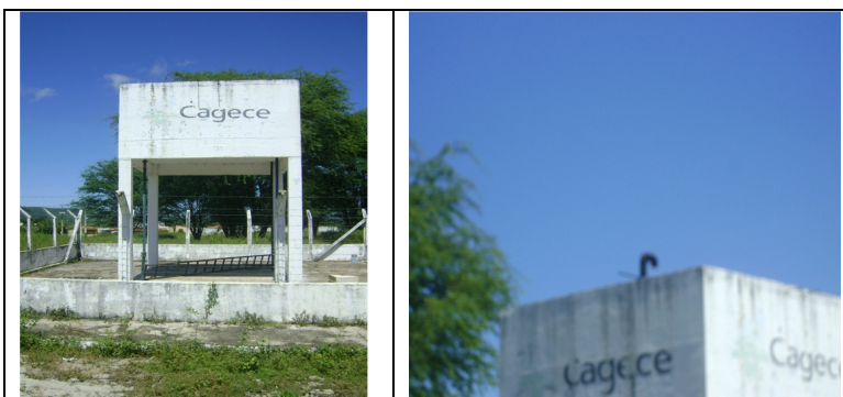
Fotos 26 e 27 – Vistas do REL – 03
