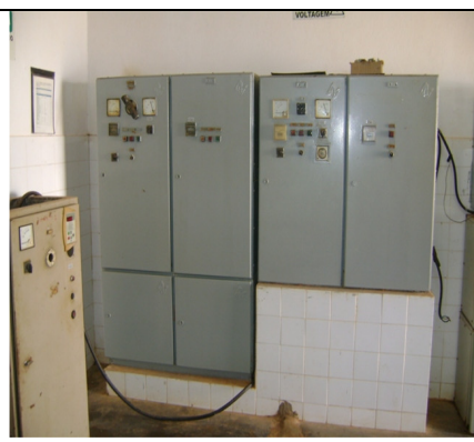
Foto 23 - Quadros de comando da EEAT-01 e EELF-01
