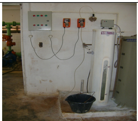
Foto 11 – Sistema de fluoretação
