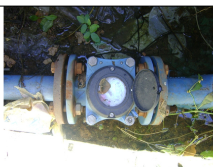
Foto 35 – Macromedidor na saída do REL-03
