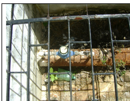
Foto 34 – Medidor proporcional na saída do RAP-03
