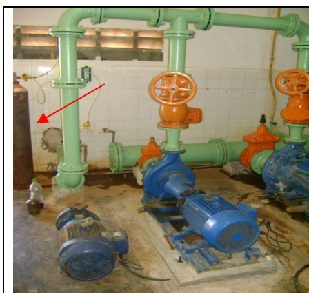
Fotos 14 e 15 – Local inadequado para o sistema de cloro gasoso
