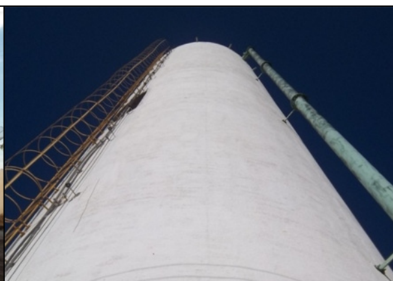
Foto 53 – Escada de acesso ao REL-01.
