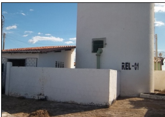
Foto 52 – Vista do REL-01.
