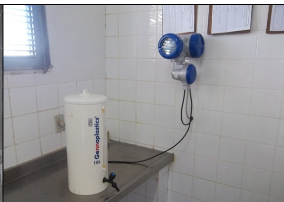
Foto 61 – Leitor do macromedidor de água tratada no laboratório da ETA.
