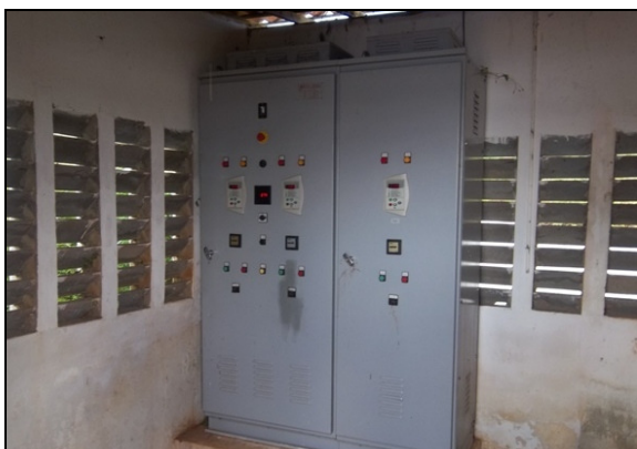
Foto 25 – Quadro de comando das EECS-01 e EECS-01A.
