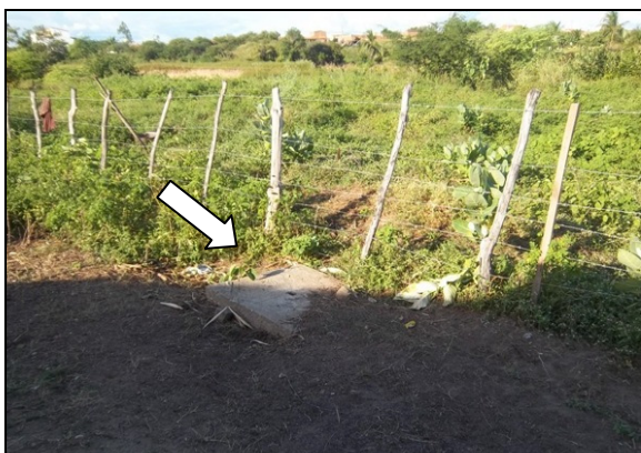
Foto 68 – Registro de descarga localizado na Rua Florianópolis.
