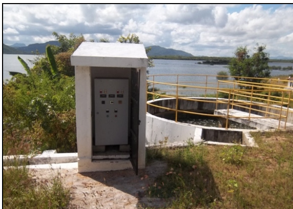
Foto 27 – Quadro de comando da EEAR-01.
