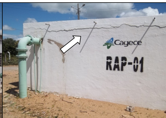
Foto 43 – Rachadura na parede do RAP-01.
