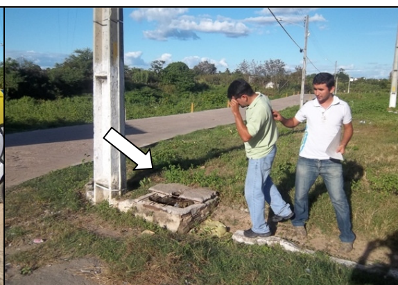
Foto 65 – Registro de descarga soterrado, localizado na Rua Rodrigues Pinto.
