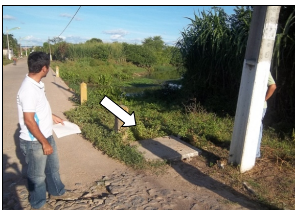
Foto 66 – Registro de descarga localizada na Rua Napoleão Camelo.
