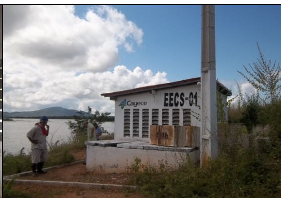
Foto 26 – Prédio de abrigo das EECS-01 e EECS-01A.
