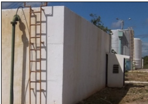
Foto 28 – Prédio de abrigo da EEAD-01.
