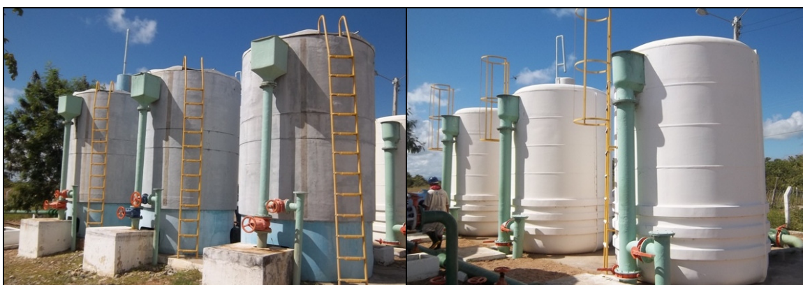
Foto 8 – Vista dos filtros 01, 02 e 03.
