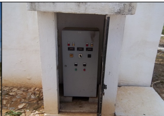
Foto 29 – Quadro de comando da EEAD-01.
