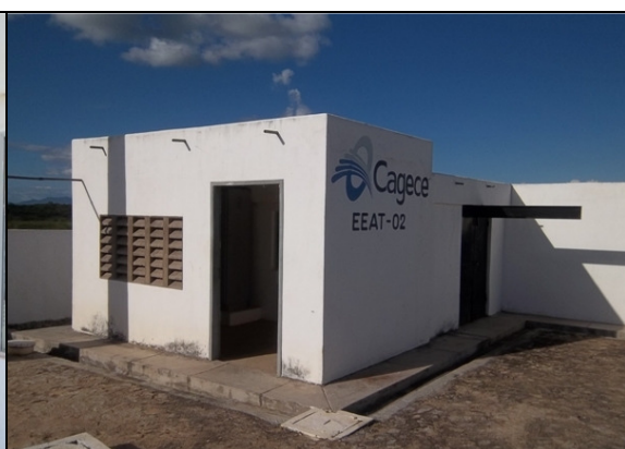
Foto 36 – Prédio de abrigo da EEAT-02.
