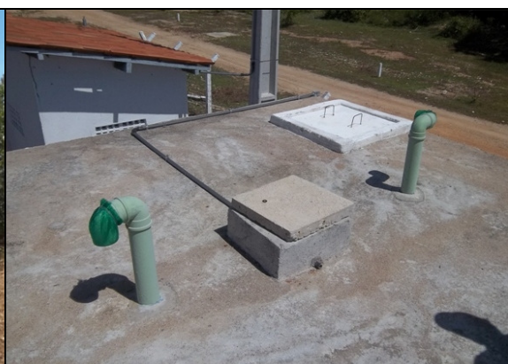
Foto 47 – Tubulações de ventilação e tampa de inspeção do RAP-02.
