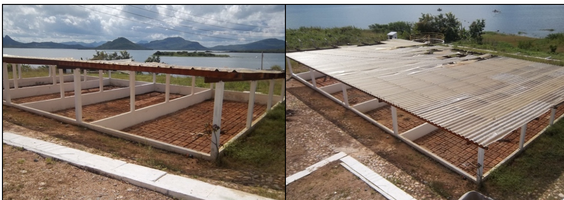
Fotos 6 e 7 – Vistas dos leitos de secagem.
