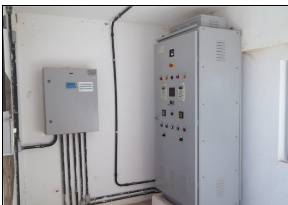
Foto 35 – Quadro de comando da EEAT-02.
