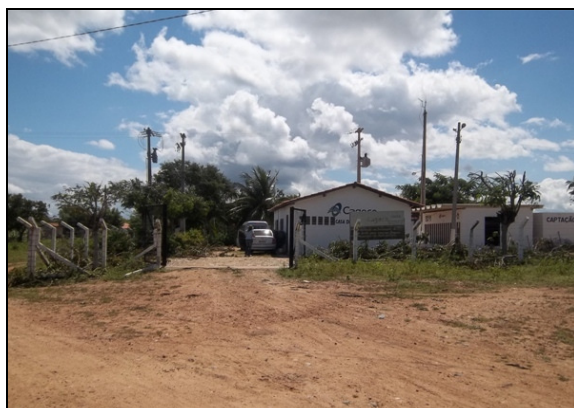
Foto 3 – Entrada da ETA.
