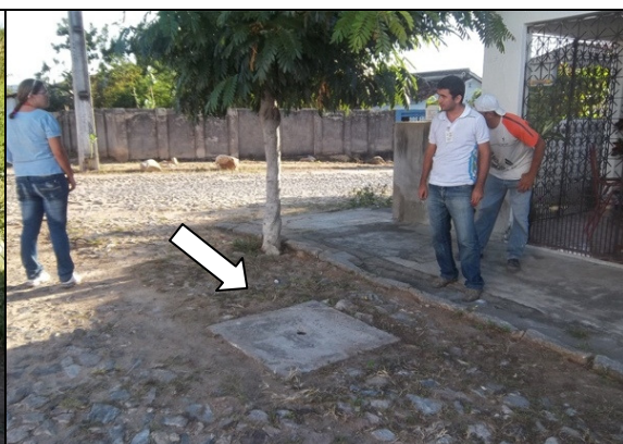
Foto 69 – Registro de descarga, localizado na Rua Luiz Djaniro de Andrade.
