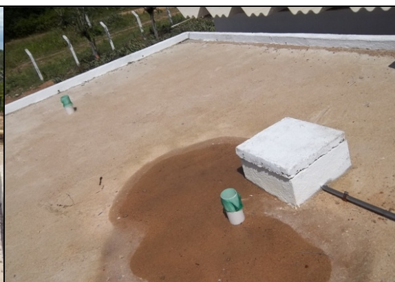
Foto 45 – Tubulações de ventilação do RAP-01.
