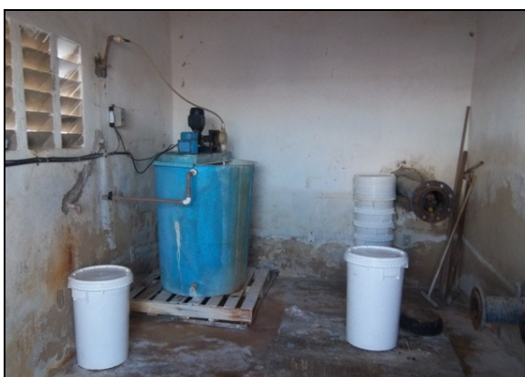
Foto 54 – Estação de pós-cloração.
