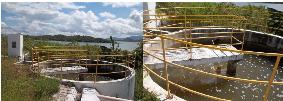
Fotos 40 e 41 – Vistas do Tanque de Reuso.
