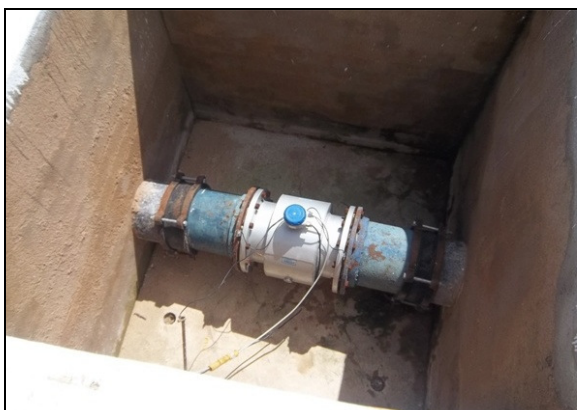
Foto 60 – Caixa do macromedidor de água tratada na saída da ETA, sem tampa de proteção.
