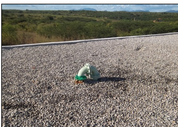
Fotos 50 e 51 – Tubulações de ventilação do RAP-03.
