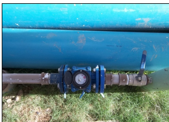
Foto 62 – Macromedidor de água tratada na saída do REL-02, para abastecimento de carro-pipa.
