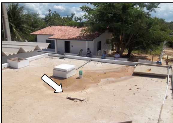
Foto 44 – Rachadura na Laje de cobertura e tampa de inspeção do RAP-01.
