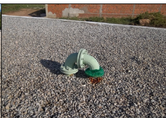
Foto 49 – Tapa de inspeção do RAP-03.
