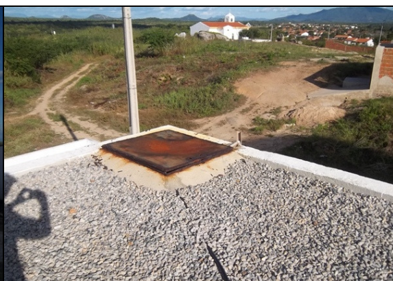
Foto 49 – Tapa de inspeção do RAP-03.
