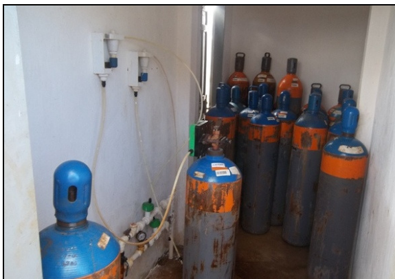
Fotos 13 – Cilindros e dosador de cloro gasoso.
