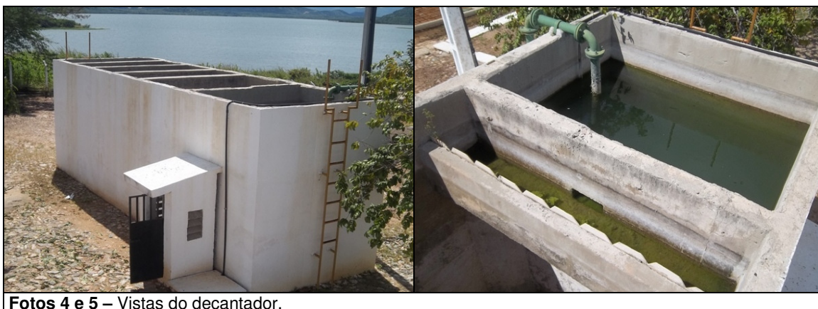
Fotos 4 e 5 – Vistas do decantador.
