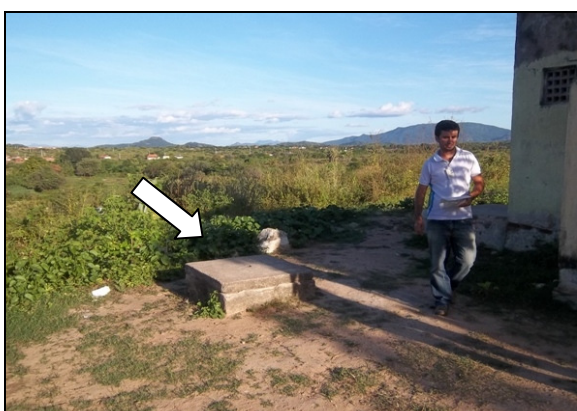
Foto 70 – Registro de descarga localizado na Rua Raimundo Mesquita Sobrinho.
