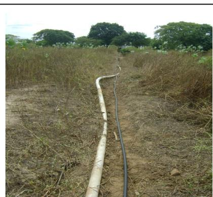
**Foto 7** – Fiação elétrica exposta do PT-02.
