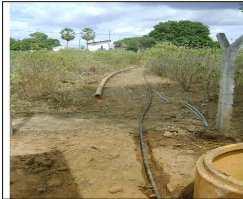
**Foto 12** – Fiação elétrica exposta do PT-07.
