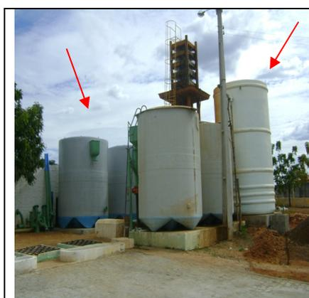
**Foto 19** – Filtros e decantador sendo instalados.
