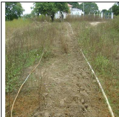
**Foto 15** – Fiação elétrica exposta do PT-08.
