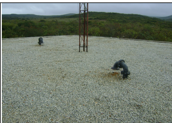
Foto 12 – RAP-11: lastro de brita na laje superior.
