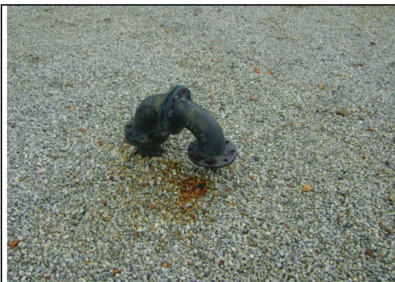
Foto 5 – RAP-11: tubulação de ventilação sem tela de proteção.
