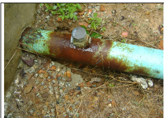
Foto 7 – RAP-11: vazamento na estação pitométrica.
