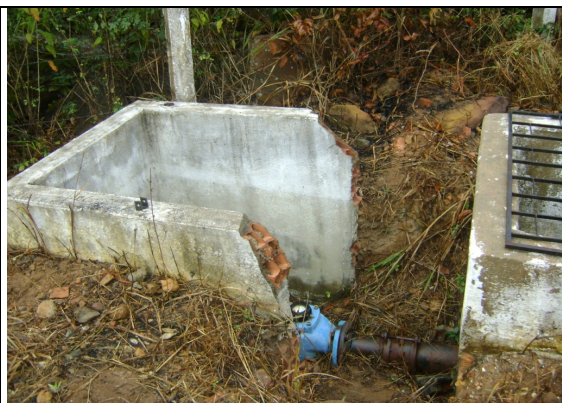
Foto 6 – RAP-11: caixa de proteção do macromedidor quebrada e sem tampa.
