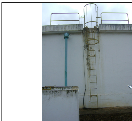
Foto 11 – RAP-11: gaiola protetora na escada de acesso.
