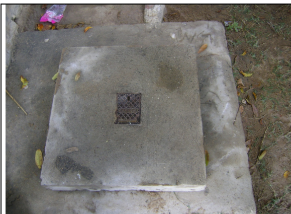
Foto 23 – Registro de descarga localizada na Rua Ministro Antonio Coelho esquina com a Rua Manoel Estórgio.
