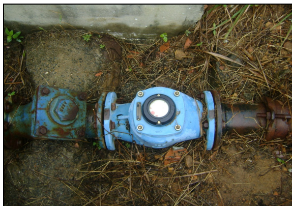
Foto 20 – RAP-11: macromedidor na chegada do reservatório.
