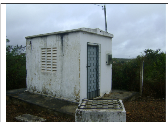
Foto 9 – RAP-11: casa da estação de aplicação de cloro desativada.
