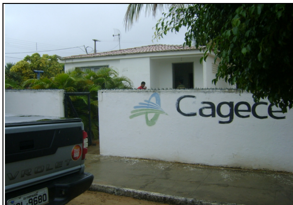
Foto 26 – Vista externa do escritório/loja de atendimento/almoxarifado.
