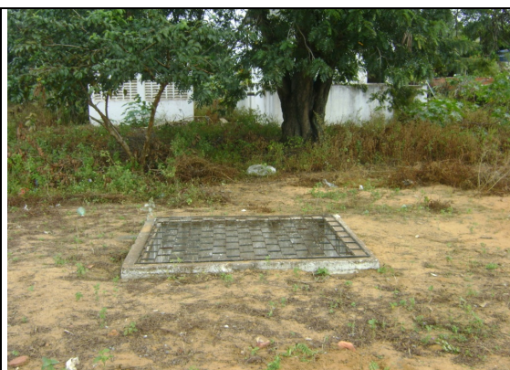
Foto 17 – REL-24: caixas e grades de proteção dos registros com pintura deteriorada.
