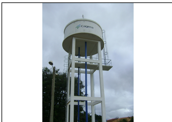
Foto 16 – REL-24: sem guarda corpo na laje de cobertura.
