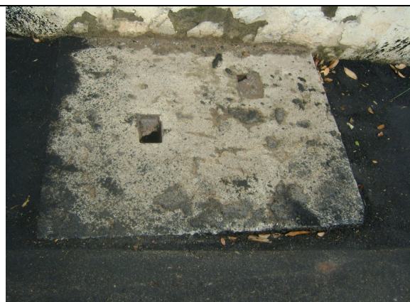
Foto 24 – Registro de descarga localizada na Av. São Vicente na ponte do Rio Inhuçu.
