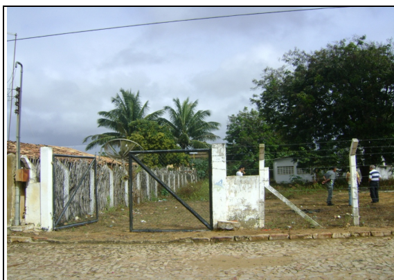
Foto 14 – REL-24: ausência de placa indicativa do local.
