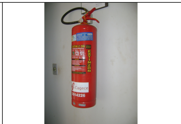
Foto 29 – Extintor de incêndio (localizado no escritório do SAA de Carnaubal).
