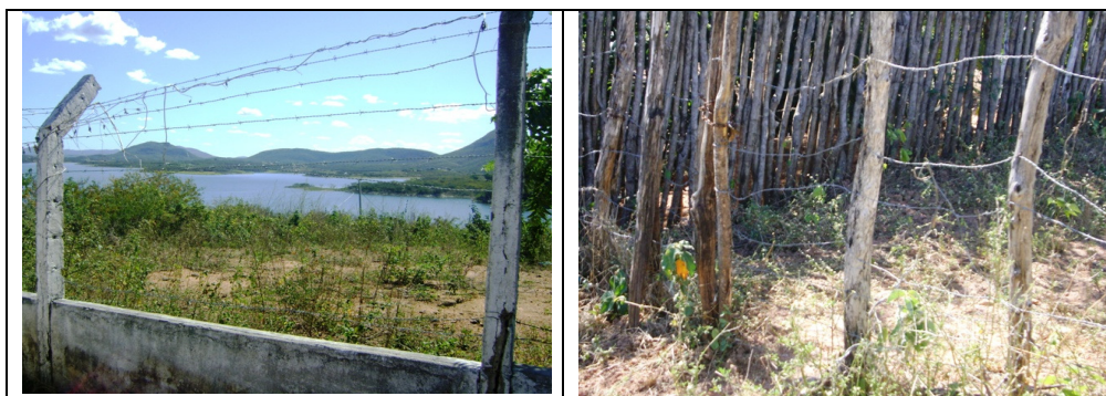
Fotos 3 e 4 – Acesso bloqueado à área da captação
