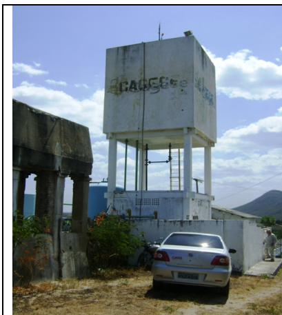
Foto 29 – Vista do REL-01
