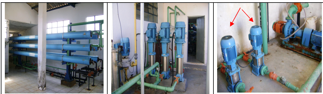
Fotos 7, 8, e 9 – Instalação dos dessalinizadores com os pré-filtros e bombas
