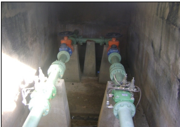
Foto 63 – Macromedidores de água tratada na entrada do REL-04.
