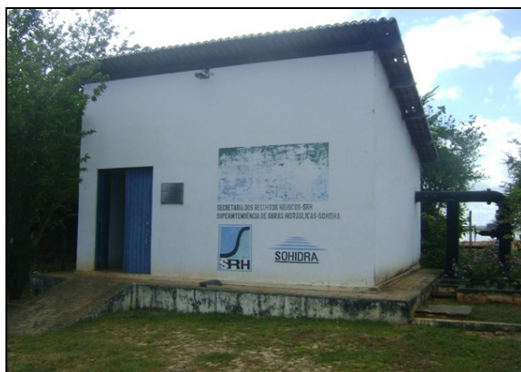
Foto 29 – Prédio de abrigo do quadro da EEAB-01.
