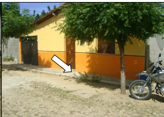
Foto 68 – Registro de descarga, localizado na Rua Major Taumaturgo, Centro.
