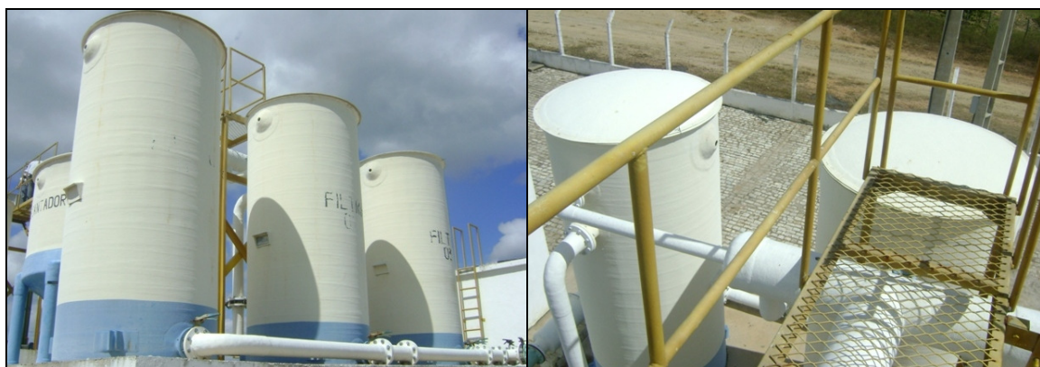
Fotos 9 e 10 – Vistas dos filtros 01, 02 e 03.
