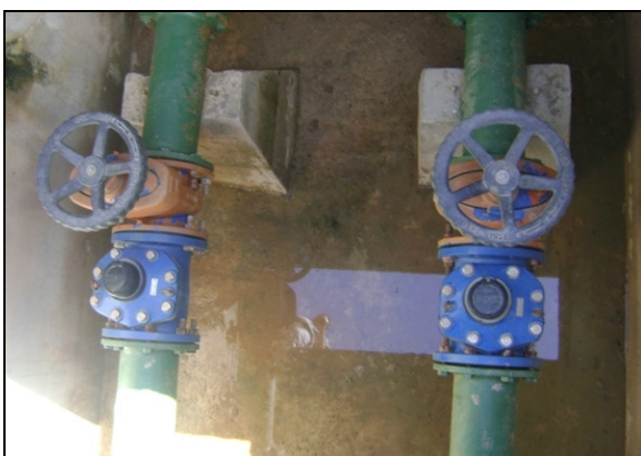
Foto 61 – Macromedidores de água bruta na entrada da ETA.
