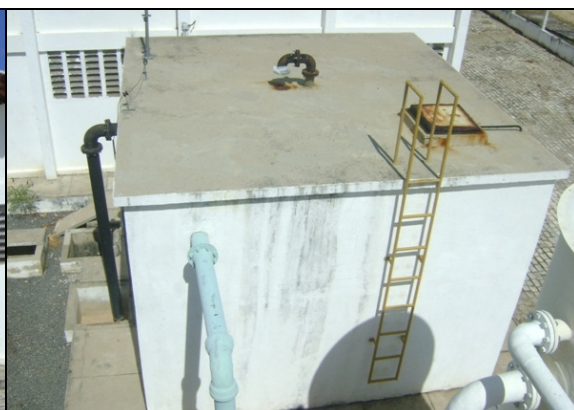
Foto 41 – Inspeção e ventilação do RAP-02.
