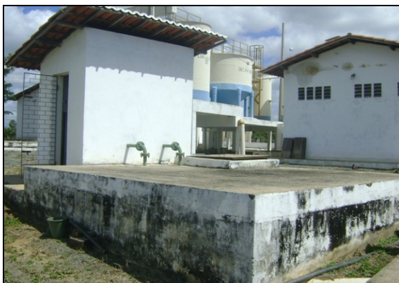
Foto 48 – Vista do Tanque de Reúso.
