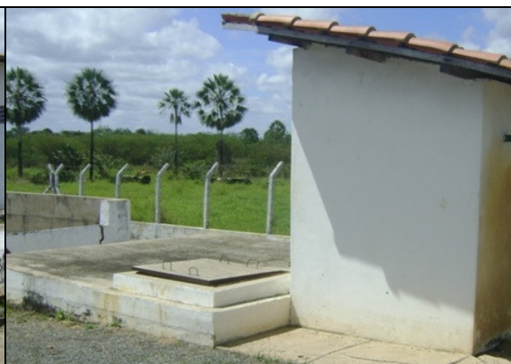
Foto 49 – Inspeção do Tanque de Reúso.
