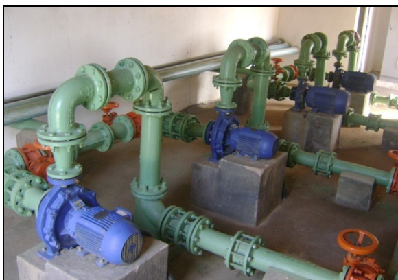
Foto 37 – Elevatórias EEAT-03 e EEAT-04.
