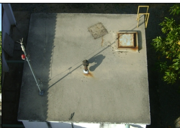
Foto 43 – Inspeção e ventilação do RAP-03.
