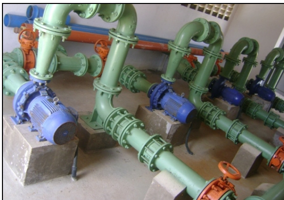
Foto 30 – Elevatórias EELF-01 e EEAT-05.
