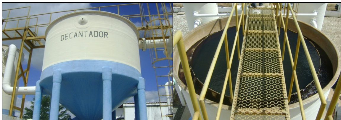
Fotos 7 e 8 – Vistas do decantador.
