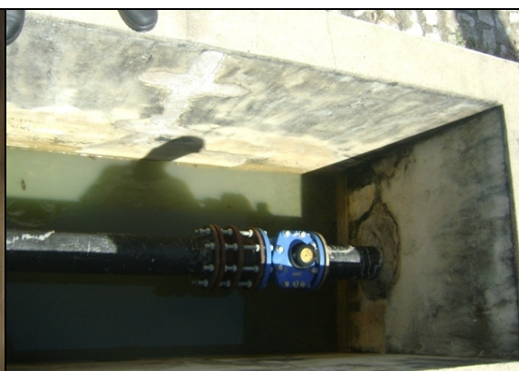
Foto 62 – Caixa do macromedidor de água tratada na saída da ETA, sem tampa.
