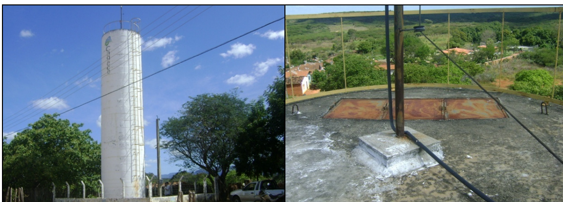
Foto 52 – Vista do REL-02.
