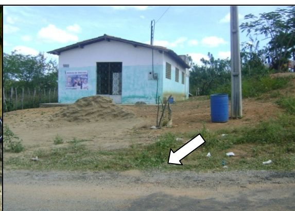
Foto 70 – Registro de descarga soterrado, localizado na Av. Presidente Castelo Branco, Centro.
