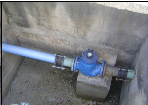
Foto 64 – Macromedidor de água tratada na saída da ETA, para Otavilândia.
