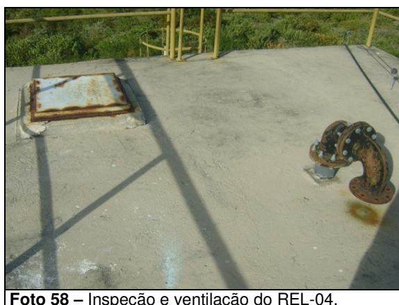
Foto 58 – Inspeção e ventilação do REL-04.
