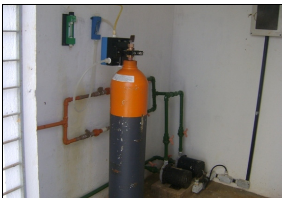
Fotos 17 – Cilindros e dosador de cloro gasoso.
