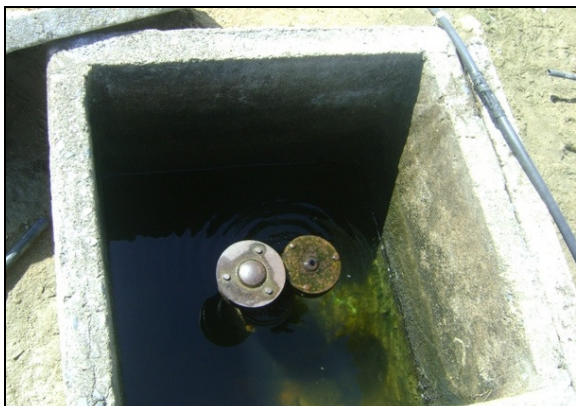
Foto 59 – Vazamento na ventosa da adutora de água bruta.
