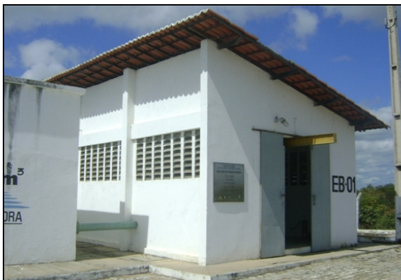
Foto 32 – Prédio de abrigo das EELF-01 e EEAT-05.
