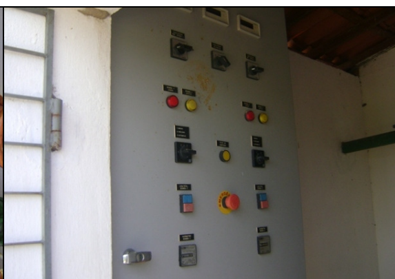
Foto 35 – Quadro de comando da EEAR-01.
