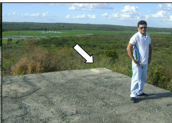
Foto 47 – Inspeção do RAP-04.
