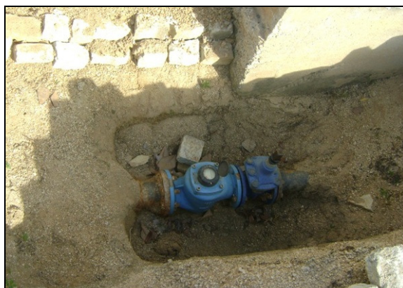
Foto 65 – Macromedidor de água tratada na saída da ETA, para Pires Ferreira, sem caixa de proteção.
