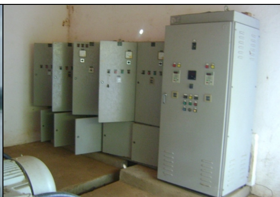
Foto 28 – Quadro de comando da EEAB-01.
