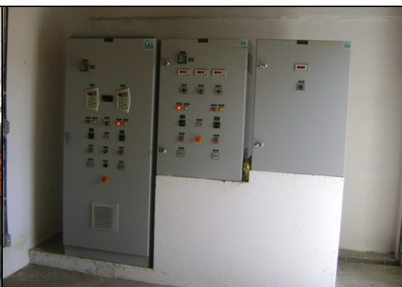
Foto 38 – Quadros de comando das EEAT-03 e EEAT-04.
