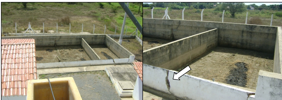
Fotos 11 e 12 – Vistas dos leitos de secagem.
