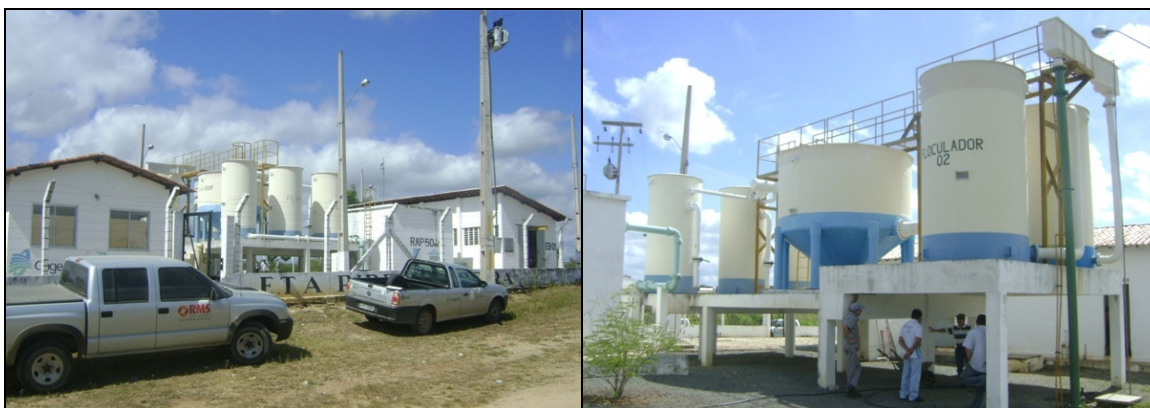
Fotos 3 e 4 – Vistas da ETA.
