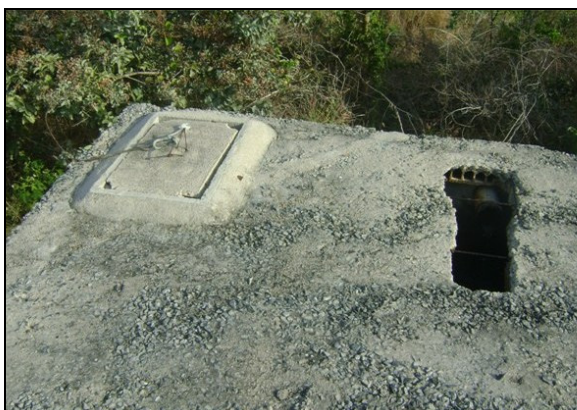
Foto 46 – Laje danificada e inspeção no RAP-04.
