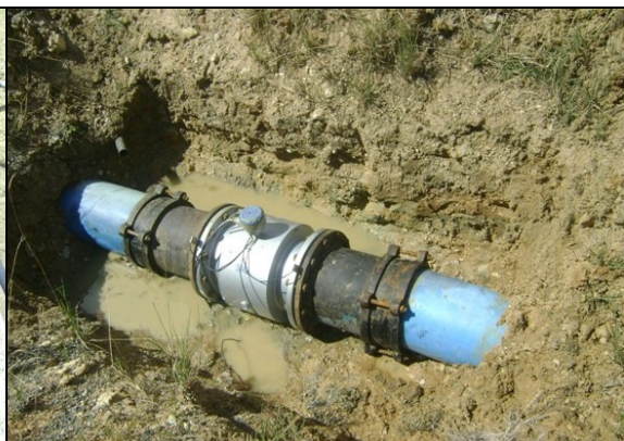
Foto 60 – Medidor eletromagnético de água bruta na entrada da ETA, sem caixa de proteção.
