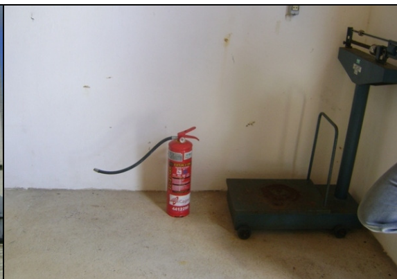
Foto 33 – Extintor de incêndio das EELF-01 e EEAT-05.
