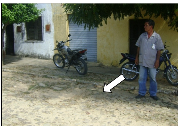
Foto 69 – Registro de descarga soterrado, localizado na Rua Capitão José do Vale, Centro.
