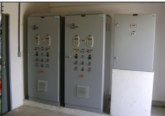
Foto 31 – Quadro de comando das EELF-01 e EEAT-05.
