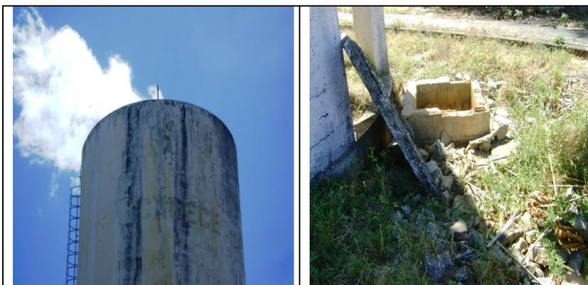
**Fotos 32 e 33 – REL-03: Sinais de vazamento e extravasamento**
