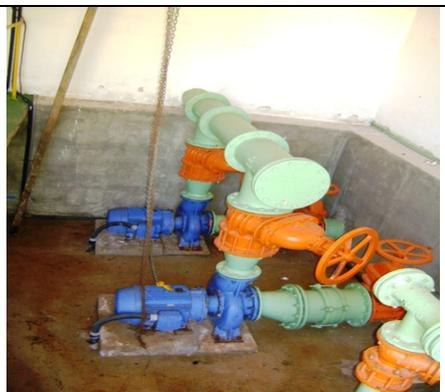
Foto 19 – EELF-01 – conjuntos motores-bomba
