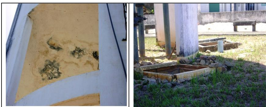
Fotos 28 e 29 – REL-02: Sinais de vazamento e extravasamento
