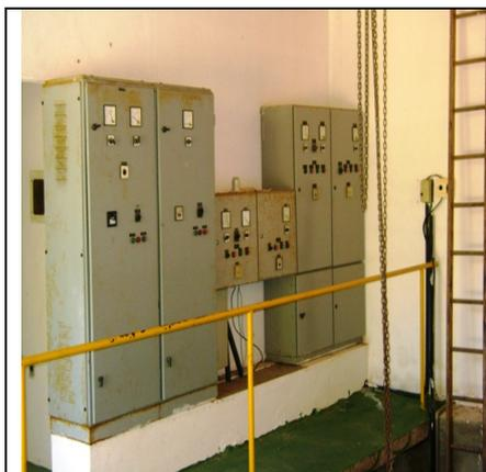
Foto 20 – Quadros de comando das elevatórias EECS-01, EEAT-01 e EELF-01.
