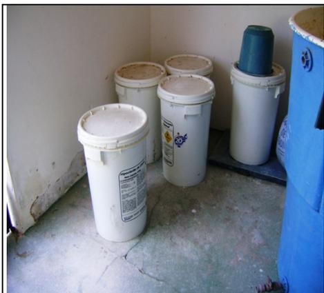
**Foto 12** – Armazenamento inadequado de produtos químicos
