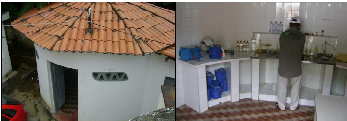
Fotos 12 e 13 – Vistas do laboratório da ETA.
