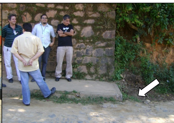
Foto 53 – Registro de descarga soterrado, localizado na Rua João Hipólito, Centro.
