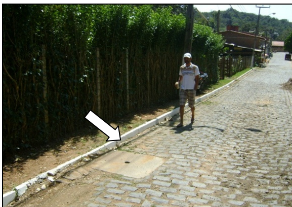
Foto 50 – Registro de descarga localizado na Rua José Marinho Góis, Centro.
