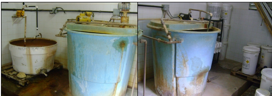
Fotos 9 – Dosadores de PAC e soda cáustica.
