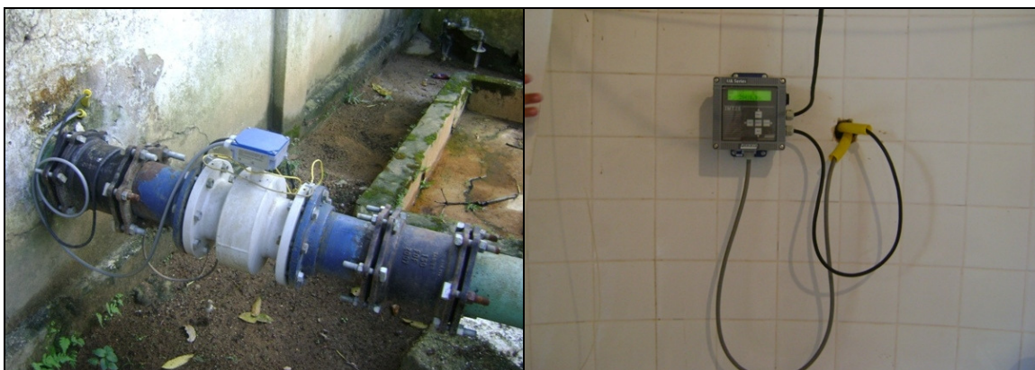
Fotos 45 e 46 – Macromedidor de água tratada na saída da ETA.
