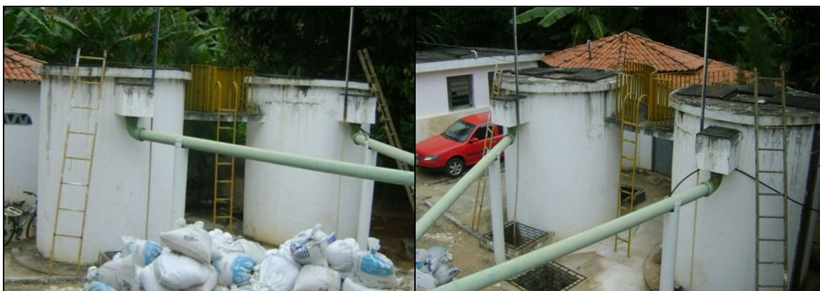
Fotos 5 e 6 – Vistas dos filtros 01 e 02.
