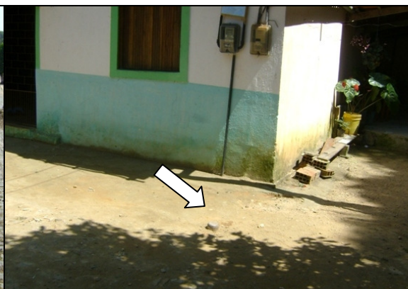
Foto 51 – Registro de descarga, sem caixa, localizado na Rua Duquinha Luz, Centro.
