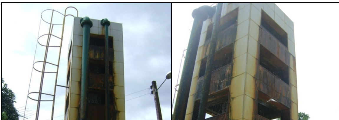
Fotos 3 e 4 – Vistas do Aerador.
