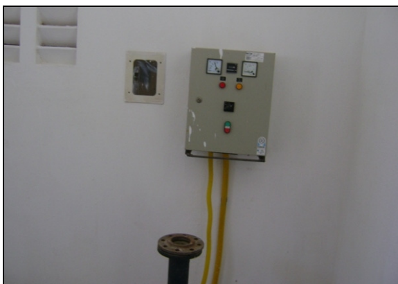
Foto 34 – Quadro de comando da EERD-01.
