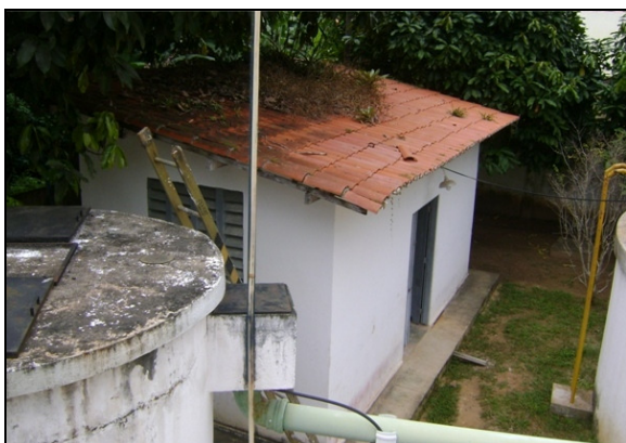
Foto 7 – Vista da casa de química.
