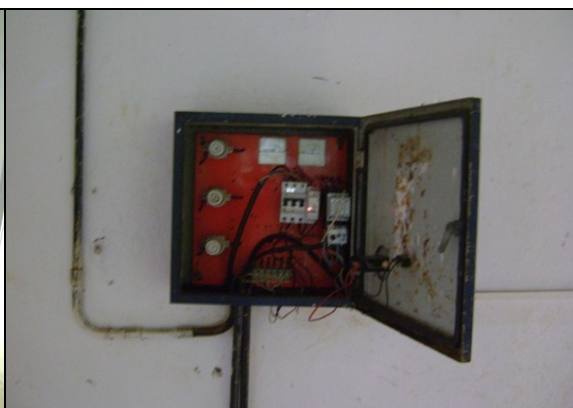
Foto 20 – Quadro de comando da EEPA-01.
