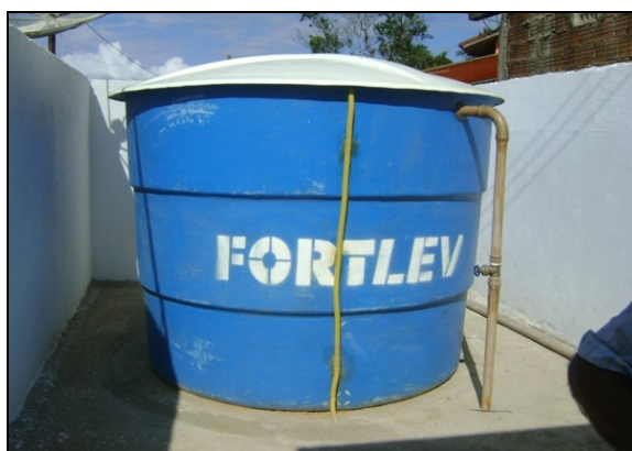
Foto 33 – Elevatória EERD-01, dentro do reservatório.
