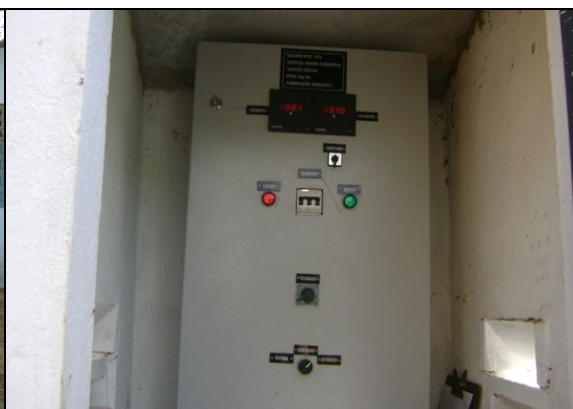
Foto 32 – Quadro de comando da EEPT-10.
