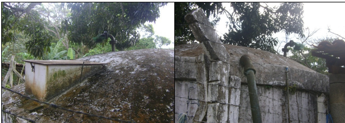
Fotos 42 e 43 – Tampa de inspeção e tubos de ventilação do RAP-03.
