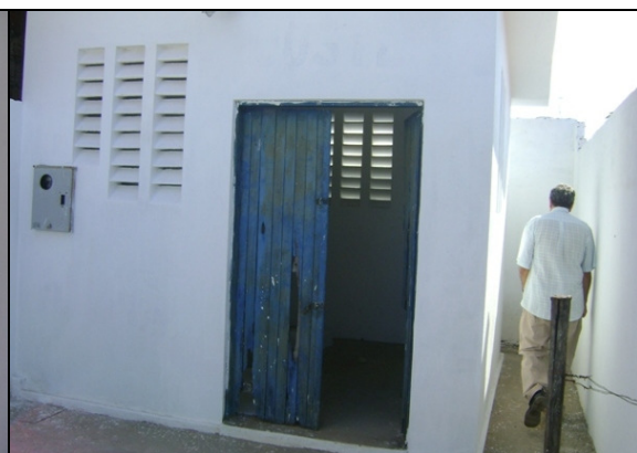
Foto 35 – Prédio de abrigo da EERD-01.
