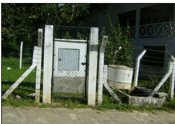
Foto 29 – Prédio de abrigo da EEPT-06.
