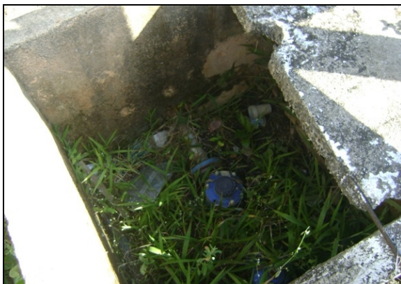
Foto 47 – Macromedidor de água tratada na saída do PT-06.
