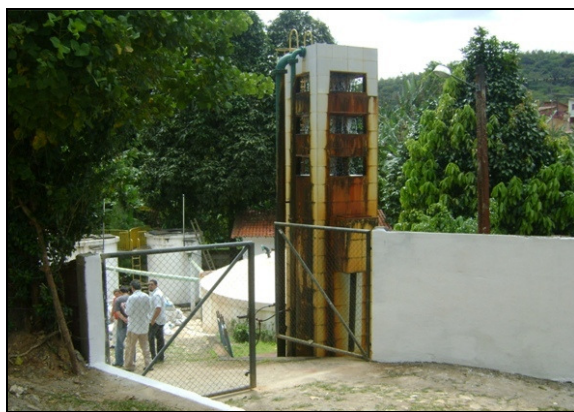
Foto 2 – Entrada da ETA.
