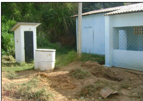
Foto 31 – Prédio de abrigo da EEPT-10.
