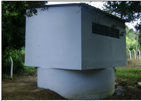
Foto 21 – Prédio de abrigo da EEPA-01.
