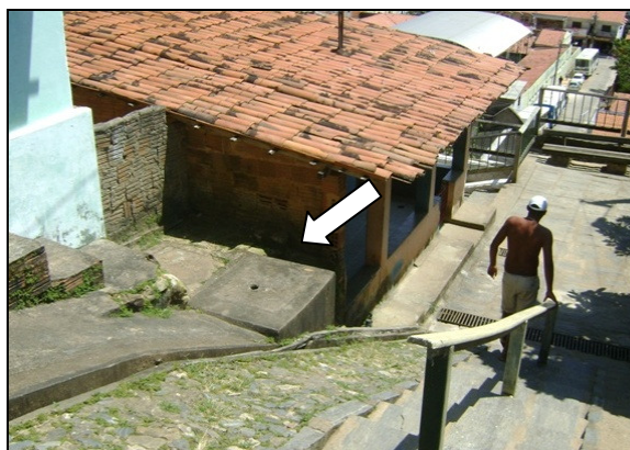
Foto 56 – Registro de descarga, localizado na Rua Luiz Teotônio, Centro.
