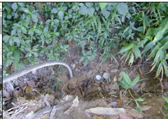
Foto 48 – Macromedidor de água tratada na saída do PT-09, sem caixa de proteção.
