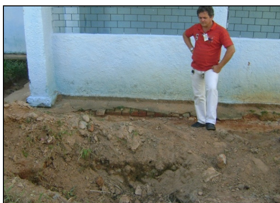
Foto 49 – Macromedidor de água tratada na saída do PT-10, soterrado.
