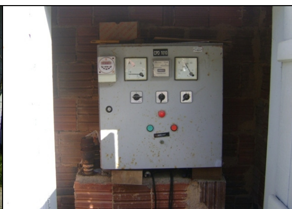
Foto 30 – Quadro de comando da EEPT-06.
