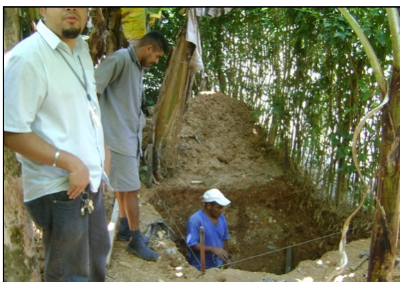
Foto 54 – Registro de descarga, localizado na Rua João Macêdo, Centro.
