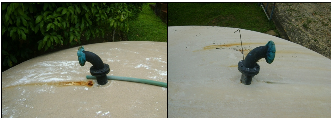
Fotos 37 e 38 – Tubos de ventilação do RAP-01.
