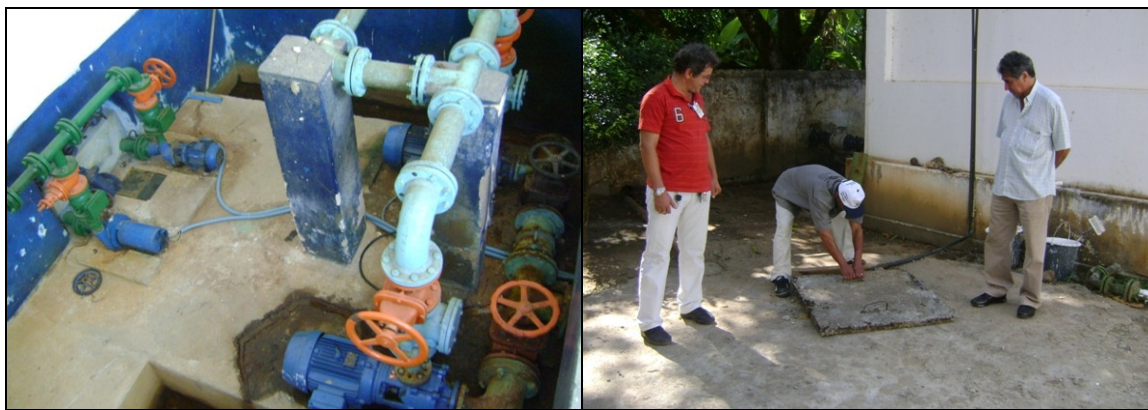
Foto 26 – Elevatórias EEPA-04 e EEAT-01.
