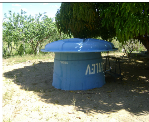
Foto 12 – Tampa do filtro nº 2 da ETA de Assaré.
