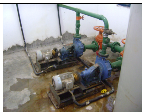
Foto 37 – Ausência de limpeza dos conjuntos motores-bomba.
