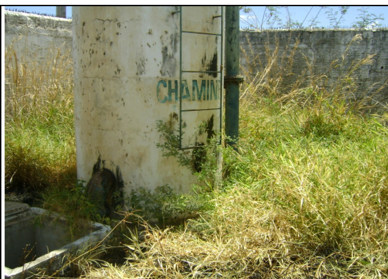
Foto 70 – Pintura deteriorada do tanque e barrilete.
