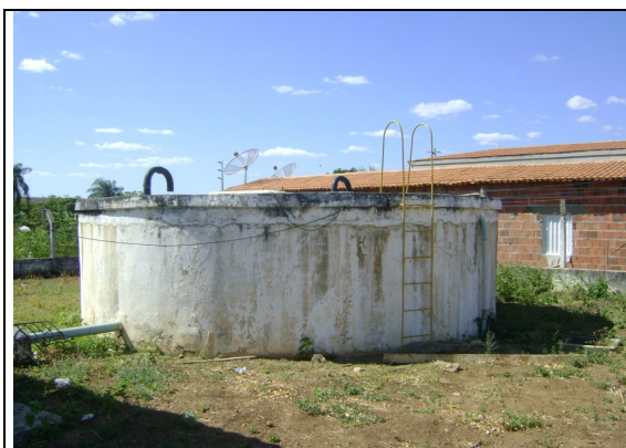
Foto 62 – RSE-01: pintura deteriorada do reservatório.
