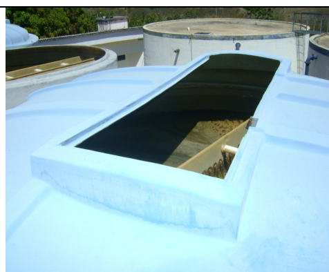
Foto 10 – Filtro nº 1 da ETA de Assaré, sem tampa.
