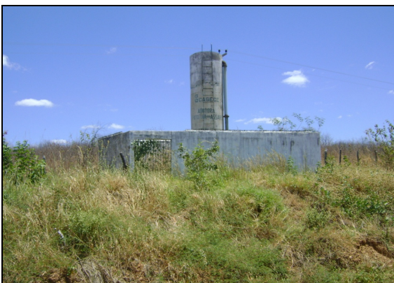
Foto 69 – Acesso ao tanque de amortecimento unidirecional.
