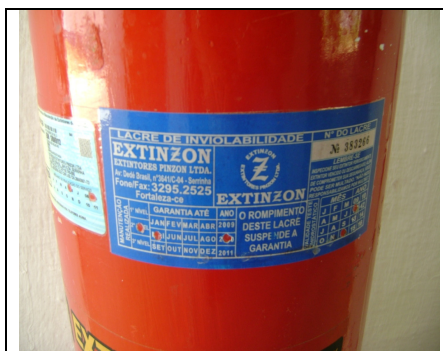
Foto 38 – Extintor de incêndio com prazo de validade vencido.
