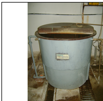
Foto 20 – Tanque de dosagem de produto químico desativado.
