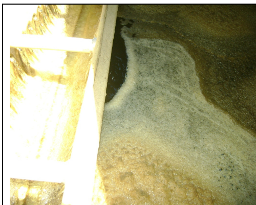
Foto 15 – Material sobrenadante na superfície da água do filtro nº 3 da ETA de Assaré.
