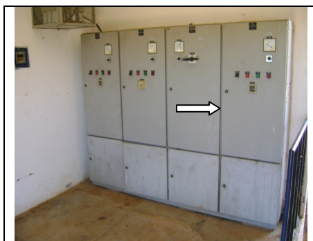
Foto 30 – Quadro de comando da EECS-01.
