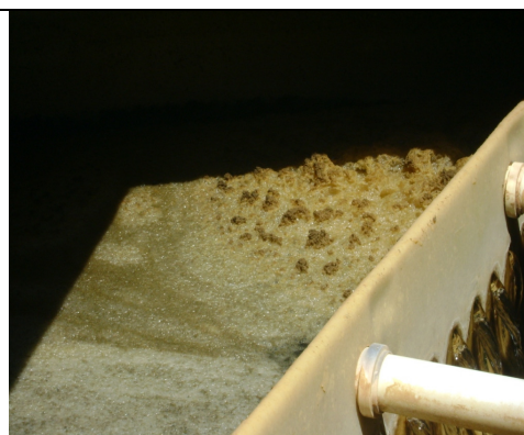
Foto 14 – Material sobrenadante na superfície da água do filtro nº 1 da ETA de Assaré.
