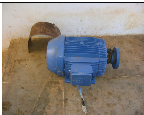
Foto 2 – Motor reserva da EECS localizado na EEAB-01.
