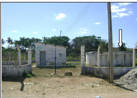
Foto 48 – RSE-01: vista geral e acesso principal.
