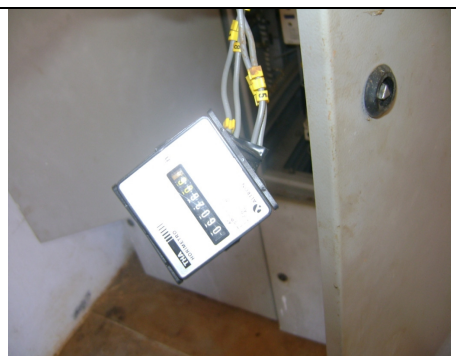
Foto 34 – Horímetro sem fixação no quadro de comando.
