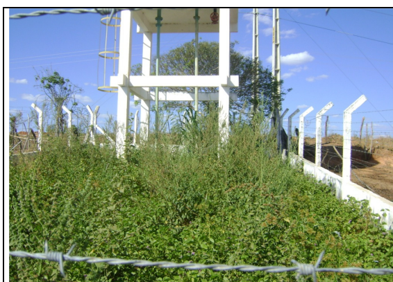
Foto 56 – REL-01: ausência de limpeza da área.
