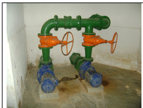
Foto 39 – Ausência de limpeza dos conjuntos motores-bomba.
