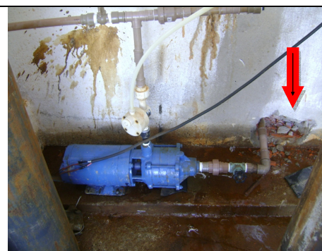
Foto 23 – Buraco na parede da estação de cloro gasoso.
