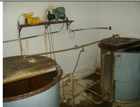
Foto 19 – Tanques de dosagens de produtos químicos.
