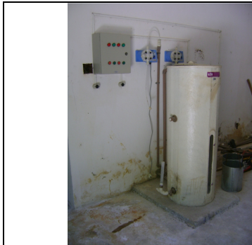
Foto 18 – Sistema de fluoretação sem operação.
