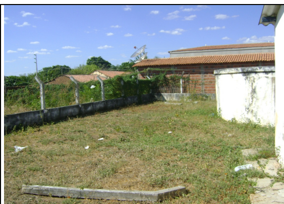
Foto 63 – RSE-01: ausência de limpeza da área.
