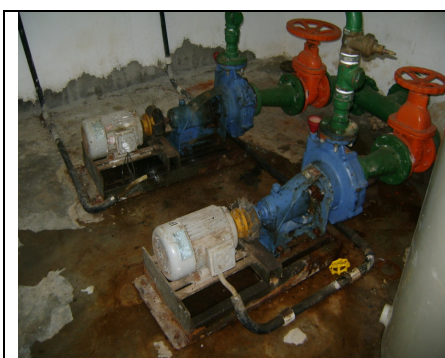
Foto 36 – Sinais de vazamento na gaxeta da bomba.
