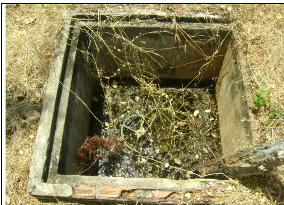
Foto 67 – Registro de descarga com caixa de proteção sem tampa.
