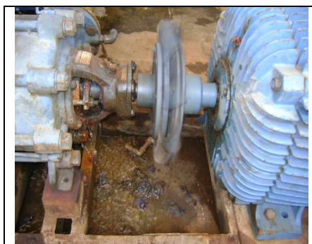
Foto 35 – Sinais de vazamento na gaxeta da bomba.
