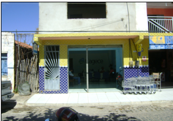
Foto 77 – Vista externa do escritório/loja de atendimento/almoxarifado.
