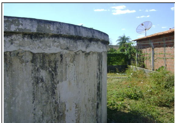
Foto 64 – RSE-01: sinais de vazamento.
