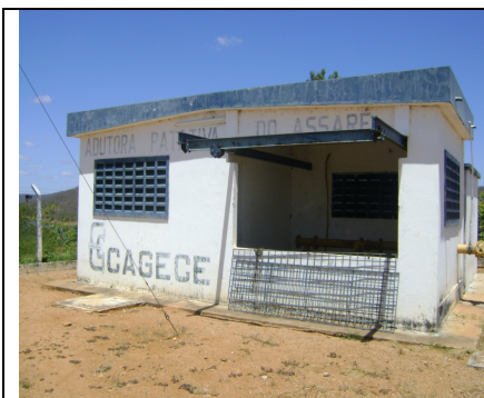
Foto 31 – Pintura deteriorada da casa de proteção.
