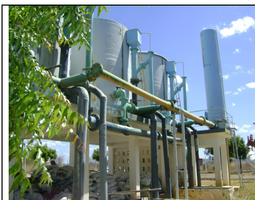
Foto 9 – Pintura deteriorada dos barriletes dos filtros da ETA de Assaré.
