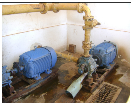
Foto 32 – Pintura deteriorada do barrilete.
