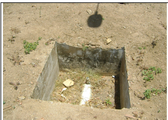
Foto 71 – Estação pitométrica com caixa de proteção sem tampa.
