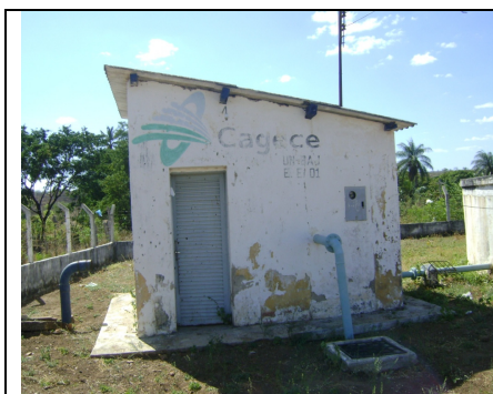
Foto 40 – Pintura deteriorada da casa de proteção do quadro de comando.
