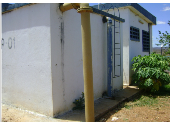
Foto 51 – RAP-01: pintura deteriorada do reservatório.
