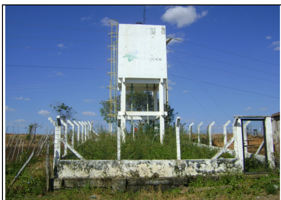
Foto 49 – REL-01: vista geral e acesso principal.
