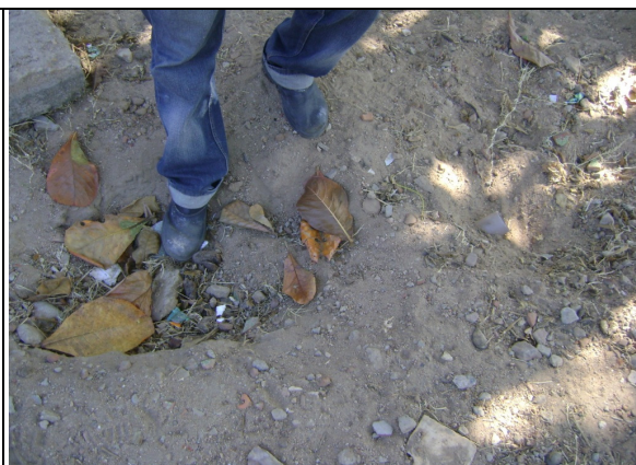
Foto 75 – Registro de descarga localizado na Rua Marechal Amarante, s/n – Centro, final da Rua.
