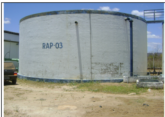
Foto 55 – RAP-03: ausência de medidor de nível.
