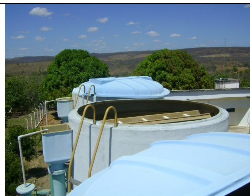
Foto 11 – Filtro nº 2 da ETA de Assaré, sem tampa.
