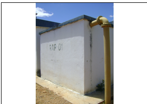
Foto 50 – RAP-01: ausência de medidor de nível.
