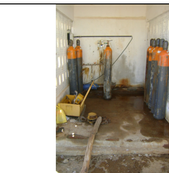
Foto 21 – Casa da estação de cloro gasoso com pintura deteriorada.
