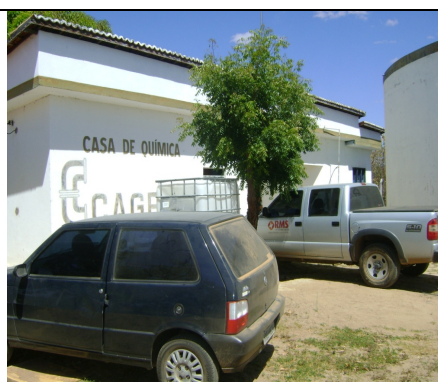
Foto 6 – Vista frontal da Casa de Química da ETA de Assaré.
