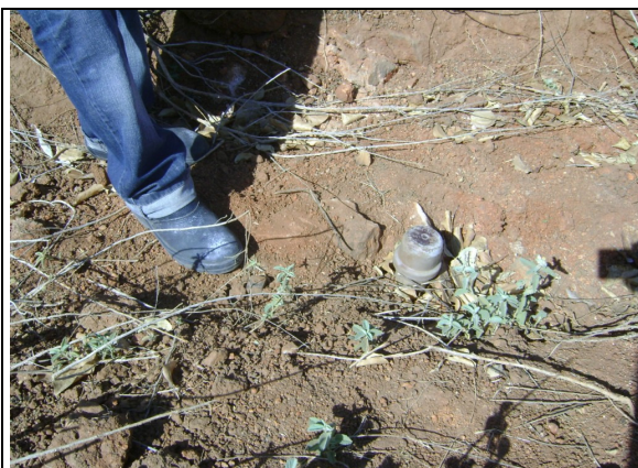
Foto 74 – Registro de descarga localizado na Rua Popular, s/n – Bairro Popular, próximo ao nº 134.
