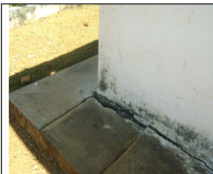
Foto 33 – Calçada do entorno danificada.
