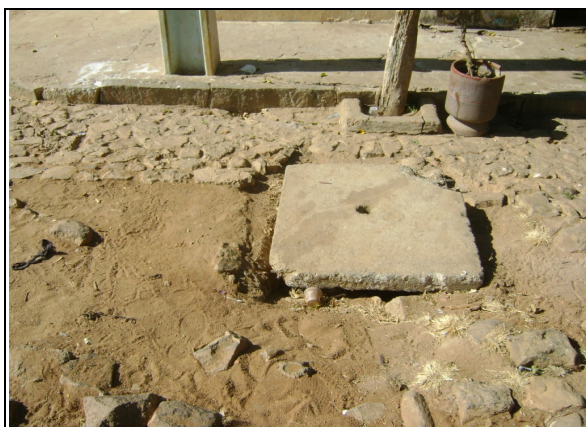
Foto 76 – Registro de descarga localizado na Rua Professora Maria Luísa Leite, s/n – Vila Feliz, final da Rua.
