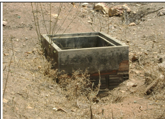
Foto 68 – Ventosa com caixa de proteção sem tampa.
