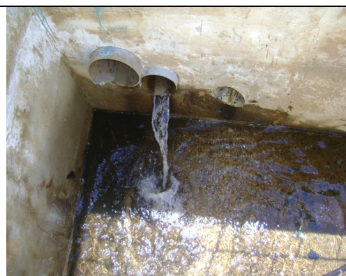
Foto 13 – Registro da retro lavagem do filtro nº 1 da ETA de Assaré, sem vedação.
