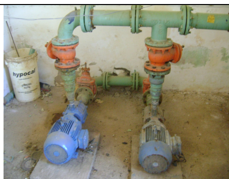
Foto 41 – Ausência de limpeza dos conjuntos motores-bomba.
