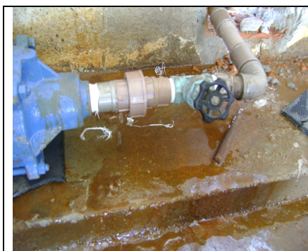
Foto 22 – Sinais de vazamento na bomba injetora da estação de cloro gasoso.
