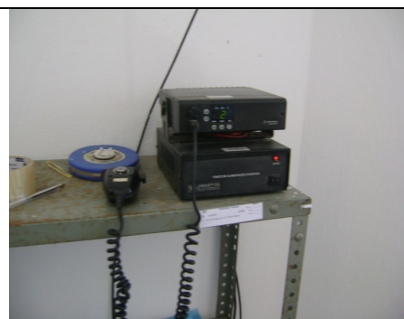
Foto 29 – Sistema de rádio comunicação.
