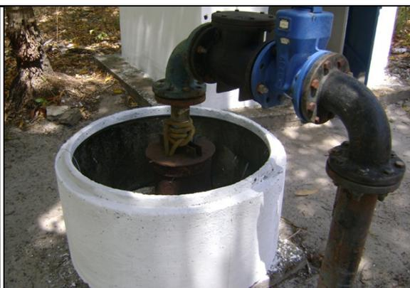
**Foto 11** – PT-03: Tubulação de recalque.
