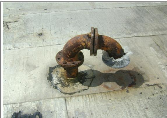
**Foto 44** – RAP-02: Tubulação de ventilação apresentando tela de proteção.
