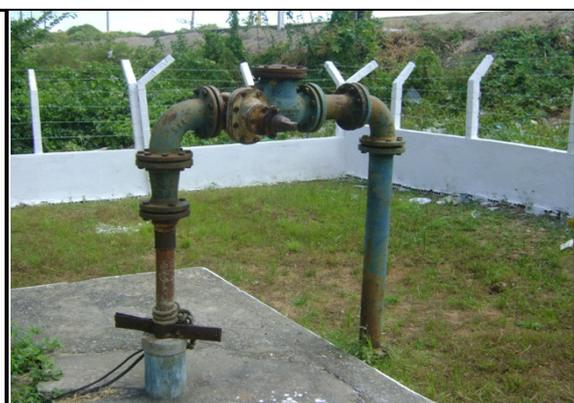
**Foto 7** – PT-02: Tubulação de recalque.
