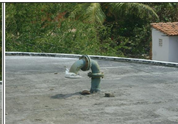
**Foto 42** – RAP-01: Tubulação de ventilação apresentando tela de proteção.
