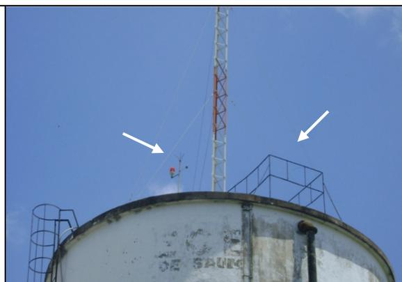
**Foto 52** – REL-02: Existência de guarda corpo na laje superior e de sinalizador noturno.
