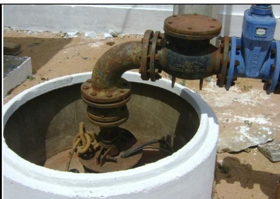
**Foto 16** – PT-04: Tubulação de recalque.
