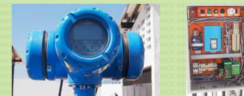
a. Medidor de Vazão Ultrassônico b. Unidade de Transmissão Remota [UTR]
