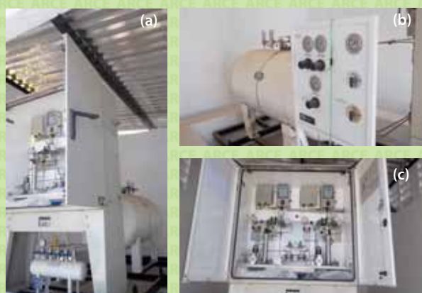
Figura 17. Estação de Odorização Automatizada da EMOG-Maracanaú
