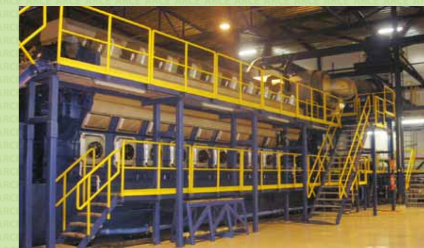
Figura 2 - Grupo moto-gerador em uma usina térmica de geração de energia elétrica. Fonte: Arce
