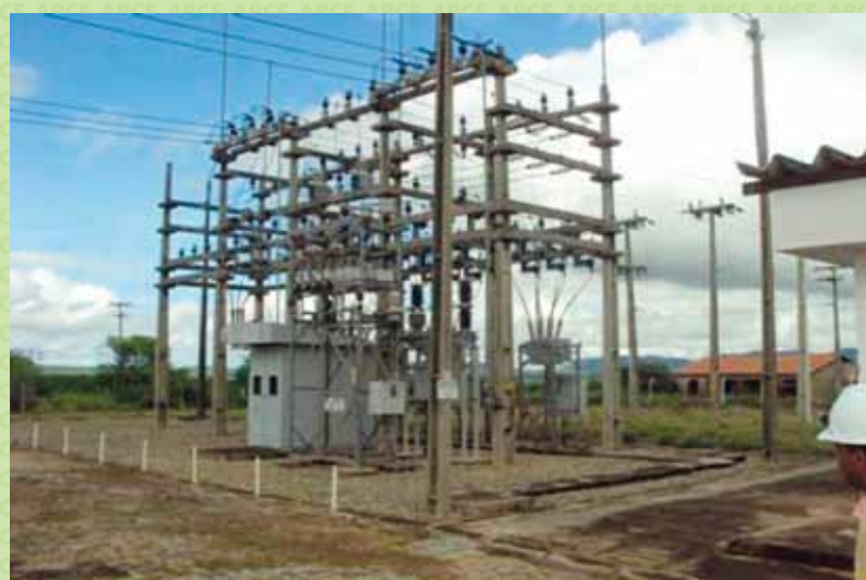
Figura 3 - Subestação de pequeno porte da Coelce, onde se visualiza o barramento de média tensão (15 kV). Fonte: Arce
