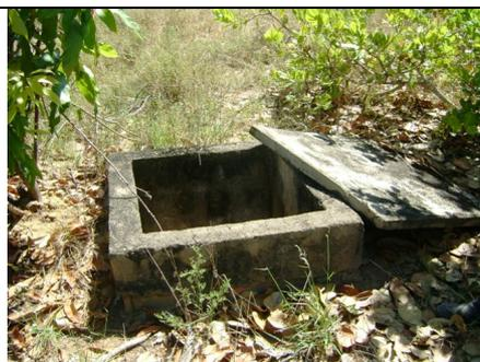
**Foto 34** – Caixa de proteção de registro de descarga aberta
