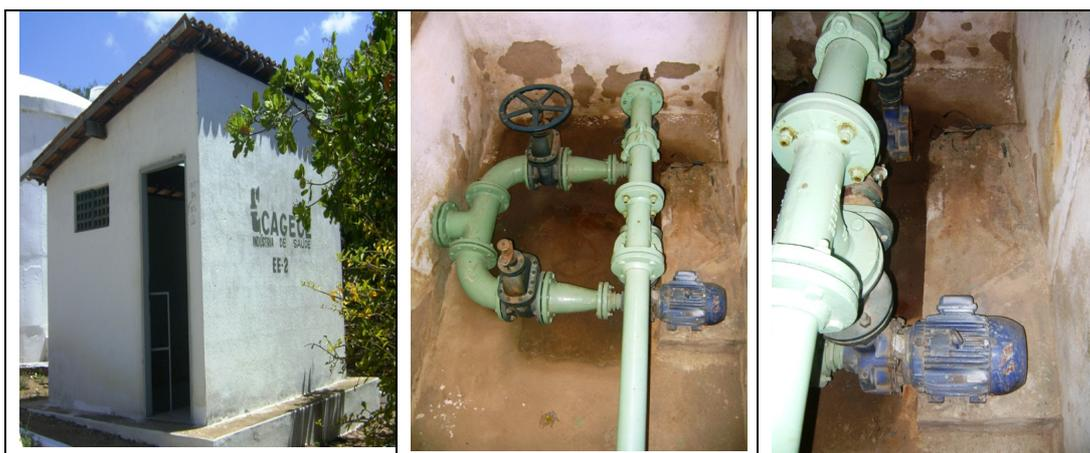
**Fotos 17, 18 e 19** – EEAT-01 - casa de abrigo e detalhes do conjunto motor-bomba
