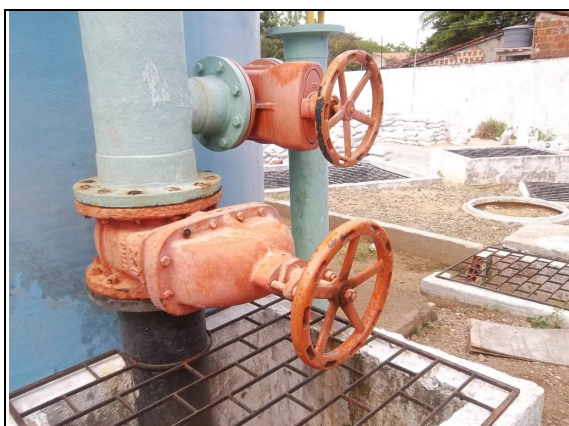
Foto 5 – Filtro 2: registro de descarga sem vedação.
