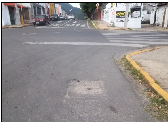
Foto 17 – Registro de manobra localizado na Rua Major Agostinho com a Rua Napoleão Lima.
