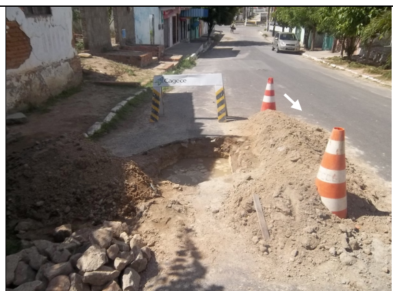
Foto 18 – Conserto de vazamento na rede de distribuição de água, na Rua José Mota, 886 - Coité.
