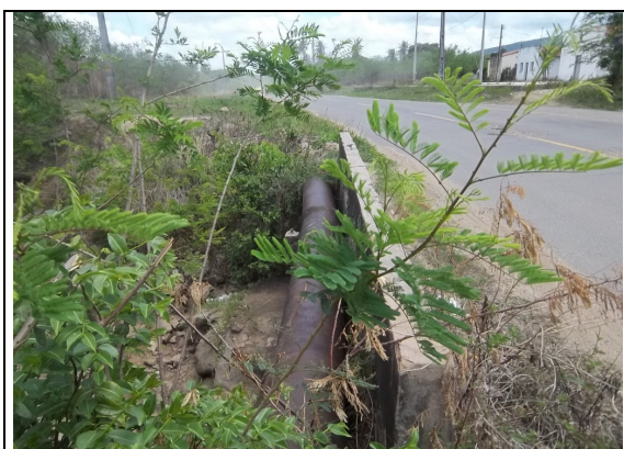
Foto 10 – Adutora de água bruta: trecho de tubulação exposta.
