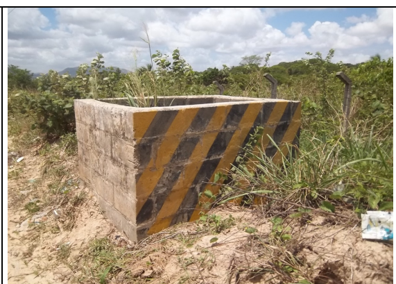
Foto 11 – Adutora de água bruta: caixa de proteção de registro de descarga, sem tampa e com vegetação.
