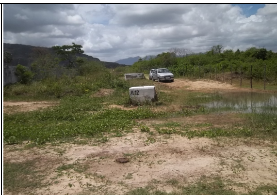
Foto 9 – Adutora de água bruta: sinais de vazamento na caixa do registro de gaveta.
