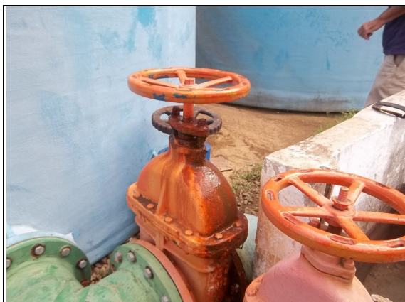
Foto 3 – Filtro 1: registro de lavagem sem vedação.
