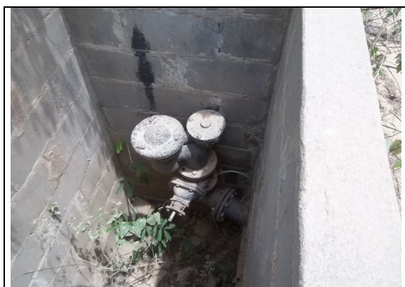
Foto 12 – Adutora de água bruta: caixa de proteção da ventosa, sem tampa.
