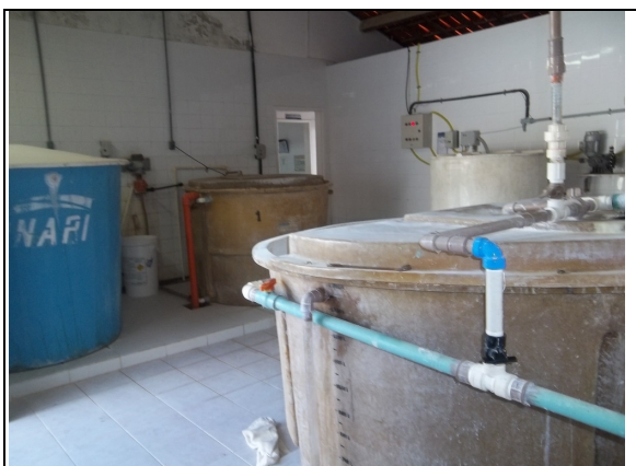
Foto 7 – Casa de química: bombas dosadoras sem reserva.
