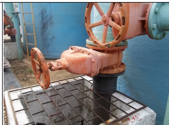
Foto 4 – Filtro 1: registro de descarga sem vedação.
