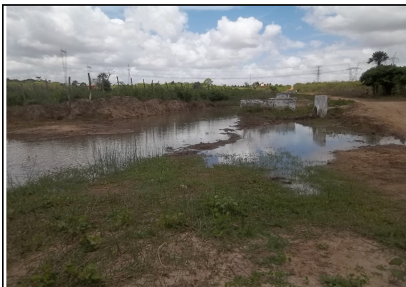
Foto 8 – Adutora de água bruta: sinais de vazamento na caixa do registro de gaveta.
