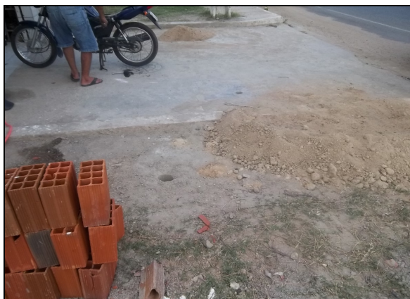
Foto 15 – Registro de manobra localizado na Av. Senador Almir Pinto, 1436 – na entrada da oficina.
