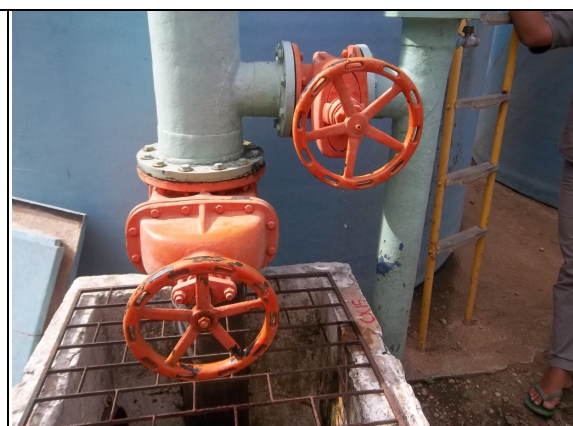
Foto 6 – Filtro 3: registro de descarga sem vedação.
