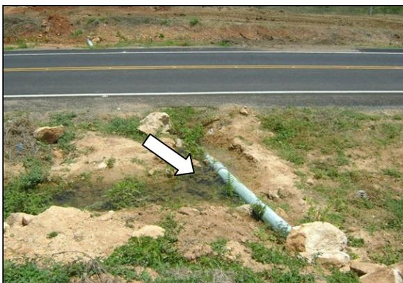
**Foto 26** – Vazamento na adutora de água bruta.
