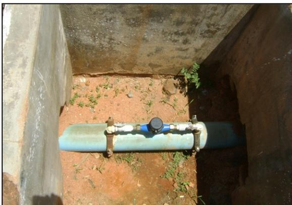
**Foto 24** – Medidor proporcional de água bruta na entrada da área do tratamento.
