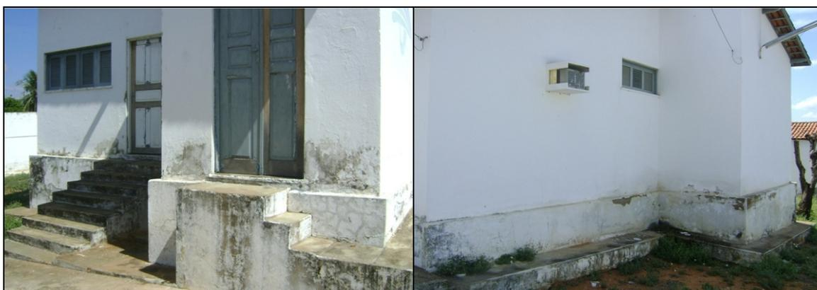
**Fotos 34 e 35** – Pintura e revestimento externo do escritório da CAGECE deteriorados.
