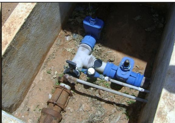
**Foto 25** – Medidor de água tratada para uso geral.
