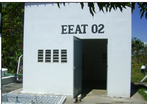
Foto 18 – Prédio de abrigo da EEAT-02.
