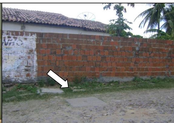
Foto 47 – Registro de descarga localizado na Rua Dr. Epitácio Pinho, Centro.
