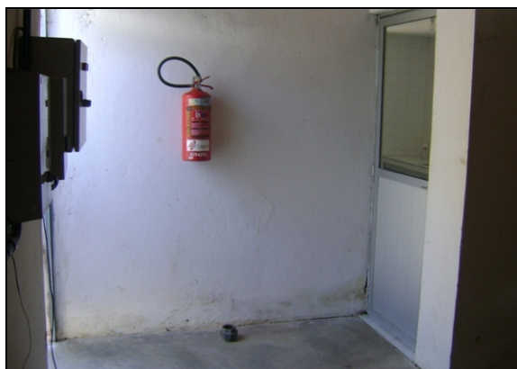
Foto 7 – Extintor de incêndio da casa de química.
