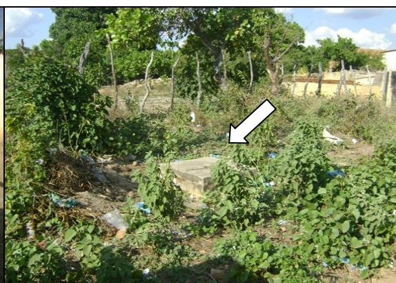
Foto 49 – Registro de descarga localizado na Rua Jericó III, Jardim das Oliveiras.
