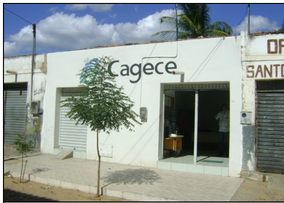
Foto 50 – Vista externa do escritório da CAGECE.
