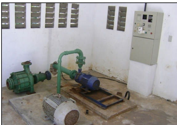
Foto 15 – Elevatória EEAT-02 e quadro de comando.
