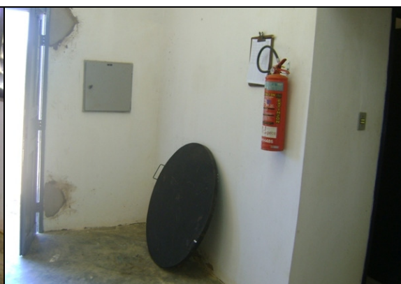
Foto 24 – Quadro de comando da EEAT-04.
