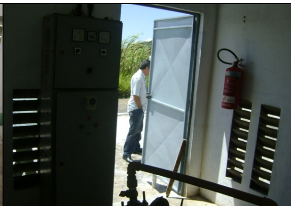
Foto 20 – Quadro de comando da EEAT-03 e extintor de incêndio.
