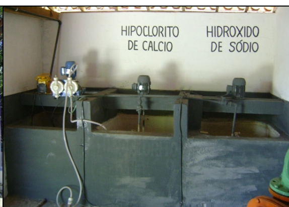
Foto 4 – Dosadores de hipocal e hidróxido de sódio.
