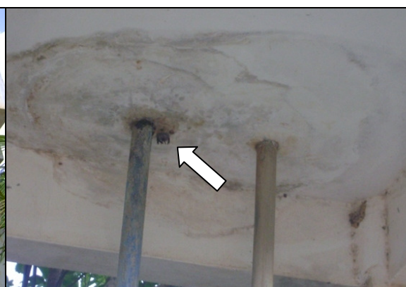
Foto 42 – Vespas e infiltração na laje do REL-03.
