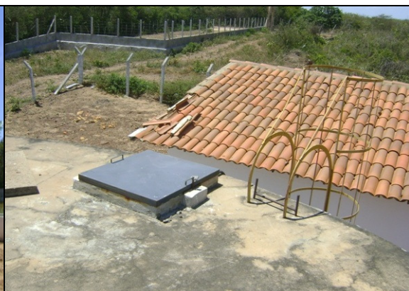
Foto 37 – Inspeção e escada do RAP-02.
