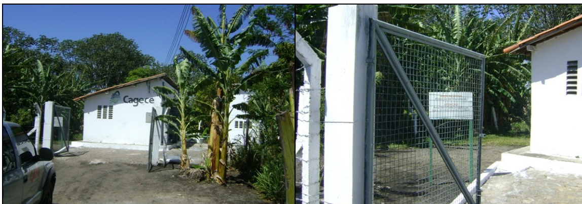
Foto 1 – Área destinada à captação e ao tratamento.
