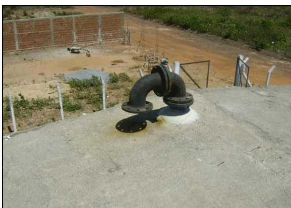
Fotos 29 e 30 – Ventilações do RAP-01.
