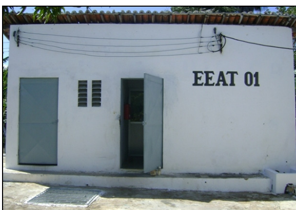
Foto 3 – Vista da casa de química e do prédio de abrigo da EEAT-01 e do quadro de comando da EEPA-01.
