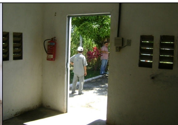
Foto 16 – Extintor de incêndio da EEAT-02.
