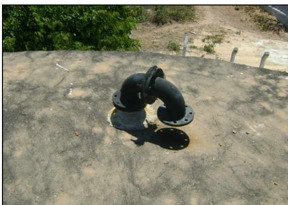
Fotos 38 e 39 – Ventilações do RAP-02.
