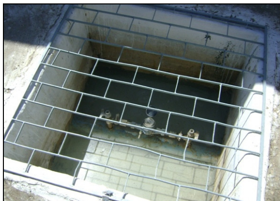
Foto 43 – Medidor proporcional de água tratada na saída do tratamento.
