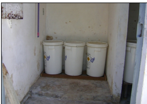
Foto 5 – Produtos químicos do tratamento.
