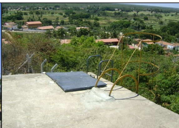
Foto 28 – inspeção e escada do RAP-01.
