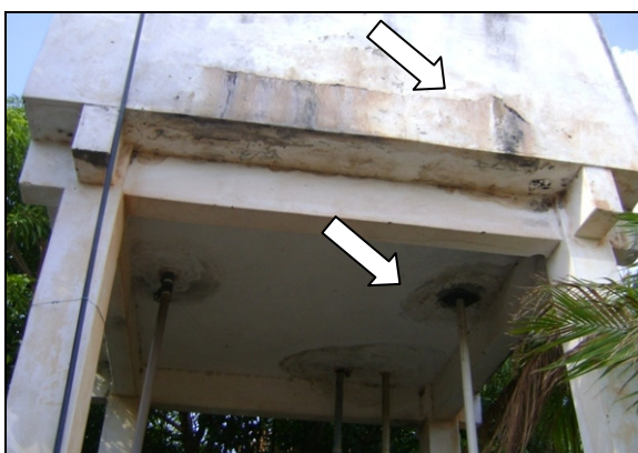
Foto 41 – Reboco e pintura deteriorados e infiltração na laje do REL-03.
