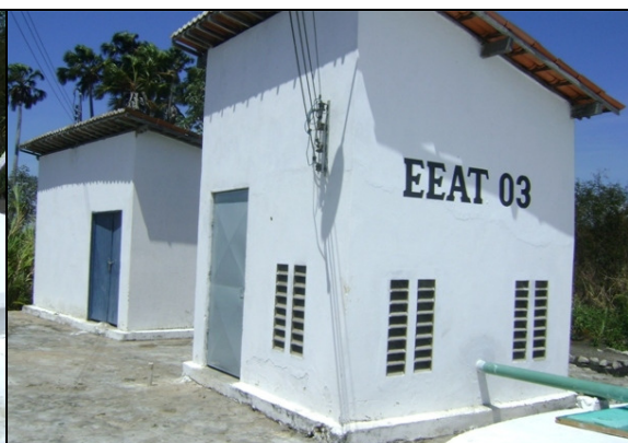
Foto 22 – Prédio de abrigo dos quadros da EEAT-03.
