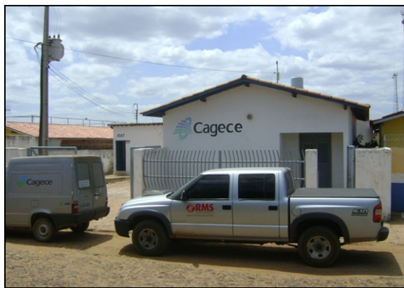
Foto 40 – Vista externa do escritório da CAGECE.
