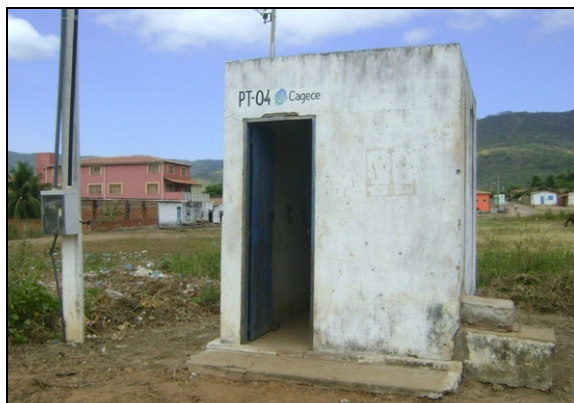
Foto 11 – Prédio de abrigo do PT-04 e do quadro de comando da EEPT-04.
