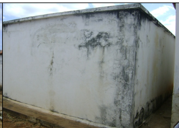
Foto 27 – Infiltração e pintura deteriorada na parede do RAP-01.
