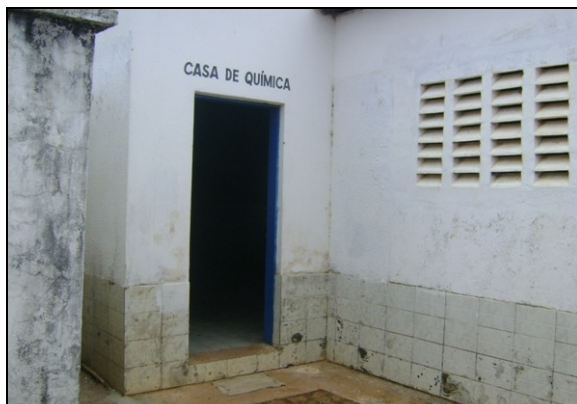
Foto 13 – Vista da casa de química.
