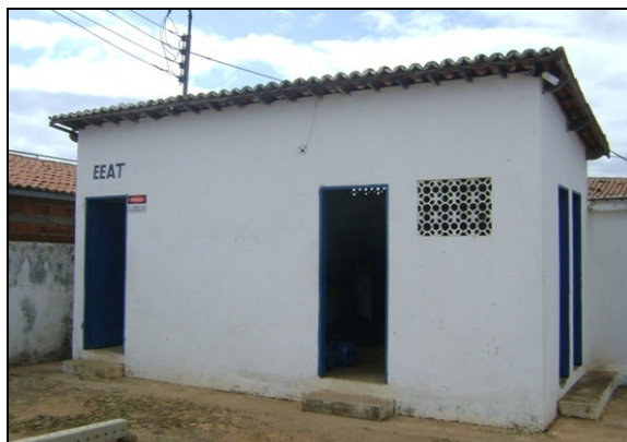
Foto 25 – Prédio de abrigo das elevatórias EEAT-01 e EEAT-02.
