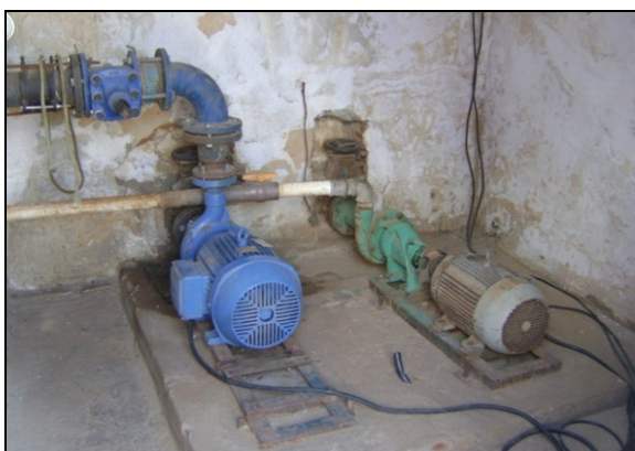
Foto 23 – Elevatórias EEAT-01 e EEAT-02.
