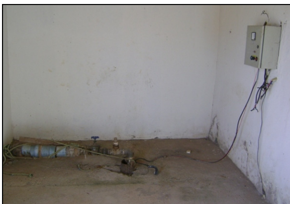
Foto 7 – Poço PT-03 e quadro de comando da EEPT-03.
