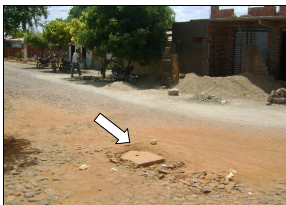
Foto 38 – Registro de manobra localizada na Rua Antonio Edvar Soares Torres, Planalto.
