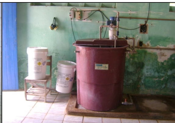
Foto 14 – Dosador de cloro e produtos químicos.
