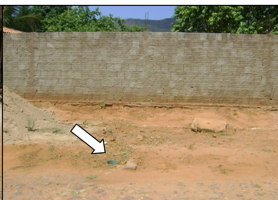
Foto 39 – Registro de manobra localizada na Rua Napoleão Ribeiro Torres, Planalto.
