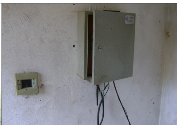
Foto 10 – Quadro de comando da EEPT-04.
