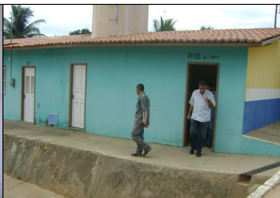
Foto 8 – Prédio de abrigo do PT-03 e do quadro de comando da EEPT-03.
