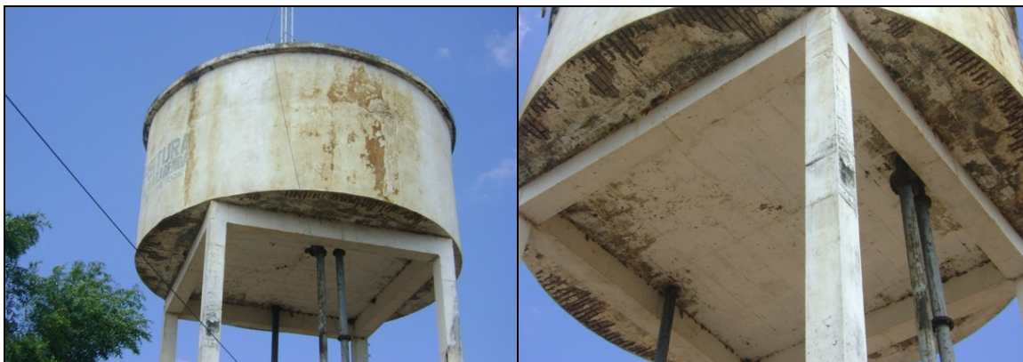
Foto 31 – Armadura exposta e infiltração na laje do REL-01.
