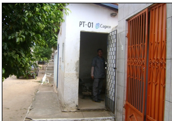
Foto 3 – Prédio de abrigo do PT-01 e do quadro de comando da EEPT-01.
