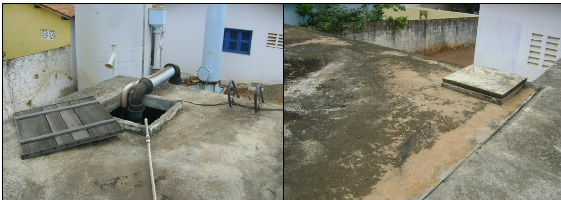
Fotos 28 e 29 – Inspeções do RAP-01.
