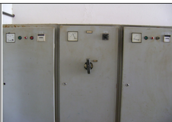
Foto 31 – EELF-01: Quadro de comando.
