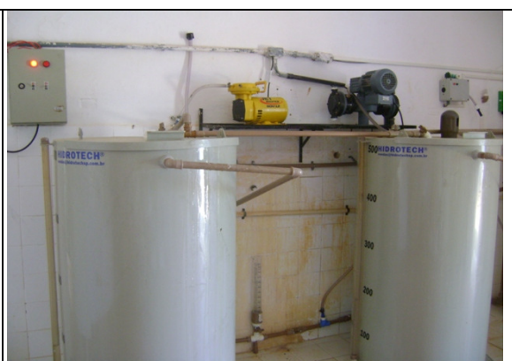
Foto 18 – Tanques de mistura de produtos químicos.
