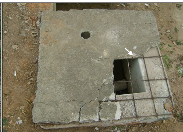
Foto 49 – Registro de descarga apresentando tampa danificada, localizado na Rua Monsenhor Rocha..
