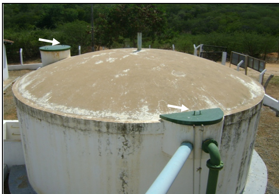
Foto 40 – RAP-01: Tampas de visita e de proteção da caixa de chegada de água tratada adequadas.
