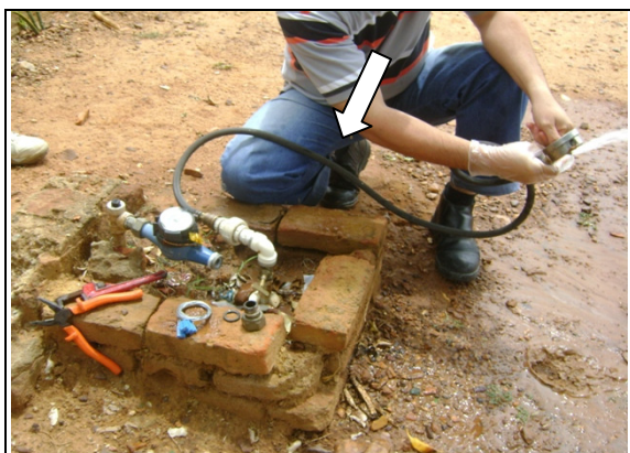
Foto 53 – Medição de pressão na Vila Saraiva, nº 101, antes do hidrômetro.
