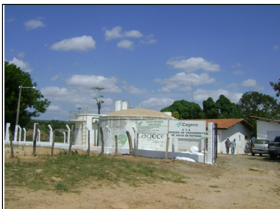
Foto 3 – Vista da ETA.
