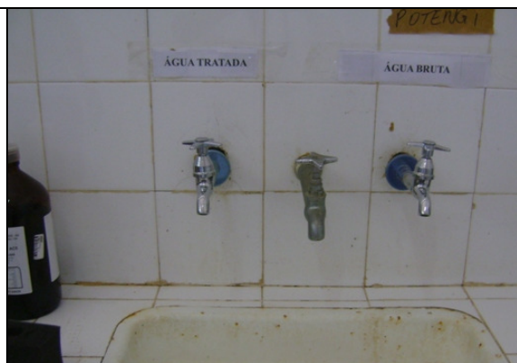
Foto 8 – Laboratório: Torneiras de água bruta e tratada.
