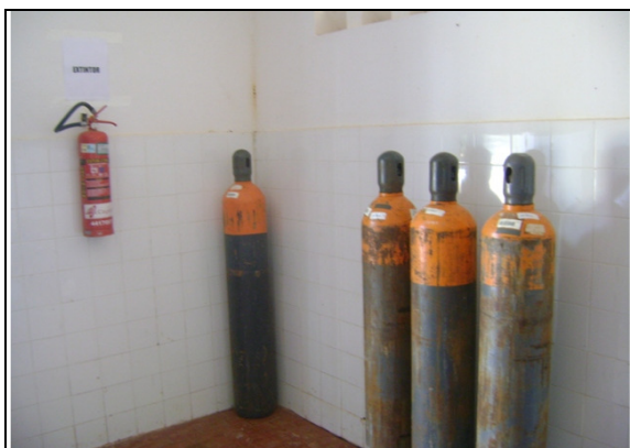
Foto 19 – Extintor de incêndio da ETA e Cilindros de cloro gasoso.
