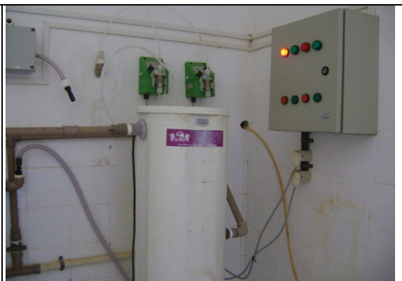
Foto 16 – Dosador de flúor.
