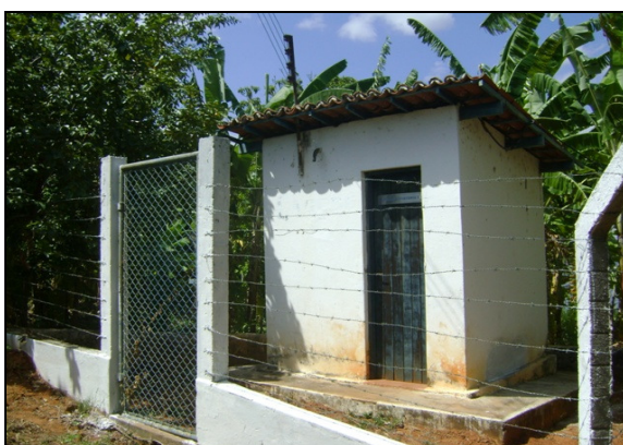
Foto 25 – EECS-01: Sem identificação.
