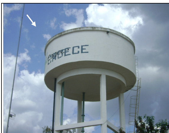
Foto 44 – REL-02: Pintura deteriorada e sem sinalizador noturno, para-raio e guarda-corpo na laje cobertura.
