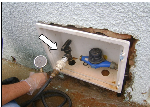
Foto 52 – Medição de pressão na Rua 102, nº 49 - Bairro Populares, antes do hidrômetro.
