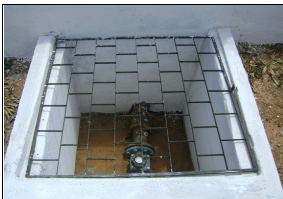
Foto 22 – Macromedidor de água tratada, localizado na saída da EEAT-01.
