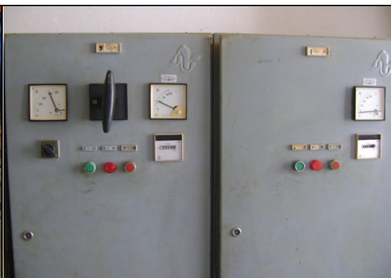
Foto 29 – EEAT-01: Quadro de comando.
