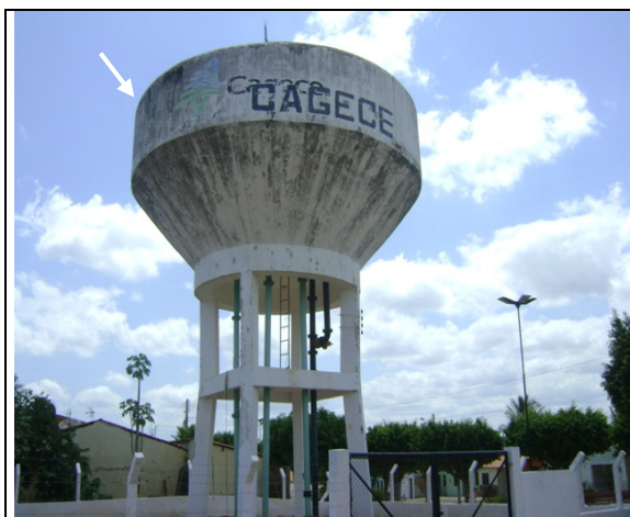
Foto 41 – REL-01: Pintura deteriorada.
