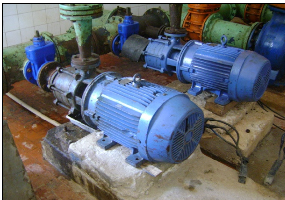
Foto 28 – EEAT-01: Conjuntos moto-bomba.
