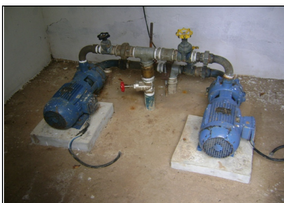
Foto 36 – EERD-02: Conjuntos moto-bomba.
