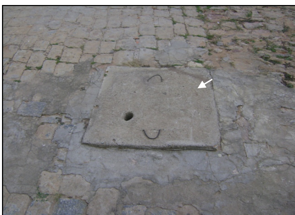
Foto 46 – Registro de descarga localizado na Rua Francisco Guedes.
