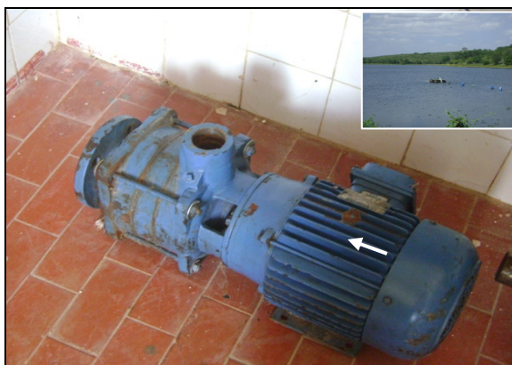
Foto 27 – EECS-01: Conjunto moto-bomba reserva, localizada na ETA.
