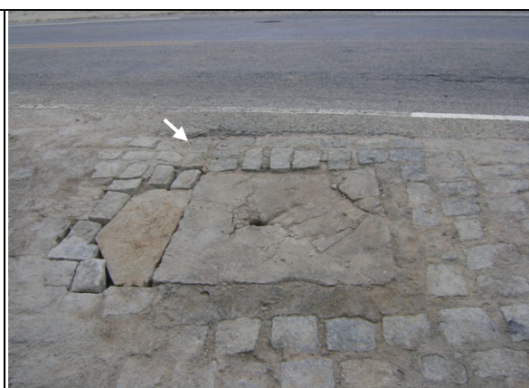
Foto 47 – Registro de descarga localizado na Rua Monsenhor Rocha.
