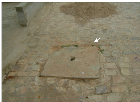
Foto 50 – Registro de descarga localizado na Rua Sargento Dudu.
