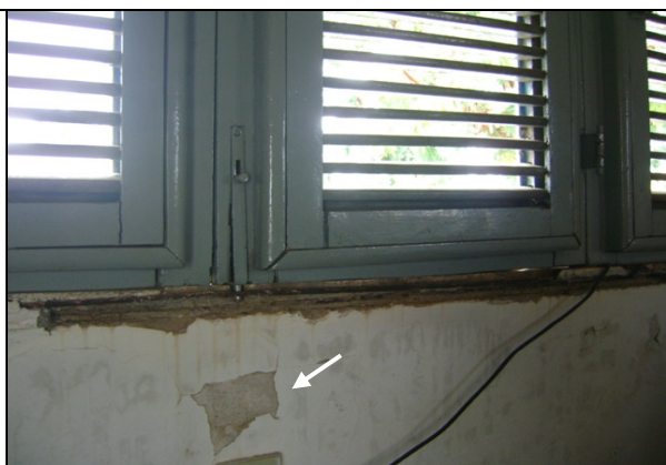
Foto 57 – Parede com revestimento danificado.
