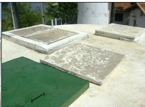
Foto 6 – Filtro 01: Tampas de inspeção adequadas.
