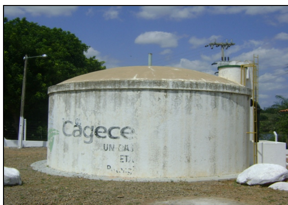
Foto 38 – RAP-01: Pintura deteriorada.
