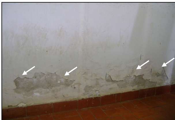
Foto 58 – Parede com revestimento danificado.
