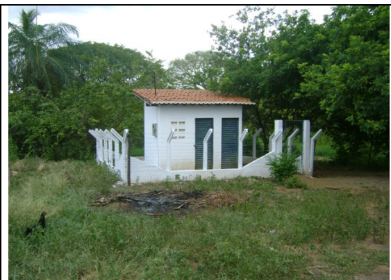
Foto 35 – EERD-02 ( Booster ): Sem identificação.
