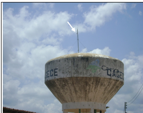
Foto 43 – REL-01: Sem sinalizador noturno.
