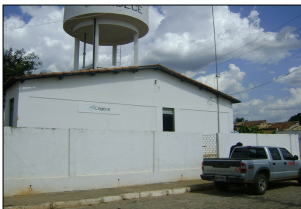
Foto 54 – Vista externa do escritório/loja de atendimento ao usuário.
