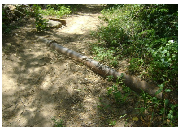
Foto 24 – Adutora de água tratada exposta devido à ação da erosão.
