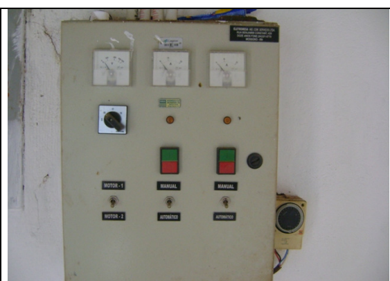
Foto 37 – EERD-02: Quadro de comando.
