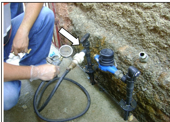
Foto 51 – Medição de pressão na Rua Sargento Dudu, nº 437, antes do hidrômetro.
