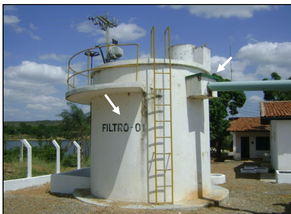
Foto 5 – Filtro: Existência de identificação e tampa de proteção na caixa de saída da água tratada.
