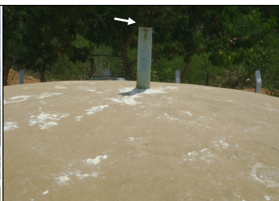
Foto 39 – RAP-01: Tubulação de ventilação inadequada.
