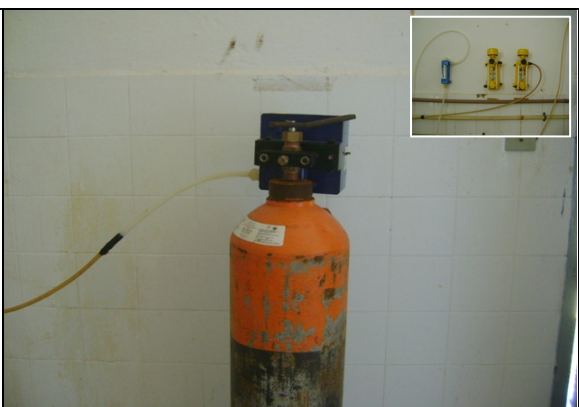
Foto 20 – Dosador de cloro gasoso.
