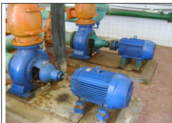
Foto 30 – EELF-01: Conjunto moto-bomba.
