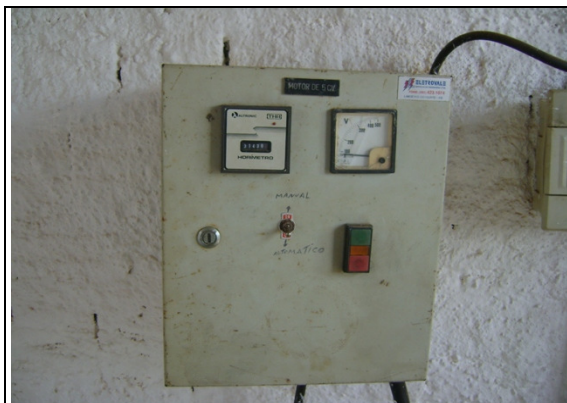
Foto 34 – EERD-01: Quadro de comando.
