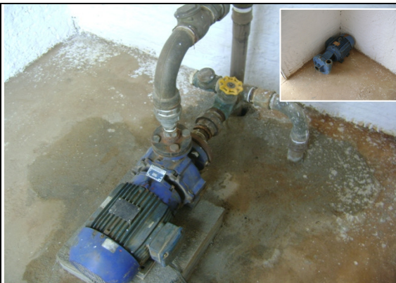
Foto 33 – EERD-01: Conjunto moto-bomba com reserva no local.
