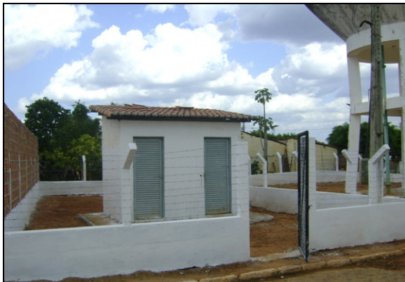
Foto 32 – EERD-01 ( Booster ): Sem identificação.
