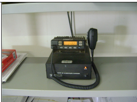
Foto 4 – Rádio da ETA.
