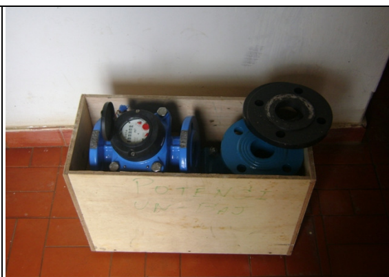
Foto 23 – Macromedidor a ser instalado na adutora de água tratada.
