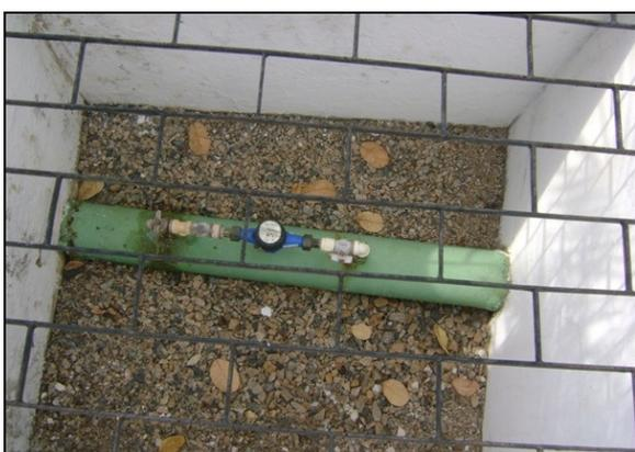
**Foto 46** – Medidor proporcional de água tratada na saída da EEAT-02.
