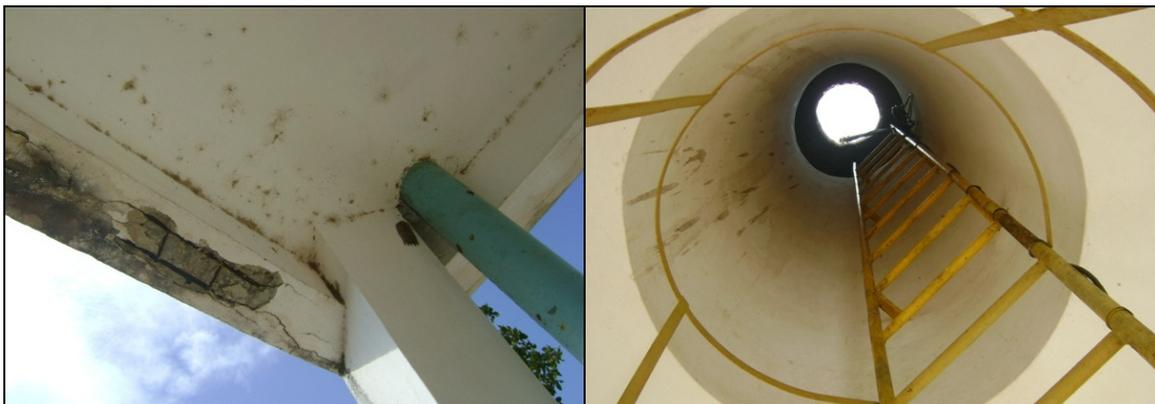
**Foto 41** – Estrutura deteriorada com armadura exposta, do REL-01.
