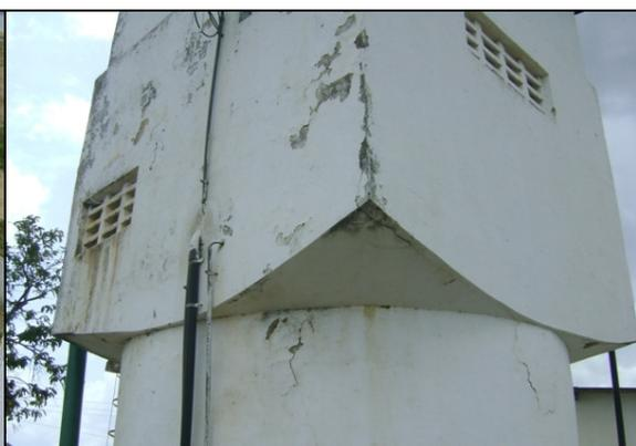
Foto 23 – Poço de reunião, com reboco e pintura deteriorados.
