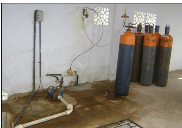
**Foto 10** – Cilindros e dosador de cloro gasoso.
