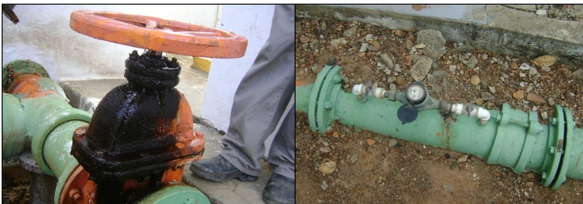
**Foto 6** – Registro de descarga de fundo e de lavagem do filtro 01 com problema de vedação.
