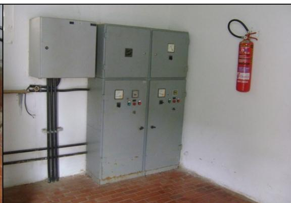
Foto 28 – Quadro de comando e extintor de incêndio da EEAT-01.
