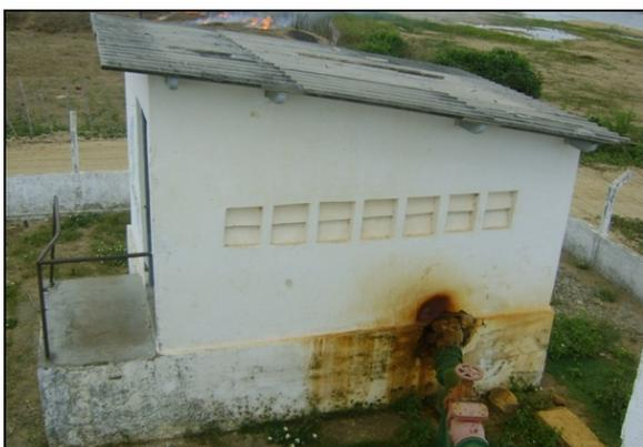
Foto 22 – Prédio de abrigo da EEAB-01, com pintura deteriorada e guarda-corpo danificado.
