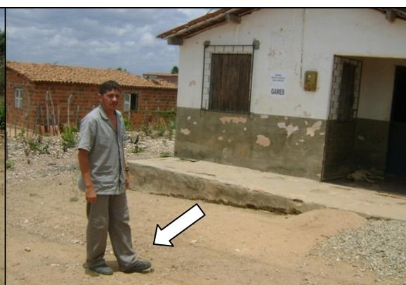
**Foto 52** – Registro de descarga sem caixa de proteção, localizado na Rua Alto Alegre, Alto Alegre.
