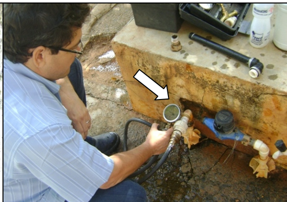
Foto 47 – Medição de pressão na Rua da Jurema, 178 – Acampamento, sem hidrômetro.
