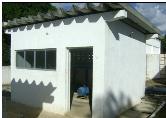
Foto 23 – Prédio de abrigo das elevatórias EECS-01 e da EEAT-01, sem identificação.
