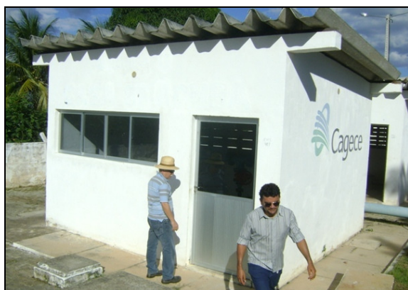
Foto 27 – Prédio de abrigo da EEAT-02, sem identificação.
