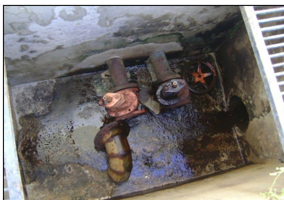
Foto 5 – Problema de vedação no registro de descarga dos decantadores.
