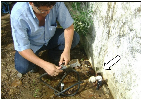
Foto 46 – Medição de pressão na Rua Antônio de Oliveira, 1.167 – Centro, sem hidrômetro.
