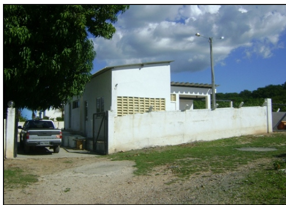
Foto 2 – Entrada da ETA.
