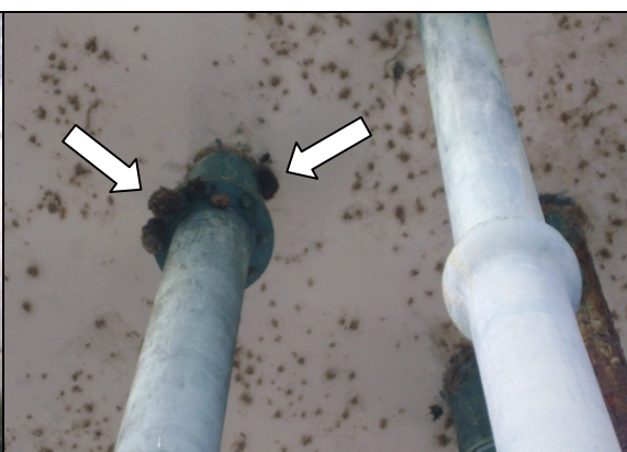
Foto 37 – Presença de vespas na laje de fundo do REL-01.
