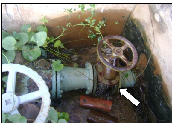
Foto 36 – Vazamento no registro de descarga do REL-01.
