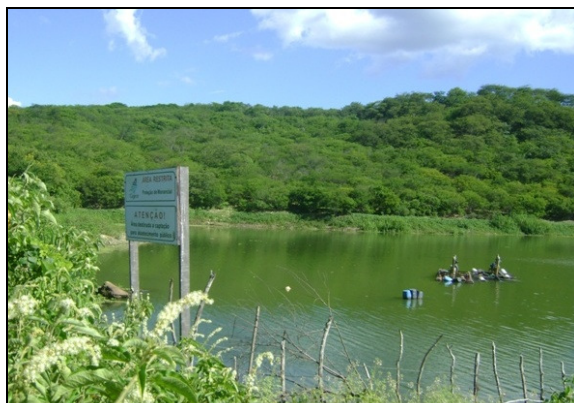
Foto 1 – Vista do flutuante e da sinalização da captação.
