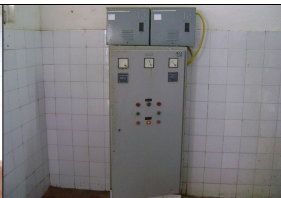
Foto 29 – Quadro de comando da EERD-01.
