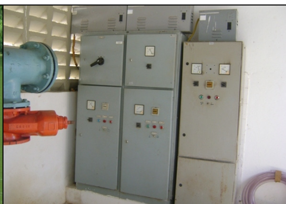
Foto 22 – Quadros de comando das elevatórias EECS-01 e EEAT-01.
