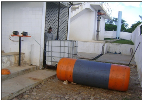
Foto 12 – Cilindros e dosador de cloro gasoso.
