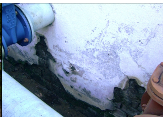
Foto 31 – Reboco externo do prédio de abrigo da EERD-01, deteriorado.
