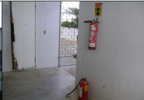
Foto 9 – Extintores de incêndio da casa de química.
