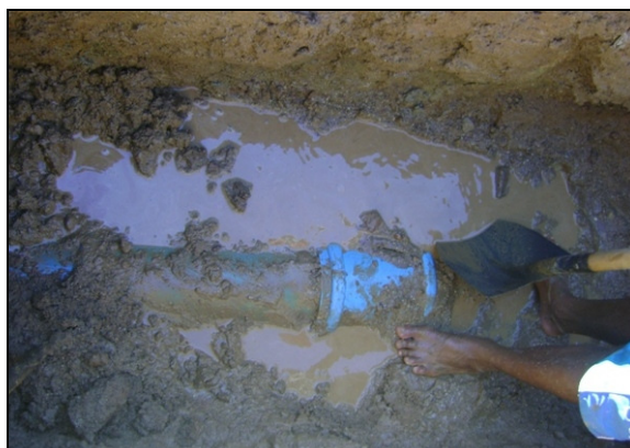
Foto 42 – Vazamento na adutora de água tratada, próximo à ETA.
