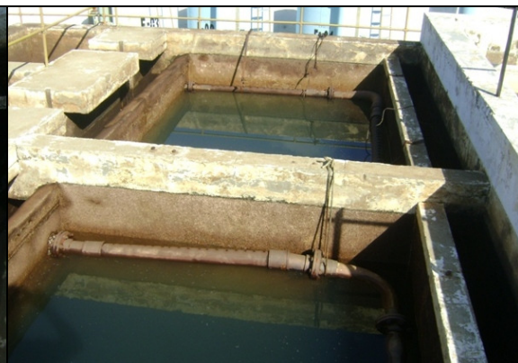
Foto 4 – Vista dos decantadores.
