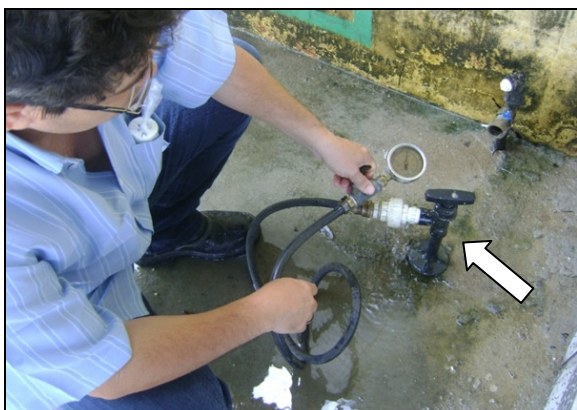
Foto 48 – Medição de pressão na Av. Senador Virgílio Távora, FNS 9 – Várzea da Paz, sem hidrômetro.
