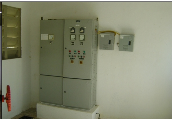
Foto 26 – Quadro de comando da EEAT-02.
