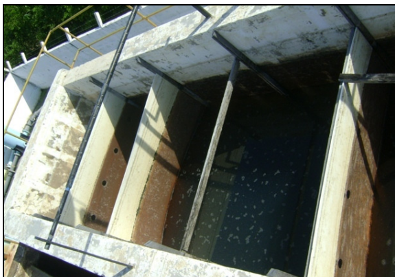
Foto 3 – Vista dos flocculadores.
