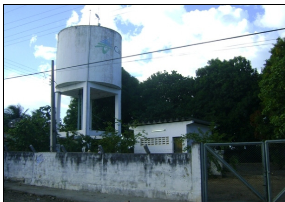
Foto 35 – Vista do REL-01.
