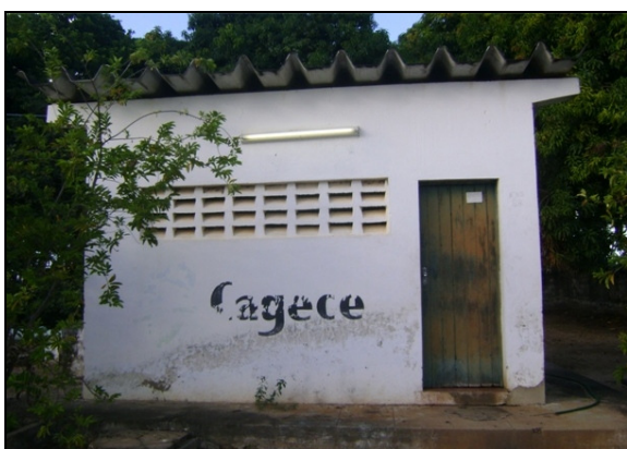
Foto 30 – Prédio de abrigo da EERD-01.
