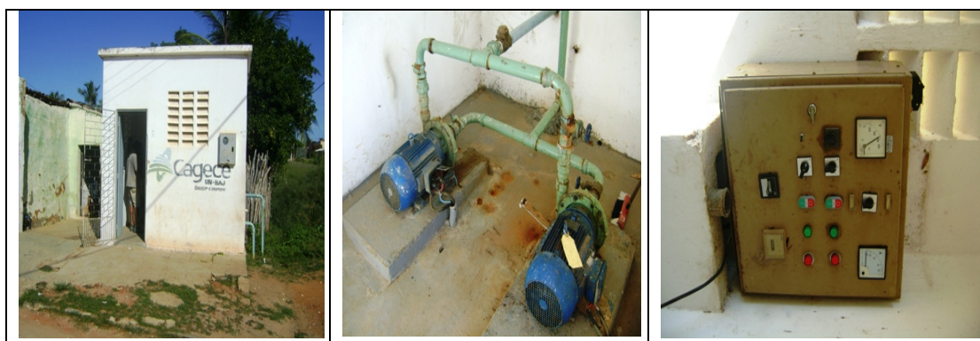
Fotos 31, 32 e 33 – Booster Vila Moreira - casa de abrigo, conjuntos motores-bomba e quadro de comando
