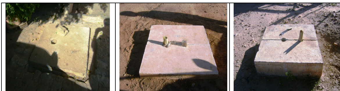
Fotos 55, 56 e 57 – Registros de descarga nas Av. Tancredo Neves, Av. Palmeira e Vila Brito
