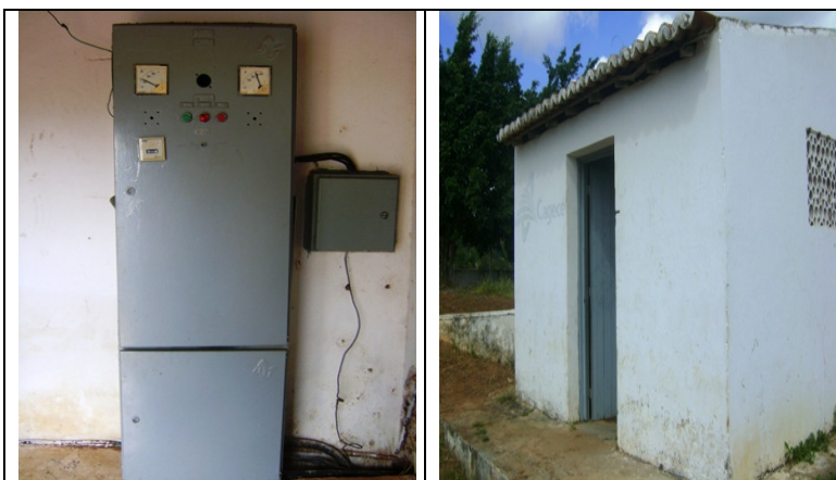
Fotos 22 e 23 – EECS-01 – quadro de comando e sua casa de abrigo
