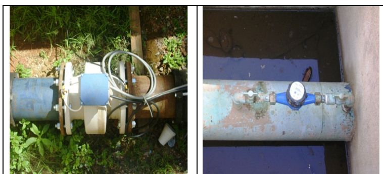
Fotos 50 e 51 – Macromedidores na saída do RSE-01
