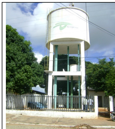
Foto 42 – Vista do REL-01
