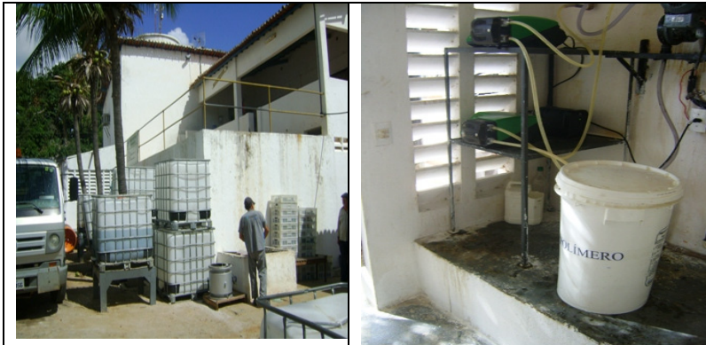
Fotos 12 e 13 – Armazenamento inadequado de produtos químicos
