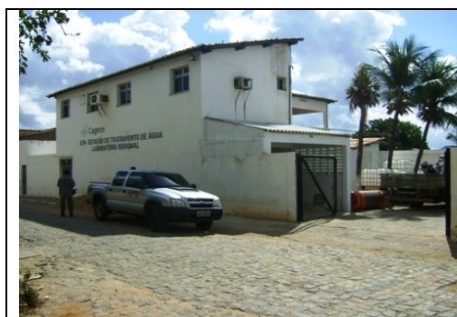
Foto 6 – Vista da entrada da ETA do SAA de Acopiara
