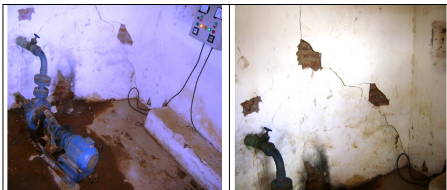
Fotos 34 e 35 – Booster Nova Acopiara – instalações precárias
