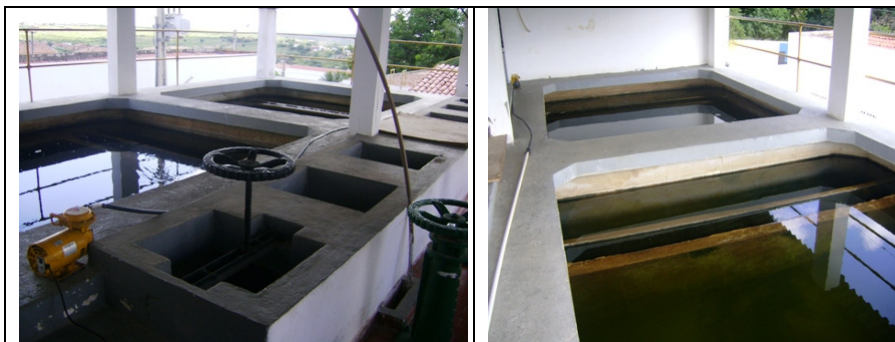
Fotos 8 e 9 – Vistas dos filtros
