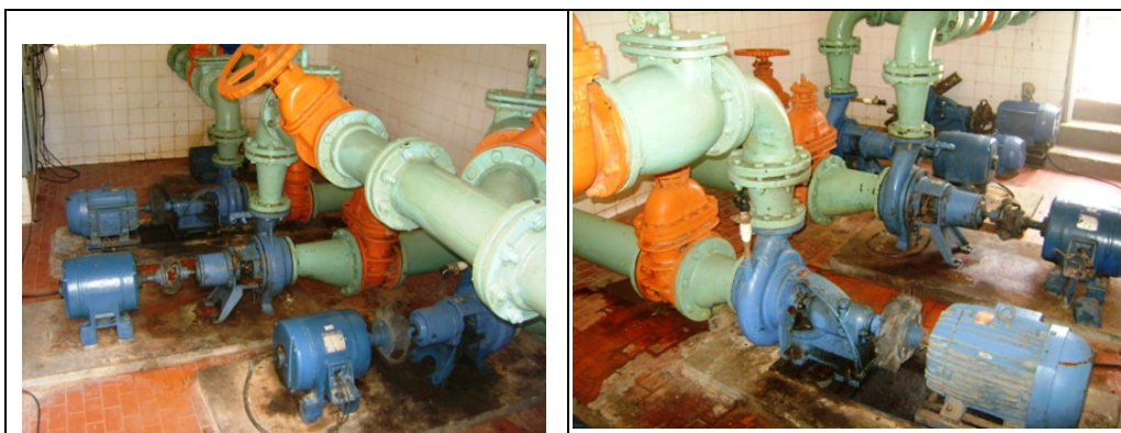
Fotos 24 e 25 – EEAT-01 e EEAT-02 – detalhes dos conjuntos motores-bomba
