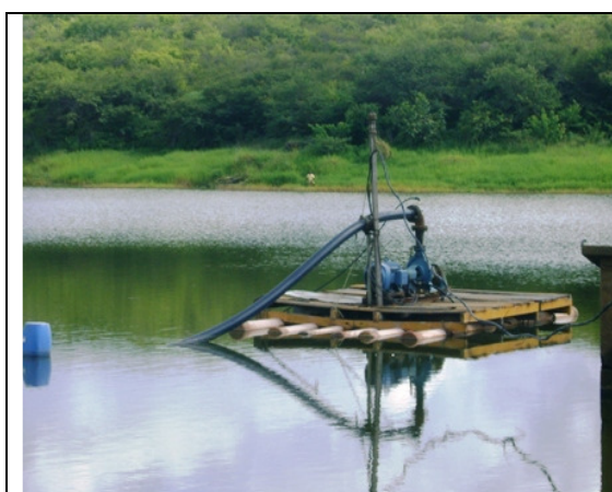
Foto 1 – Detalhe do flutuante
