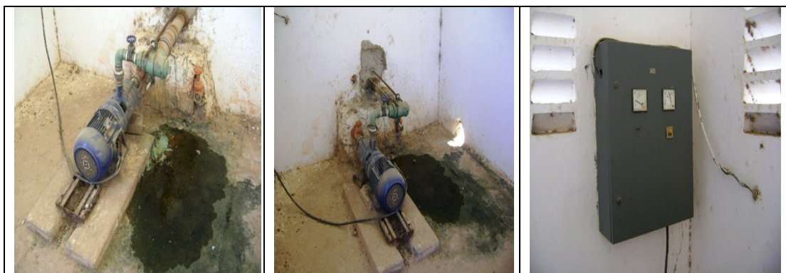
Fotos 36, 37 e 38 – Booster Vila Esperança - instalações precárias
