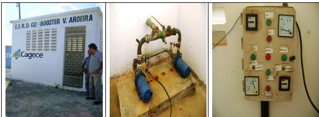
Fotos 28, 29 e 30 – Booster Vila Aroeira - casa de abrigo, conjuntos motores-bomba e quadro de comando
