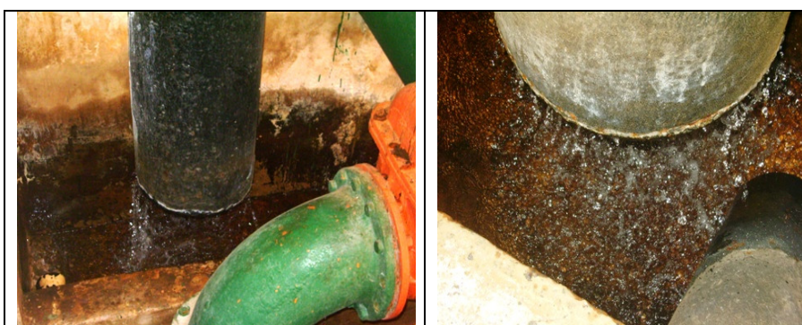
Fotos 10 e 11 – Registros com vazamentos
