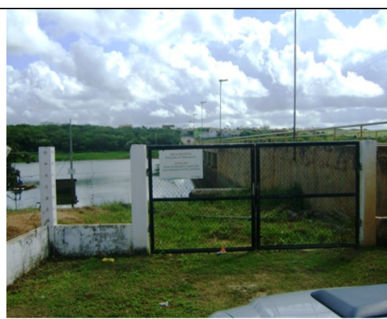
Foto 2 - Vista da entrada da área da captação com a placa de sinalização
