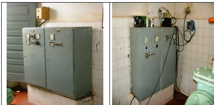
Fotos 26 e 27 – EEAT-01 e EEAT-02 – quadros de comando
