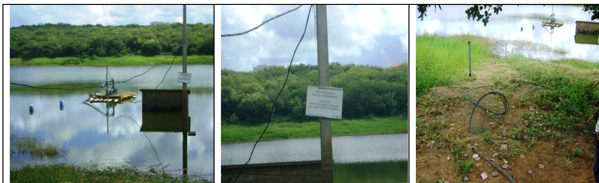
Fotos 3, 4 e 5 – Área da captação – instalações elétricas com fiação exposta
