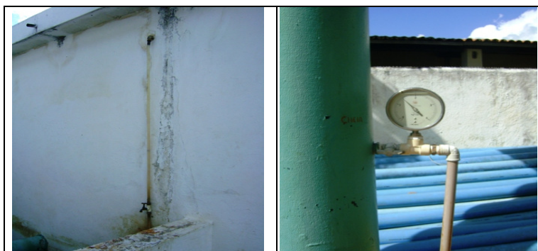
Fotos 48 e 49 – Dispositivos de medição de nível no RAP-01 e REL-01
