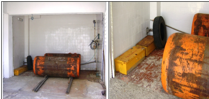
Fotos 14 e 15 – Cilindros de cloro e o kit de emergência
