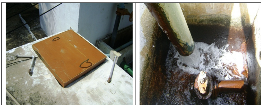
Foto 35 – Vista superior do RAP-01
