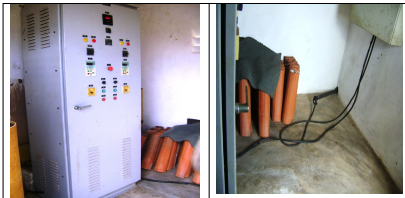
Fotos 27 e 28 – EECS-01 – Quadro de comando com fiação exposta
