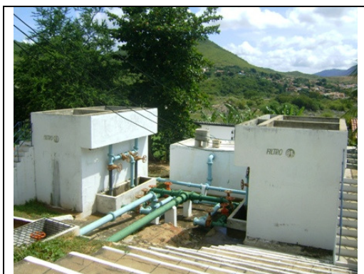
Foto 6 – Vista dos filtros
