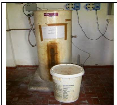
Foto 16 – Sistema de fluoretação
