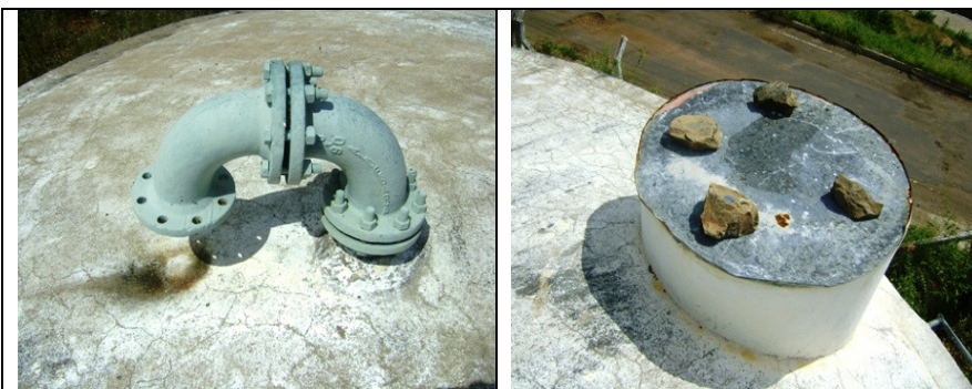
Fotos 38 e 39 – Vistas superiores do RAP-02
