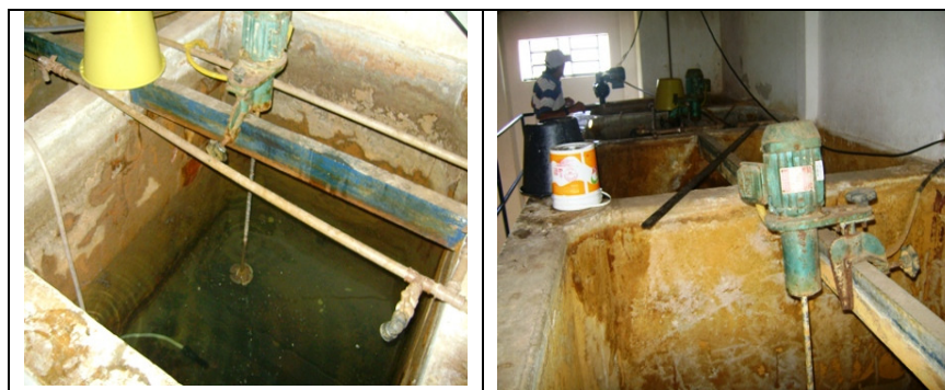
Fotos 17 e 18 – Tanques dosadores
