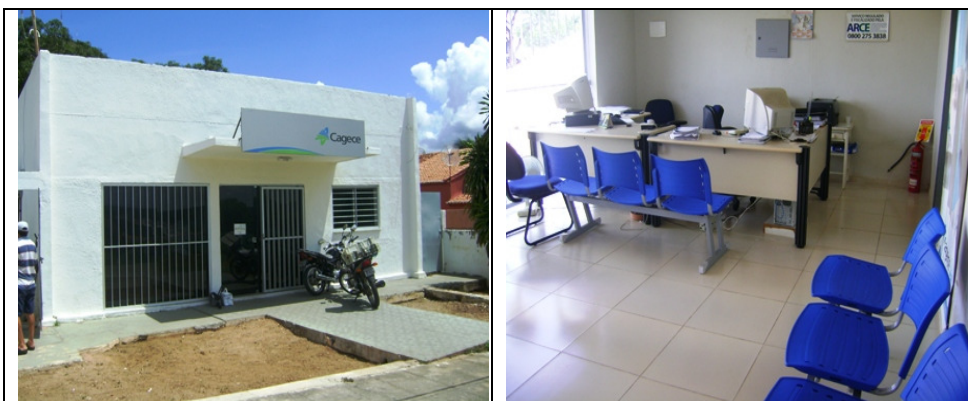
Fotos 49 e 50 – Vistas externa e interna do Escritório
