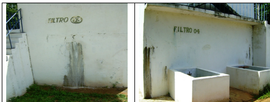
Fotos 9 e 10 – Detalhes dos filtros 03 e 04
