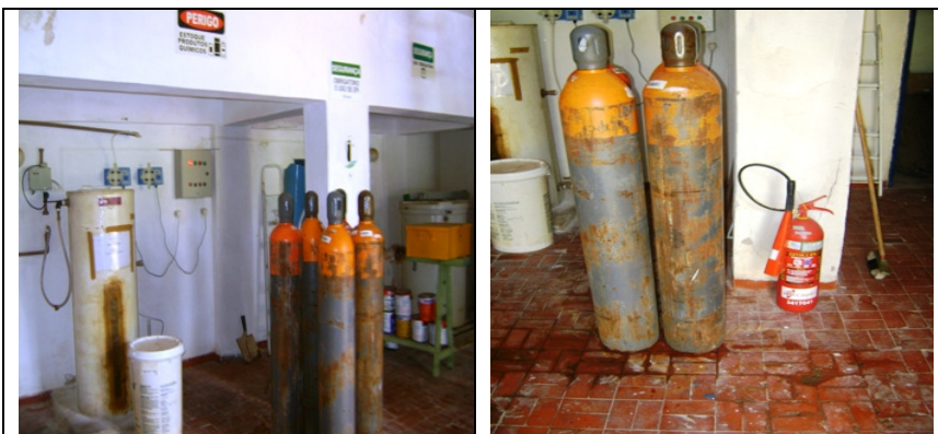
Fotos 14 e 15 – Cilindros de cloro gasoso e extintor de incêndio em local inadequado
