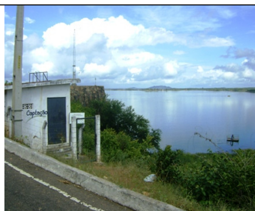
Foto 2 – Vista da área da captação
