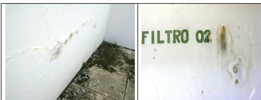
Fotos 7 e 8 – Detalhes dos filtros 01 e 02
