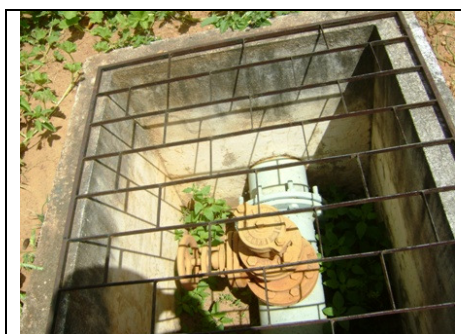
Foto 45 – Ventosa na adutora de água tratada
