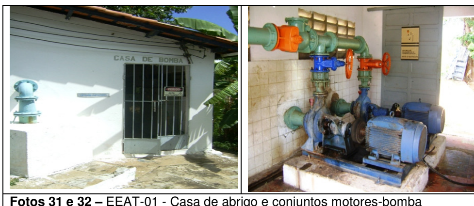
Fotos 31 e 32 – EEAT-01 - Casa de abrigo e conjuntos motores-bomba
