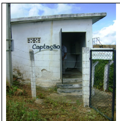
Foto 26 – EECS-01 – Casa de abrigo do quadro de comando
