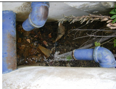
Foto 43 – Vazamento na tubulação de descarga
