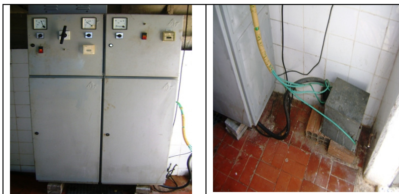
Fotos 29 e 30 – EEAT-01 - Quadro de comando com fiação exposta
